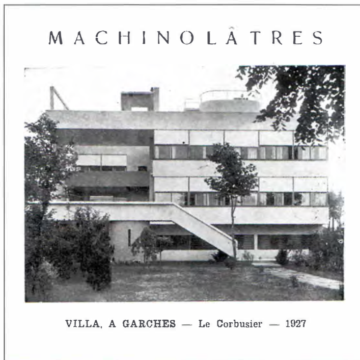
Arriba: Le Corbusier. Villa Stein en Garches (1927). Fotografía publicada en páginas centrales de La Machinolatrie bajo el epíteto de "Maquinólatras" Izq.: Ángel Guido. La Machinolatrie de Le Corbusier . Rosario; 1930. Tapa del libro. La adoración por la máquina es retratada con ironía en las viñetas dibujadas por Guido
