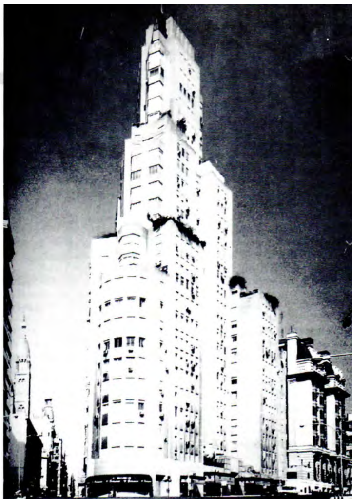
Edificio Kavanagh, Florida 1035, Arqs. Sánchez, Lagos y de la Torre (Foto Julio Cacciatore)
