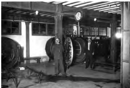
Figura 5.24: Interior de la Estación de Desinfección del Dique 4, 1925. Pueden verse equipos similares a los instalados en las estaciones urbanas. Archivo: AGN, caja 726, n°140310.
