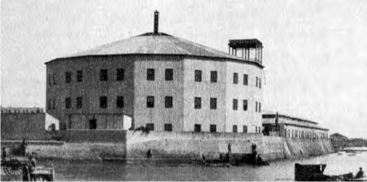
Figura 3.20: Hotel de Inmigrantes provisorio de Retiro. Pueden verse el edificio existente que funcionaba como panorama y el nuevo edificio en el que se encontraban las áreas de servicio (c.1890). Archivo: AGN, Fondo Witcomb, caja 9, inv:186.
