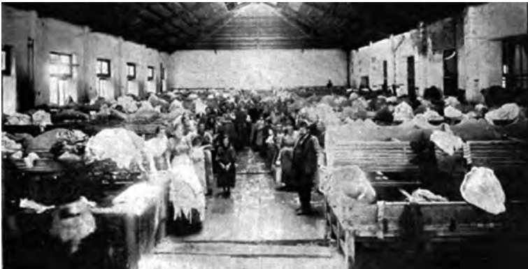
Figura 4.11: Departamento de lavado del lavadero municipal ubicado en French y Centro América. Fuente: Caras y Caretas (1899, 28 de octubre), Año II, N°56: 22.
