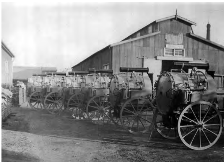
Figura 5.31: Aparatos de desinfección móviles en el Parque Sanitario del DNH. Archivo: AGN, caja 726, n°140323.
