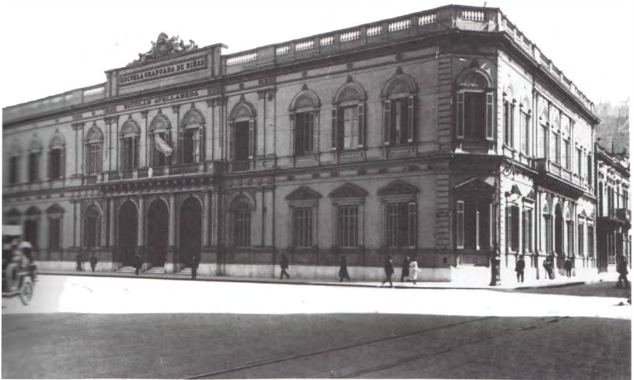
Escuela Nicolás Avellaneda (1885) (Demolida) Francisco Tamburini, arq. Talcahuano 678, Buenos Aires. Fuente: AGN
