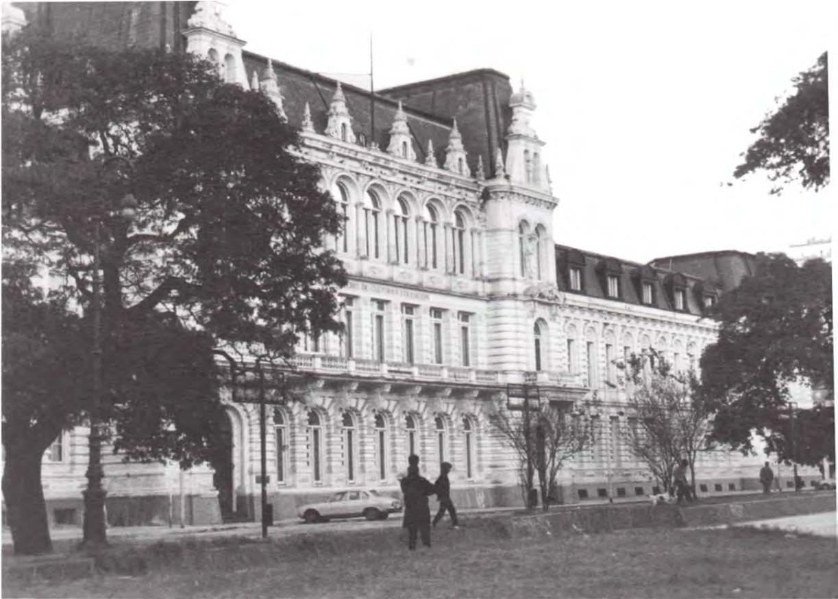
Escuela Petronila Rodríguez Estado Actual.
