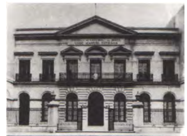
Escuela de Catedral al Norte Fachada del nuevo edificio, réplica del diseño original. Fuente:AGN
