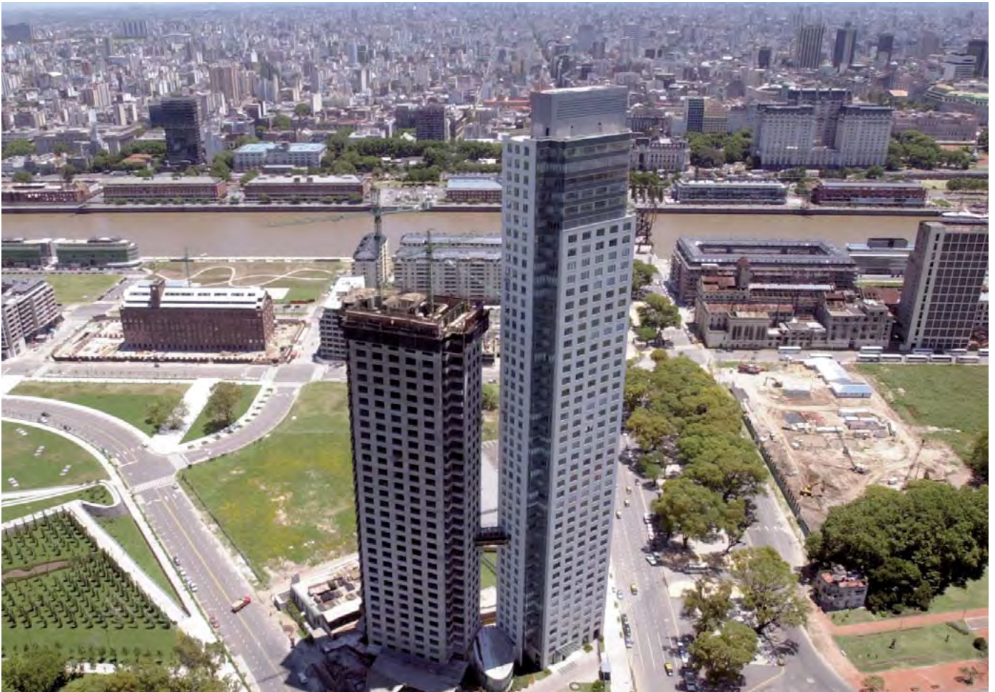
► VISTA DE LAS TORRES EL FARO DEL ESTUDIO DUJOVNE - HIRSH, EN CONSTRUCCIÓN EN EL ÁREA ESTE DE PUERTO MADRO, BUENOS AIRES.
