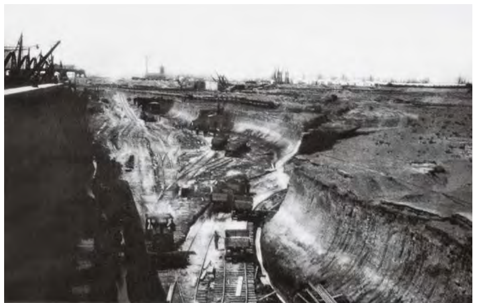
► OBRAS DE CONSTRUCCIÓN DEL PUERTO DE BUENOS AIRES, ACTUAL PUERTO MADERO.
