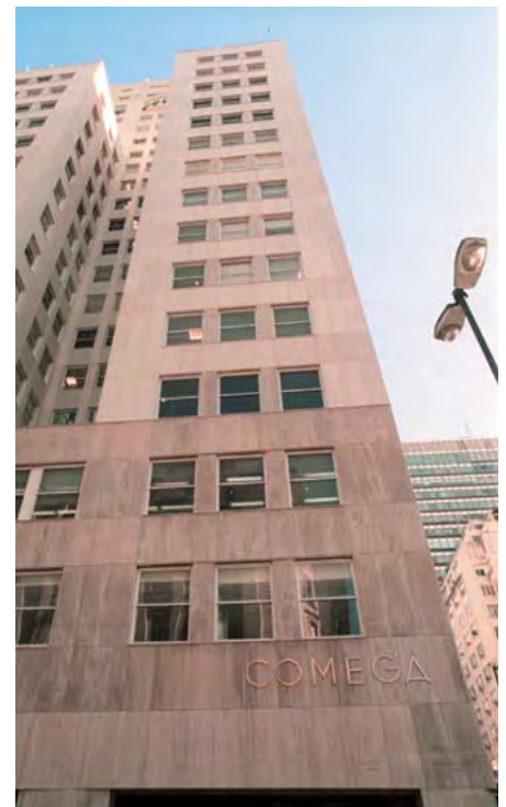
► EDIFICIO COMEGA EN LA AV. CORRIENTES EN BS. AS.
