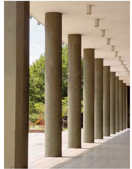
► PILOTIS EN EL MINISTERIO DE OBRAS PÚBLICAS, LA PLATA.
