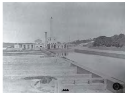
► PILETAS DE DEPÓSITOS DE ASIENTO DE OSN.
