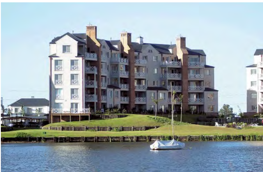
► VIVIENDAS EN CONDOMINIO EN LA CIUDAD PUEBLO NORDELTA, TIGRE PROVINCIA DE BUENOS AIRES.
