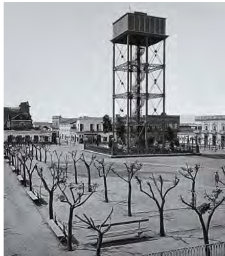
► TANQUE DE DISTRIBUCIÓN DE AGUA EN LA ANTIGUA PLAZA LOREA (ACTUAL PLAZA DEL CONGRESO), DE BUENOS AIRES.
