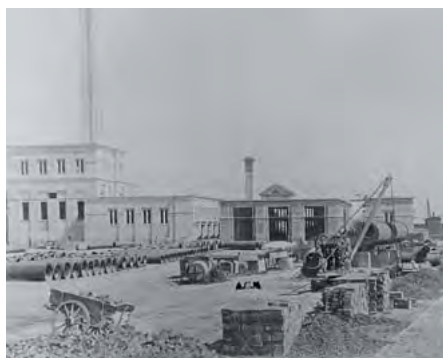
► DEPÓSITOS DE OBRAS SANITARIAS DE LA NACIÓN EN OBRA.
