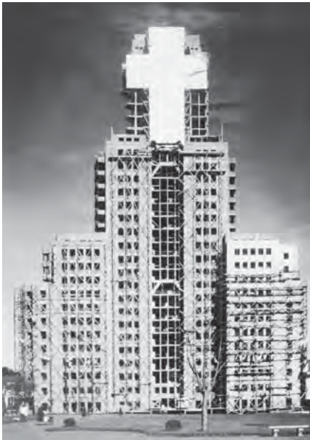
► EDIFICIO KAVANAGH EN OBRA DURANTE EL CONGRESO EUCARÍSTICO. AUTORES: SÁNCHEZ, LAGOS Y DE LA TORRE.
