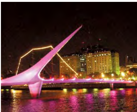
► PUENTE DE LA MUJER, EN PUERTO MADERO, DE CALATRAVA.
