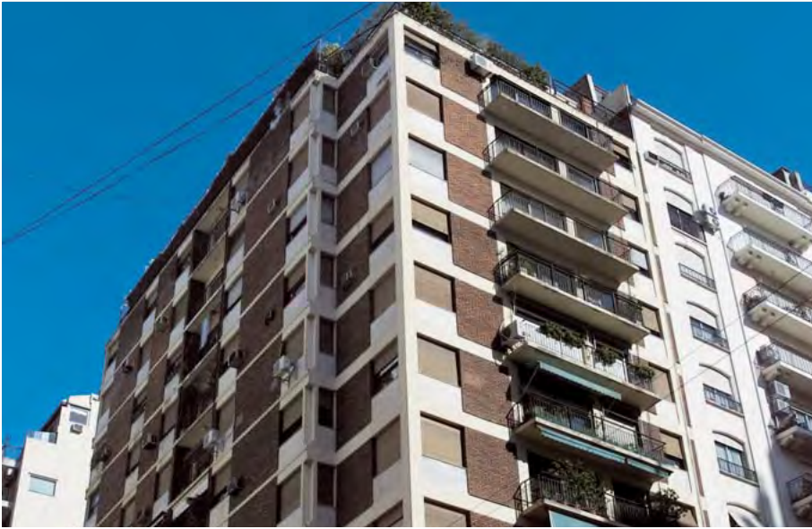
► DETALLE DEL EDIFICIO DE VIVIENDAS DE ALVEAR Y AYACUCHO, EN BUENOS AIRES.
