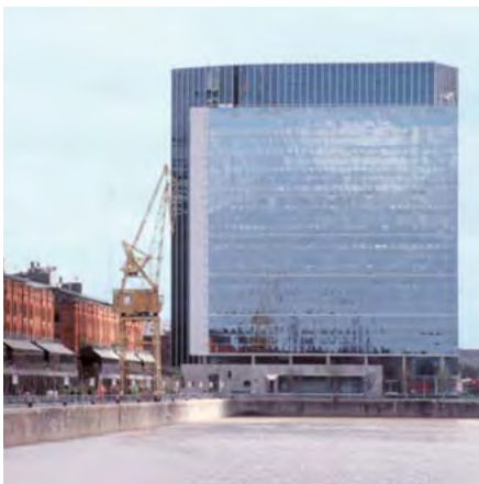
► EDIFICIO TELECOM, EN PUERTO MADERO, BS. AS.
