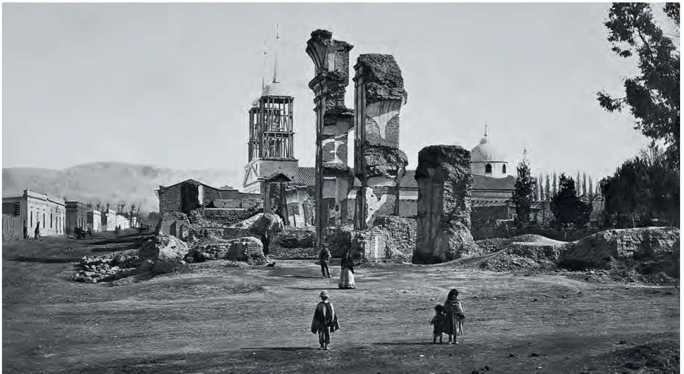
► RUINAS DE LA IGLESIA DE S. DOMINGO, EN EL CASCO FUNDACIONAL DE MENDOZA, DESTRUIDO POR EL TERREMOTO DE 1861.
