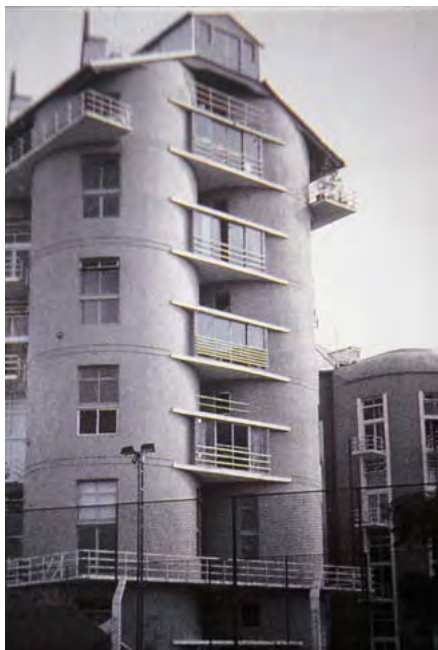
► LOS SILOS DE DORREGO, EN BUENOS AIRES.
