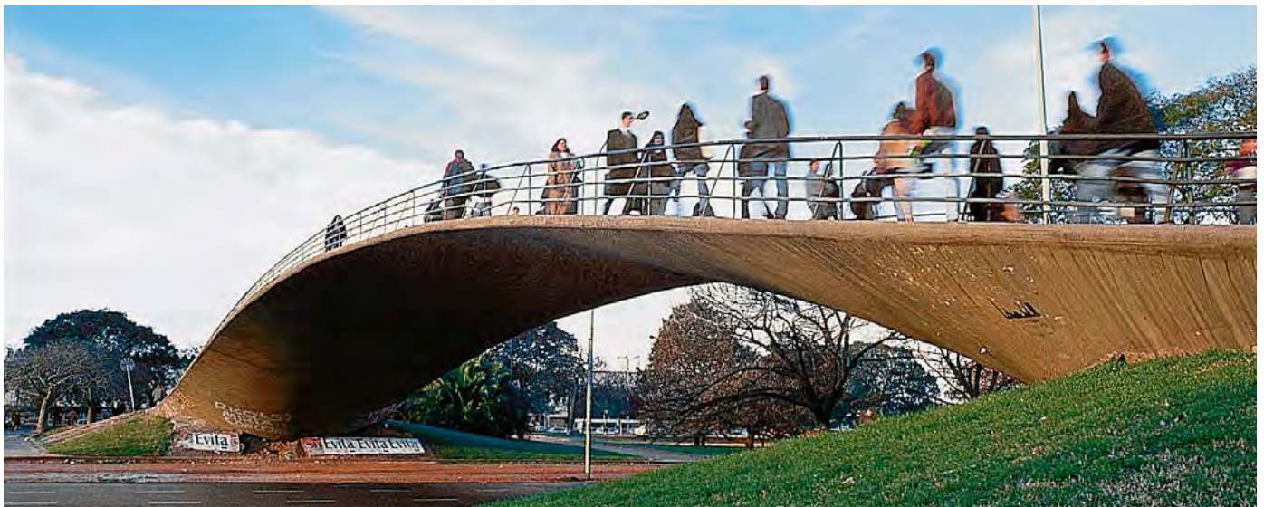
► LA LEVEDAD DE LA MEMBRANA DELGADA DEL PUENTE PEATONAL, DE C. JANNELLO Y S. GRICHENER, PERMITE DILUIR VISUALMENTE LA ESTRUCTURA EN LA CONTINUIDAD ORGÁNICA DEL PARQUE.
