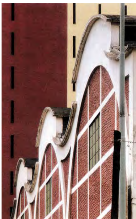
► USO DEL HORMIGÓN Y LADRILLO EN EL MERCADO DE SAN CRISTÓBAL, EN BUENOS AIRES, DEL ESTUDIO SEPPA.
