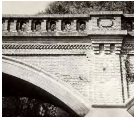
► EL LADRILLO EN LA TRADICIÓN FUNCIONAL BRITÁNICA: EN ESTE CASO, EN LA BASE DE UN PUNTE FERROVIARIO.
