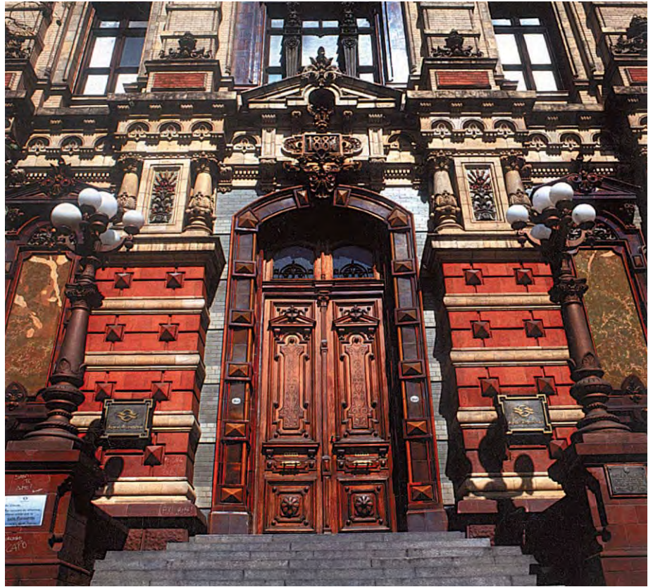
► PALACIO DE AGUAS CORRIENTES SOBRE LA AVENIDA CÓRDOBA, BS. AS., REALIZADO POR CARLOS NYSTRÖMER.
