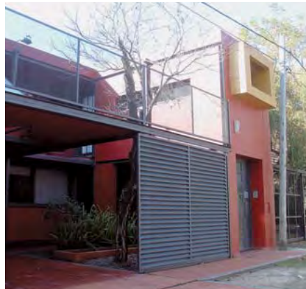
► CASA UNIFAMILIAR, EN TOLOSA, DE GUSTAVO ASPIAZU.
