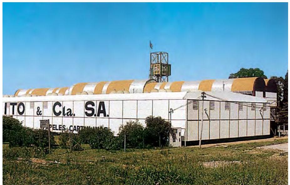
► FÁBRICA KOCH POLITO, SOBRE LA AUTOPISTA PANAMERICANA, DE BAUDIZZONE, DÍAZ, ERBIN, LESTARD, VARAS.
