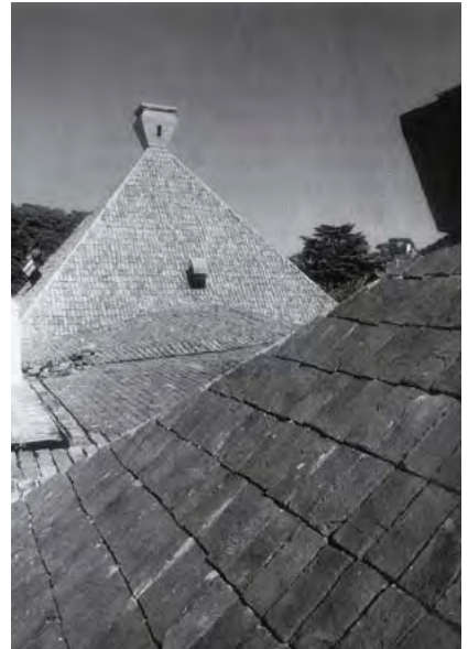
► ARRIBA: IGLESIA DE NUESTRA SEÑORA DE FÁTIMA, EN MARTÍNEZ, BS. AS., DE CAVERI Y ELLIS. DETALLE DE LOS TECHOS, CON REVESTIMIENTO LADRILLERO. FÁTIMA ES UNA DE LAS OBRAS MÁS CONOCIDAS DENTRO DEL MOVIMIENTO DE LAS "CASAS BLANCAS".
