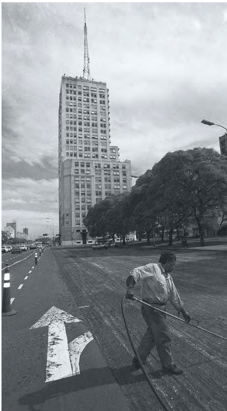
► EX MINISTERIO DE OBRAS PÚBLICAS DE LA NACIÓN (ACTUALMENTE, DE SALUD PÚBLICA Y ACCIÓN SOCIAL), EN BUENOS AIRES.
