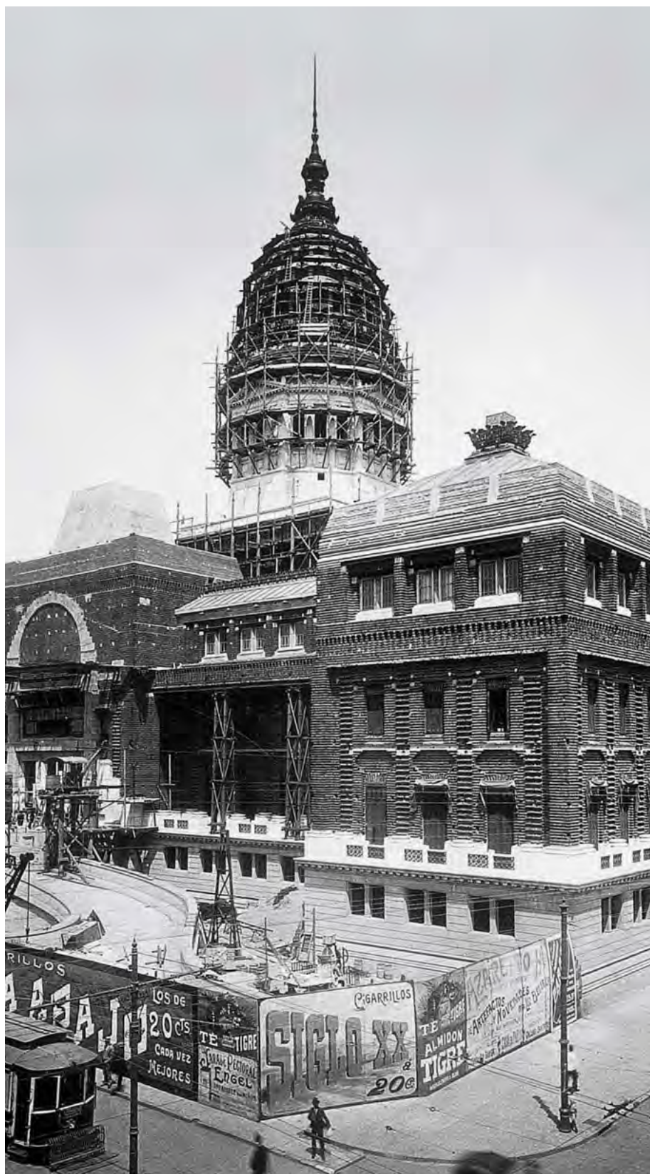
► EL PALACIO DEL CONGRESO, EN CONSTRUCCIÓN.
