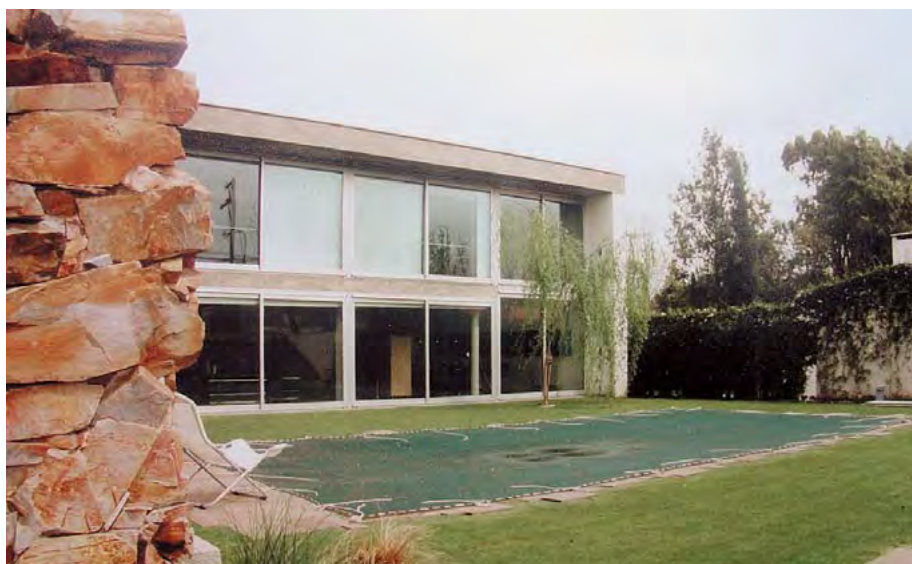
► LA CASA EN GONNET, DE GINO RANDAZZO, CONJUGA ELEMENTOS DE LAS ARQUITECTURAS DE MIES, LE CORBUSIER Y WRIGHT.
