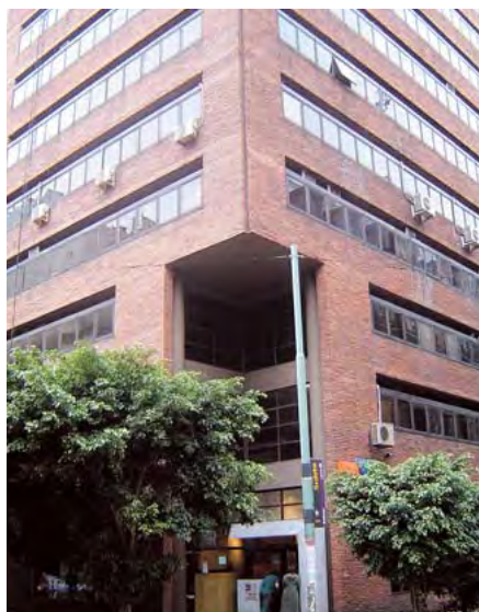
► EL LADRILLO COMO PIEL EN LA TORRE DE OFICINAS DE BOLÍVAR Y MORENO, BUENOS AIRES., DE MSGSSV.
