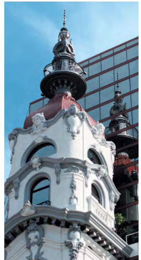
► EDIFICIO ART NOUVEAU EN BS. AS., DE A. MASSÛE. FUE REMODELADO Y SOLO SE CONSERVÓ LA TORRE ESQUINERA.
