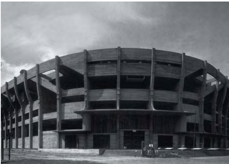
► EL ESTADIO LA BOMBONERA, DEL CLUB BOCA JUNIORS, DISEÑO Y CÁLCULO ESTRUCTURAL DE J. DELPINI, EN 1923.
