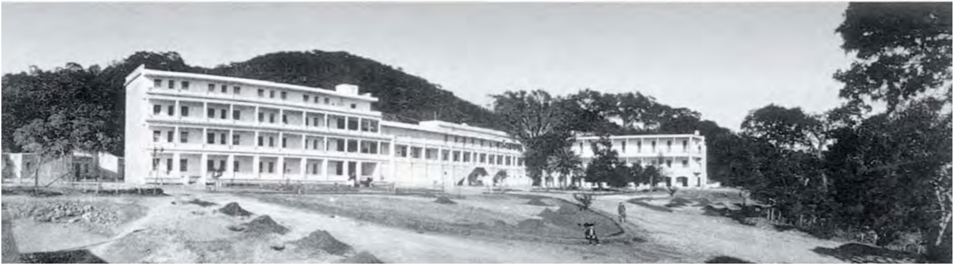
► HOTEL TERMAS, EN ROSARIO DE LA FRONTERA, SALTA. AL COMPLETARSE, EN 1935, CONTABA CON JARDINES DE INVIERNO, SALÓN DE FIESTAS Y CINE, ADEMÁS DEL PABELLÓN DE BAÑOS.
