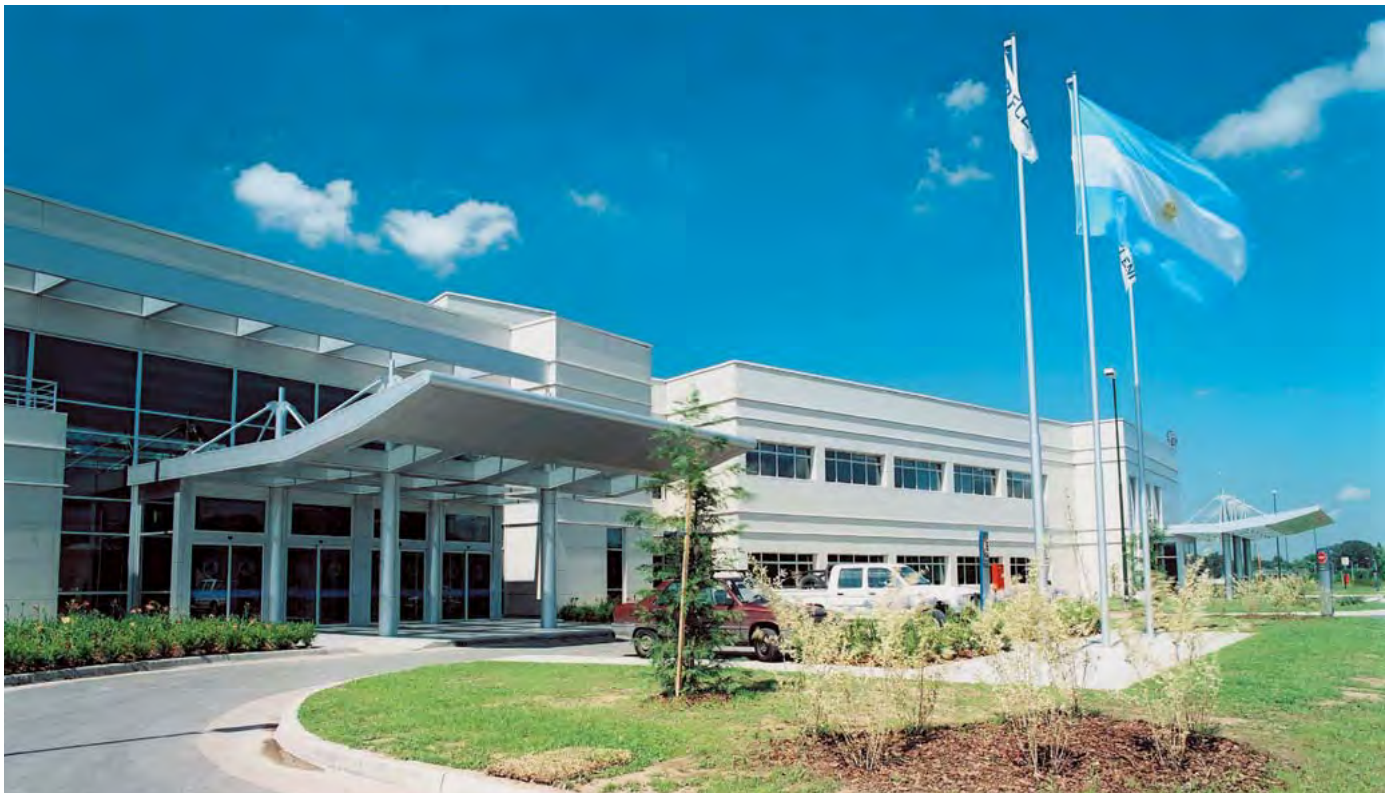
► INSTITUTO DE REHABILITACIÓN Y EDUCACIÓN TERAPÉUTICA DE FLENI, EN ESCOBAR, PROVINCIA DE BUENOS AIRES, PROYECTADA Y CONSTRUIDA POR SADE SKANSKA.
