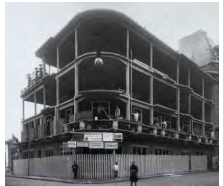
► TÍPICA ESTRUCTURA DE HORMIGÓN ARMADO.
