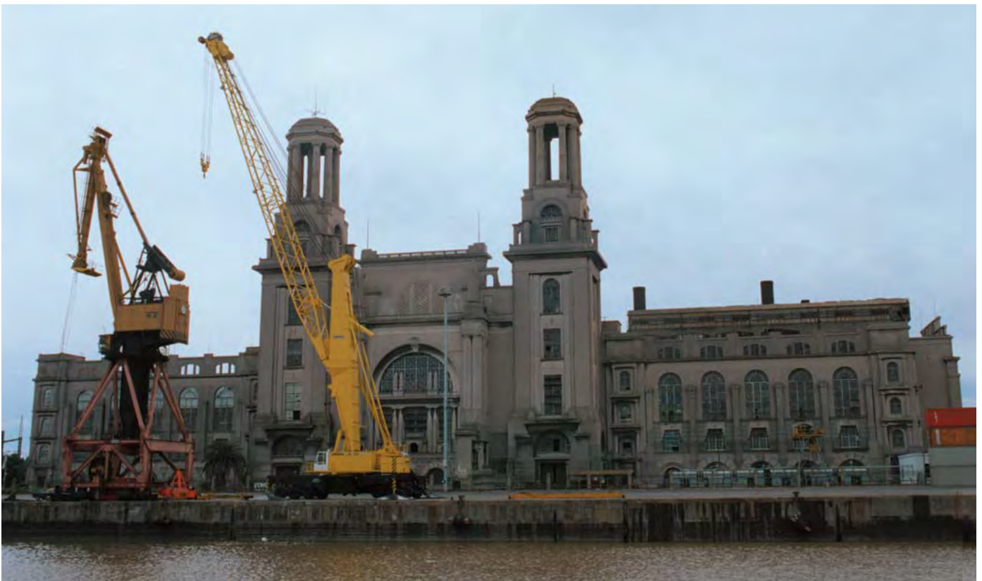
► USINA DE LA COMPAÑÍA ÍTALO-ARGENTINA DE ELCTRICIDAD, EN PUERTO NUEVO, BUENOS AIRES.
