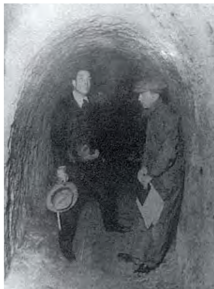
► HÉCTOR GRESLEBIN (CON ROPA DE TRABAJO) RELEVA LOS TÚNELES DE LA MANZANA DE LAS LUCES, BS. AS., EN 1920.
