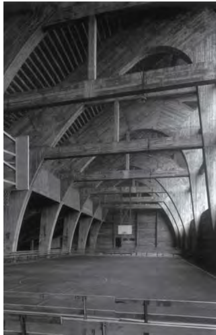
► PÓRTICOS DE HORMIGÓN ARMADO EN LA BOMBONERA.
