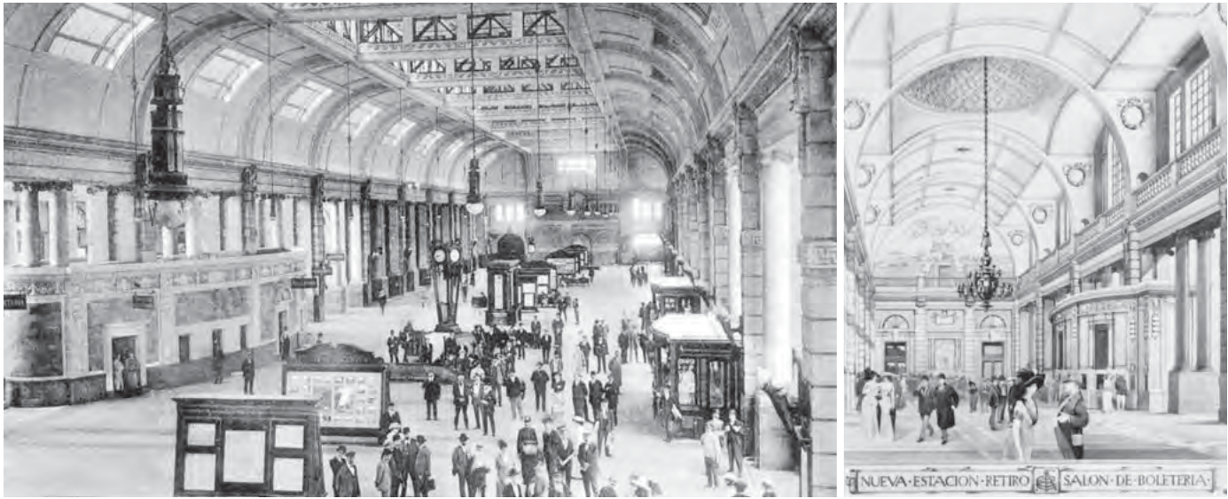
► LAS DOS NAVES DEL HALL DE RETIRO: EN UNA FOTOGRAFÍA DE 1912, Y EN UN DIBUJO DE S. FOLLET. EL VOLUMEN DE PLANTA ELIPSOIDAL DE LA BOLETERÍA ARTICULA AMBOS ESPACIOS.
