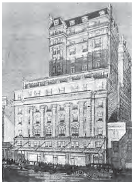
► EDIFICIO SOCIEDAD ANÓNIMA SHAFFHAUSEN, BS. AS.
