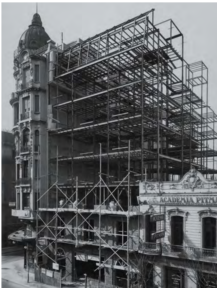
► CONSTRUCCIÓN DE UN EDIFICIO CON ESTRUCTURA PORTANTE DE ACERO, EN BUENOS AIRES.
