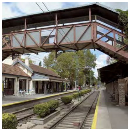
► LA RECUPERACIÓN DEL TREN DE LA COSTA, PCIA. DE BS. AS., MANTIENE LOS RASGOS ESTILÍSTICOS ORIGINALES.
