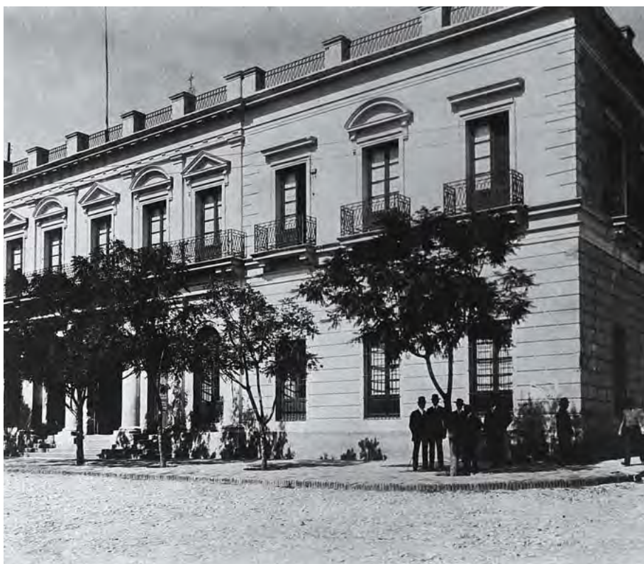
► LA CASA DE GOBIERNO DE LA PROVINCIA DE CATAMARCA, CONSTRUIDA ENTRE 1857 Y 1859 POR EL ITALIANO LUIS CARAVATTI.
