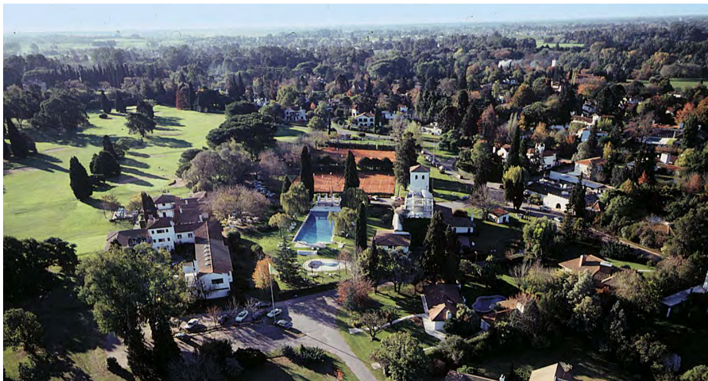
► VISTA AÉREA DE UNA TÍPICA URBANIZACIÓN COUNTRY DE LOS AÑOS 1990, UNA TIPOLOGÍA QUE SE CONSOLIDÓ COMO ALTERNATIVA A LA CIUDAD.
