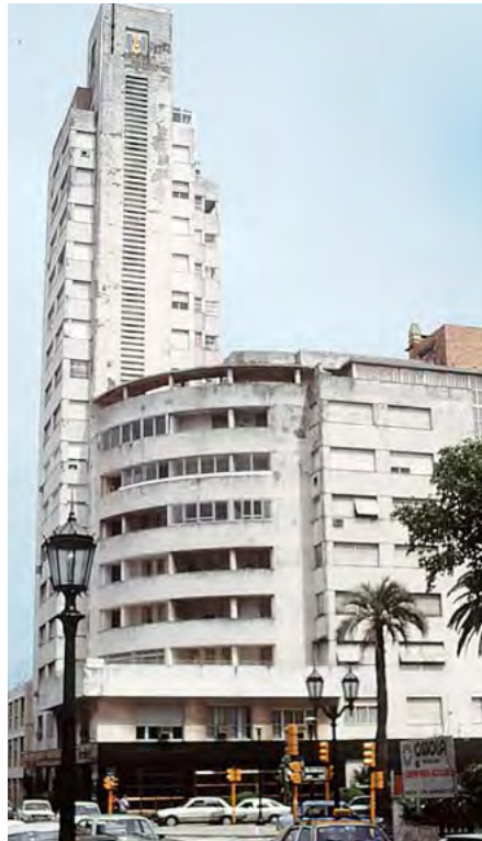
► EDIFICIO LA COMERCIAL (1938), EN ROSARIO.
