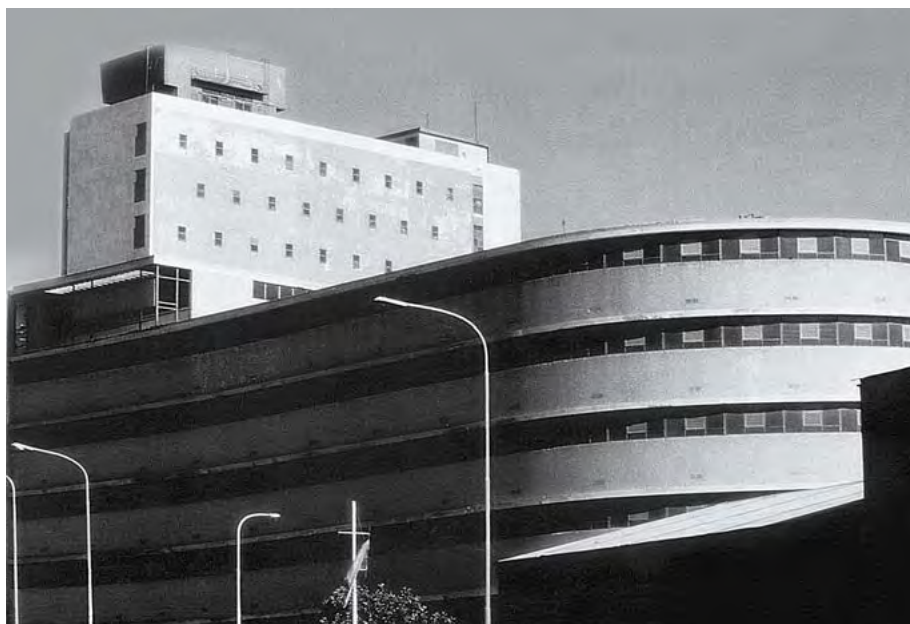
► EDIFICIO DE CORREOS Y TELECOMUNICACIONES EN PUERTO NUEVO (BUENOS AIRES), DE ROSSI, GALLARDO, PÁEZ Y GADO.
