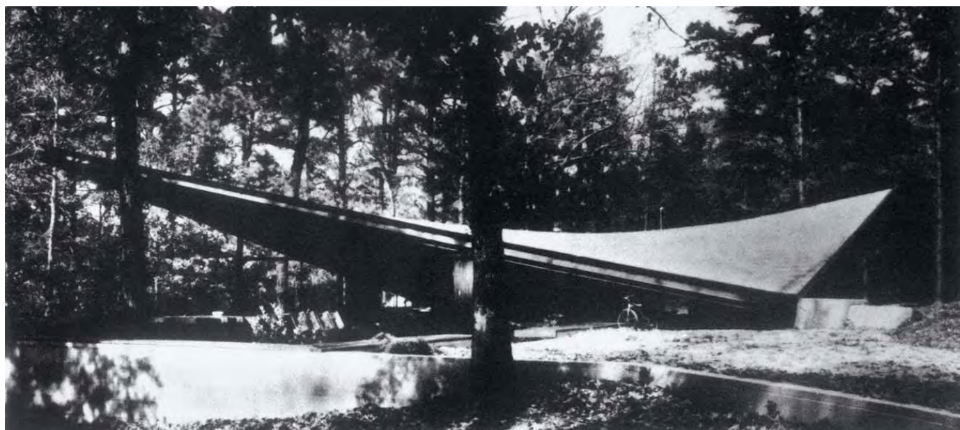
► LA CASA DE CATALANO EN NORTH CAROLINA, EE.UU., FUE CONSTRUIDA A PARTIR DE UN PARABOLOIDE DE DOBLE CURVATURA.
