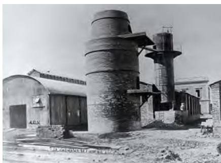
► SILO QUE SE USÓ EN OBRAS DE SANEAMIENTO DE BS. AS.
