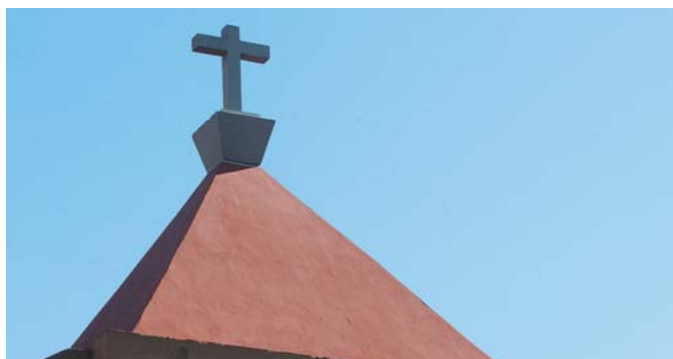
► LOS MUROS ENCALADOS Y RÚSTICOS, LOS ALEROS Y GOTERONES EN HORMIGÓN Y VARIAS PIRÁMIDES ROJAS DE DIVERSAS DIMENSIONES DAN FUERTE IDENTIDAD A ESTA OBRA.
