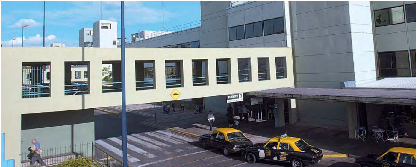
► TERMINAL DE ÓMNIBUS DE BUENOS AIRES, EN RETIRO, DEL ESTUDIO SERRA Y VALERA (1980).
