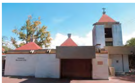
► A LA IZQUIERDA: LA PLANTA PRINCIPAL. EL ESPACIO ESTÁ DEFINIDO POR MUROS BLANCOS DE GRAN ESPESOR Y POR LOSAS DE HORMIGÓN VISTO CON FORMA DE PIRÁMIDE.
