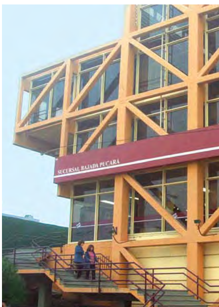
► BANCO DE LA PROV. DE CÓRDOBA, DE M. A. ROCA.
