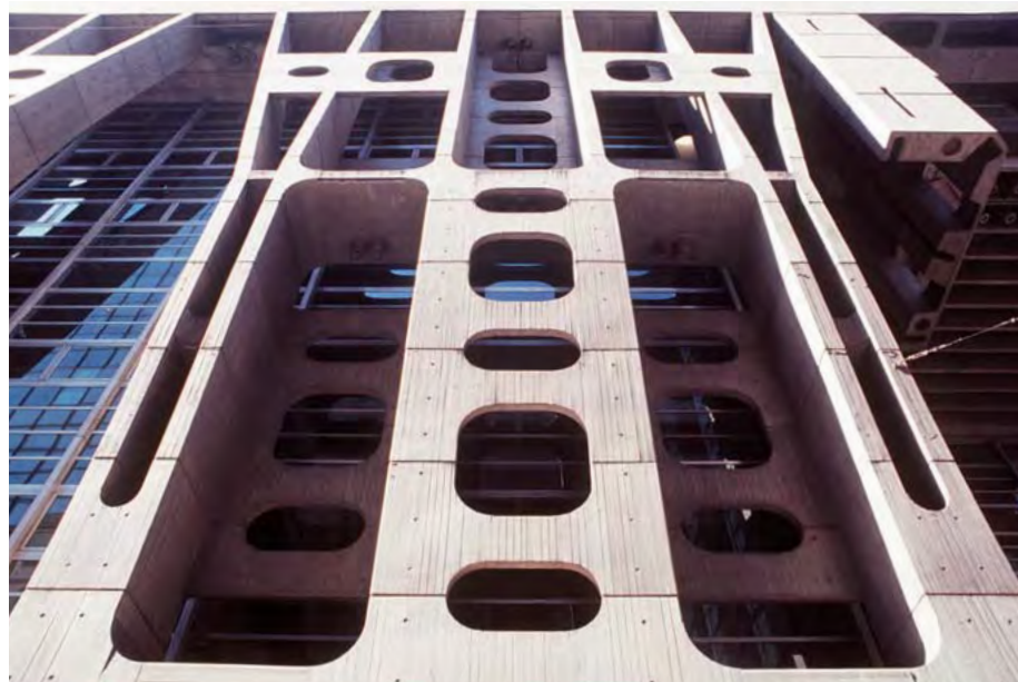
► EX SEDE CENTRAL DEL BANCO DE LONDRES Y AMÉRICA DEL SUR, DE SEPRA Y CLORINDO TESTA.
