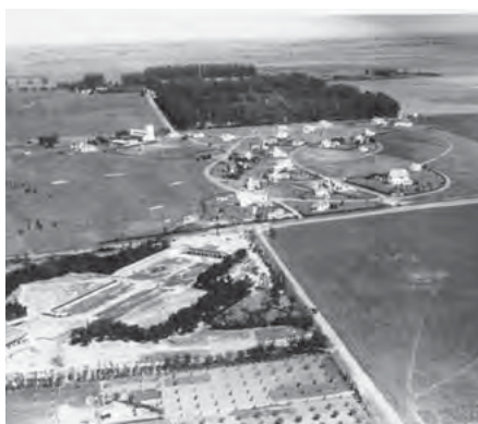
► PRIMERAS OBRAS EN UNA URBANIZACIÓN SUBURBANA.
