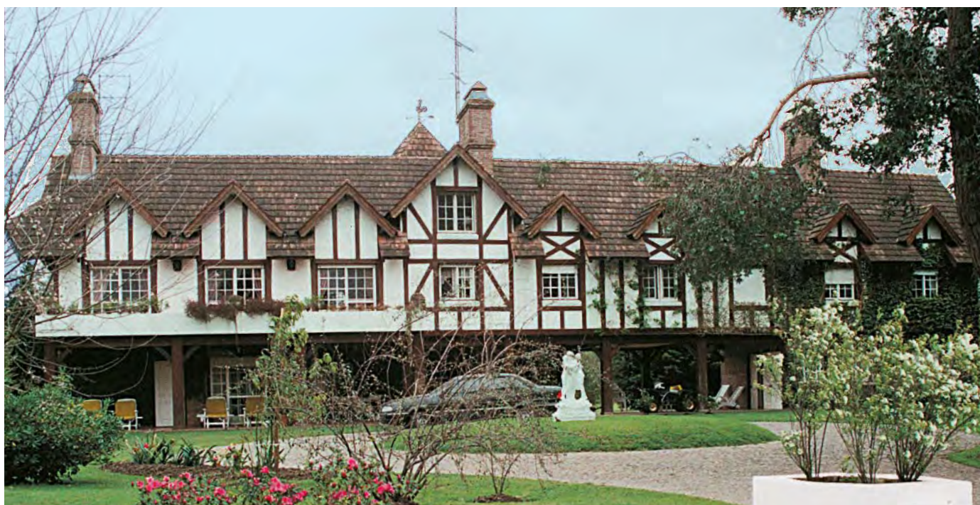
► TECHOS CON PENDIENTES Y FACHADAS BLANCAS Y LISAS, DESTACADAS CON MARCOS DE MADERA, EN EL OLIVOS GOLF CLUB (1933) EN BUENOS AIRES.
