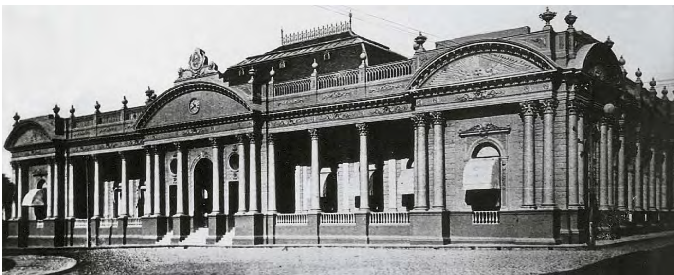
► CASA DE GOBIERNO DE LA PROVINCIA DE CORRIENTES, DEL INGENIERO ITALIANO JUAN COL, 1886.
