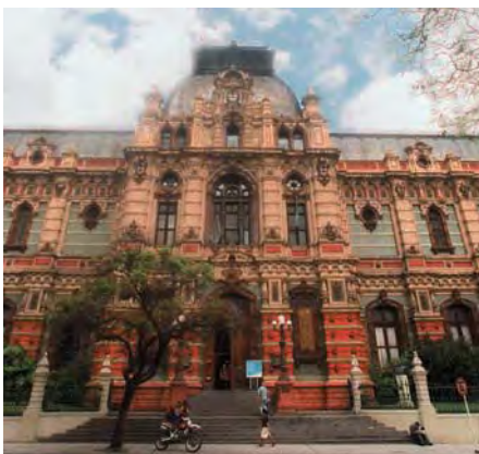
► PALACIO DE AGUAS ARGENTINAS, EN AV. CÓRDOBA.
