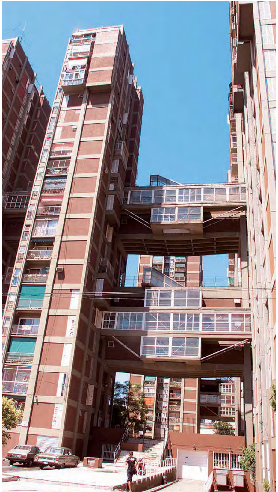
► HORMIGÓN Y LADRILLO EN EL CONJUNTO HABITACIONAL “RIOJA”, EN BUENOS AIRES, DEL ESTUDIO MSSGSV.
