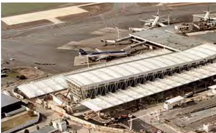
► PANORÁMICA DE LA PRIMERA ETAPA DE AMPLIACIÓN DE EZEIZA. SE DIFERENCIA LA ESTRUCTURA DE LA MARQUESINA DE ACCESO, EL HALL CENTRAL CON ALTURA VARIABLE. POR DETRÁS, LOS SERVICIOS.
