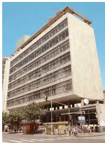
► EDIFICIO DE TELÉFONOS EN MAR DEL PLATA.
