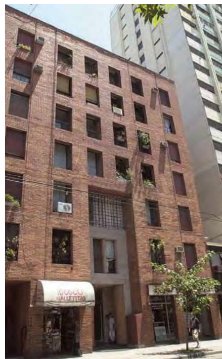
► EDIFICIO EN MEDRANO 172, BUENOS AIRES (AYG)
