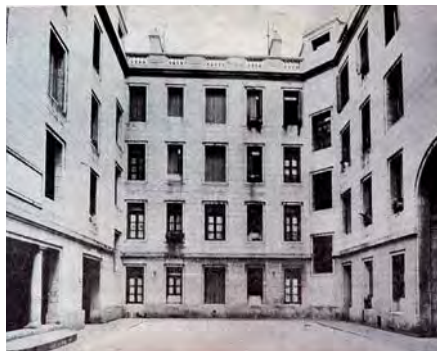
► INTERIOR DE LA CASA COLECTIVA VALENTÍN ALSINA.
