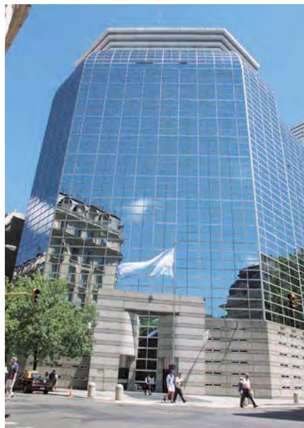
► NUEVO EDIFICIO DE LA CANCELLERÍA, EN BUENOS AIRES.
