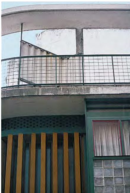
► METALES VARIOS Y DISTINTOS VIDRIOS PARA MATERIALIZAR LA OBRA CON RECURSOS INDUSTRIALES Y MONTAJE EN SECO.
