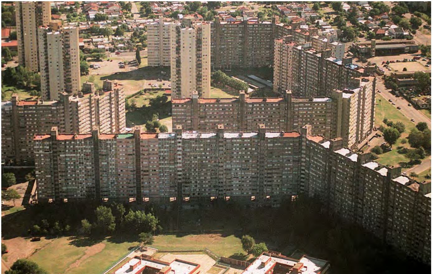
► CONJUNTO HABITACIONAL DE ALTA DENSIDAD, EN VILLA LUGANO, BUENOS AIRES.
