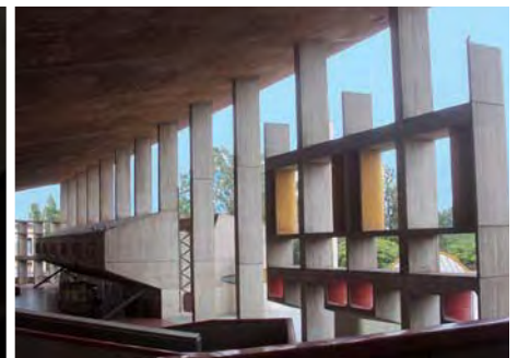
► ARRIBA: DETALLES DEL BRISE-SOLEIL CONSTRUIDO EN HORMIGÓN VISTO. TIENE EN SUS PLANOS INTERIORES TOQUES DE COLORES PRIMARIOS.
