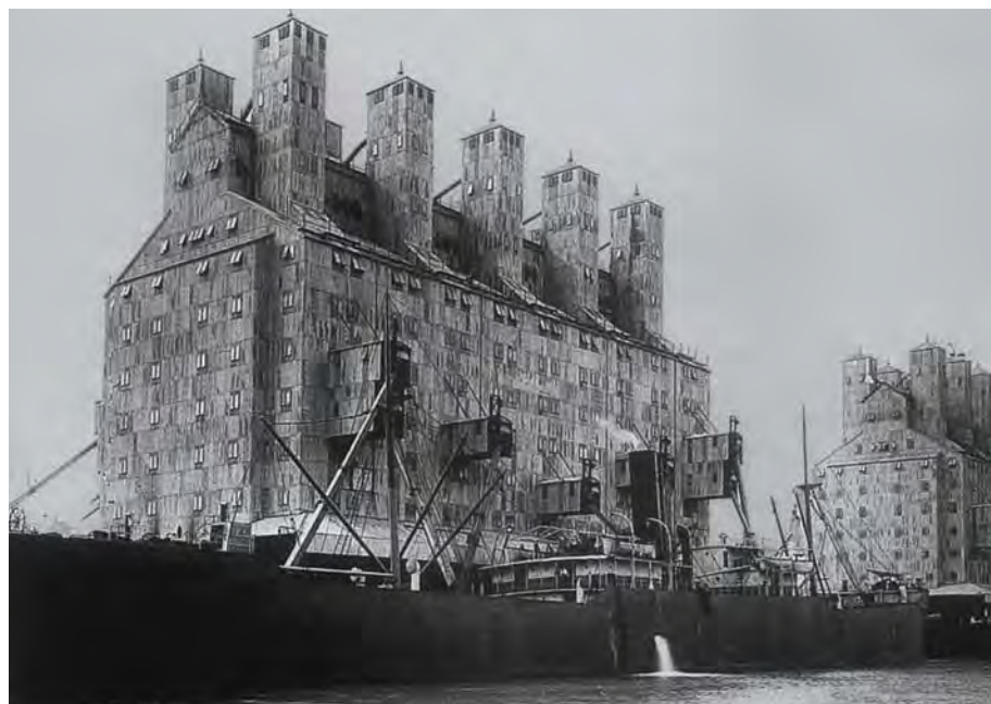
► SILOS DE LADRILLOS EN EL PUERTO DE INGENIERO WHITE, SOBRE LA RÍA BAHIENSE.
