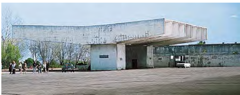
► VISTA DEL PÓRTICO DE HORMIGÓN DEL CEMENTERIO DE MAR DEL PLATA, UNA DE SUS MÁS CELEBRES OBRAS.
