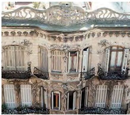
► CASA DE RENTA DE AV. RIVADAVIA 2031, DE R. ORTEGA.
