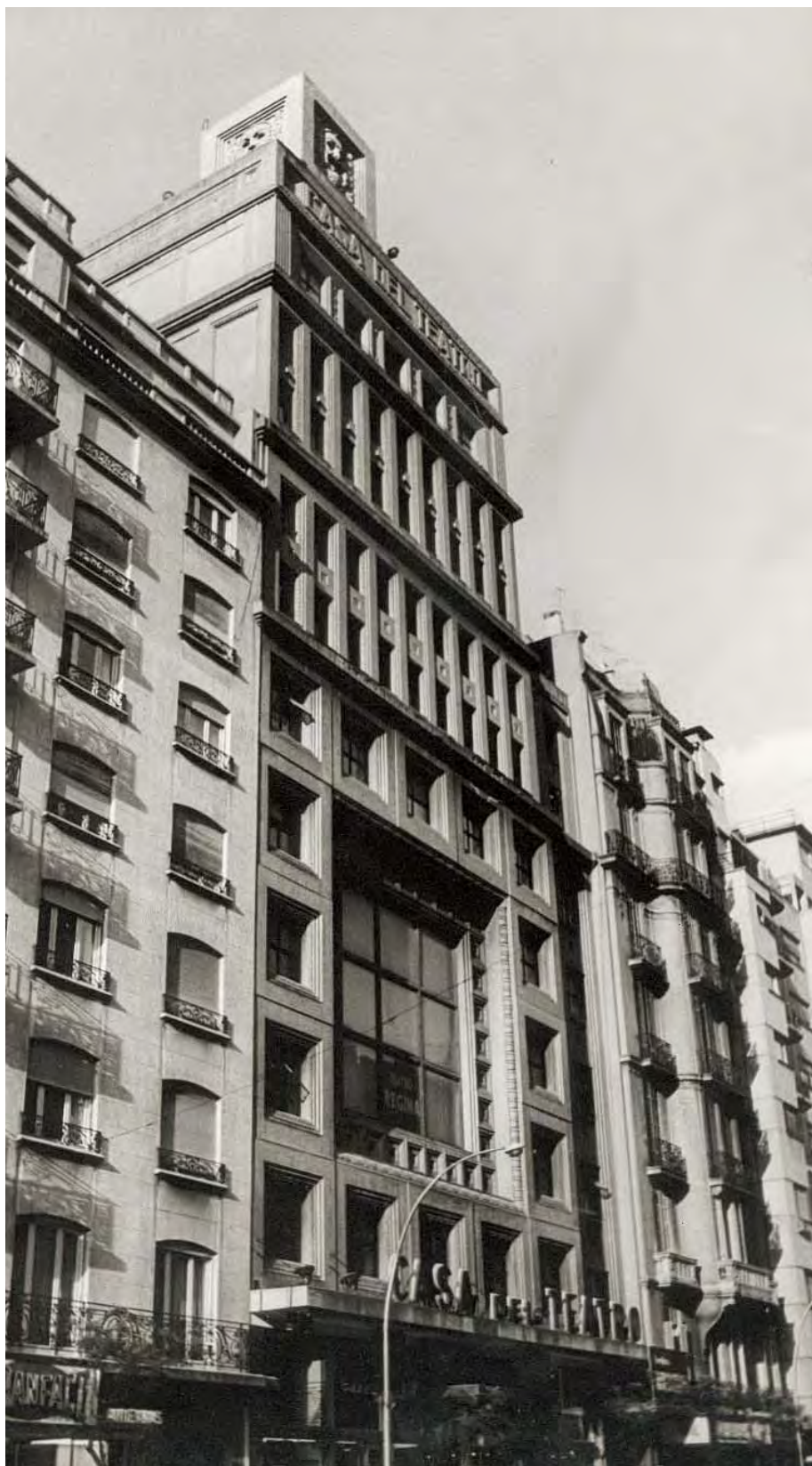
► LA FACHADA ART DECÓ DE LA CASA DEL TEATRO, SOBRE LA AVENIDA SANTA FE, EN BUENOS AIRES.
