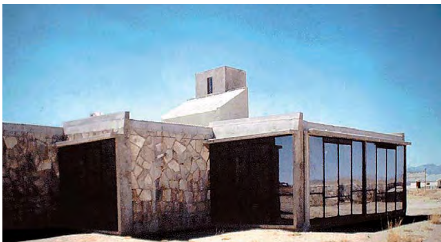
► REFUGIO PARA GUARDAPARQUES EN LA PROVINCIA DE SALTA. INENCO, UNIVERSIDAD NACIONAL DE SALTA, 1988.
