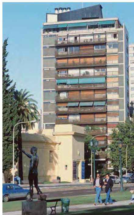
► EDIFICIO DE DEPARTAMENTOS EN SCHIAFFINO Y POSADAS.
