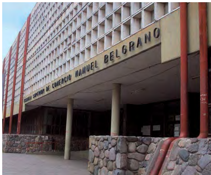
► ARRIBA: DETALLES DEL BRISE-SOLEIL CONSTRUIDO EN HORMIGÓN VISTO. TIENE EN SUS PLANOS INTERIORES TOQUES DE COLORES PRIMARIOS.
