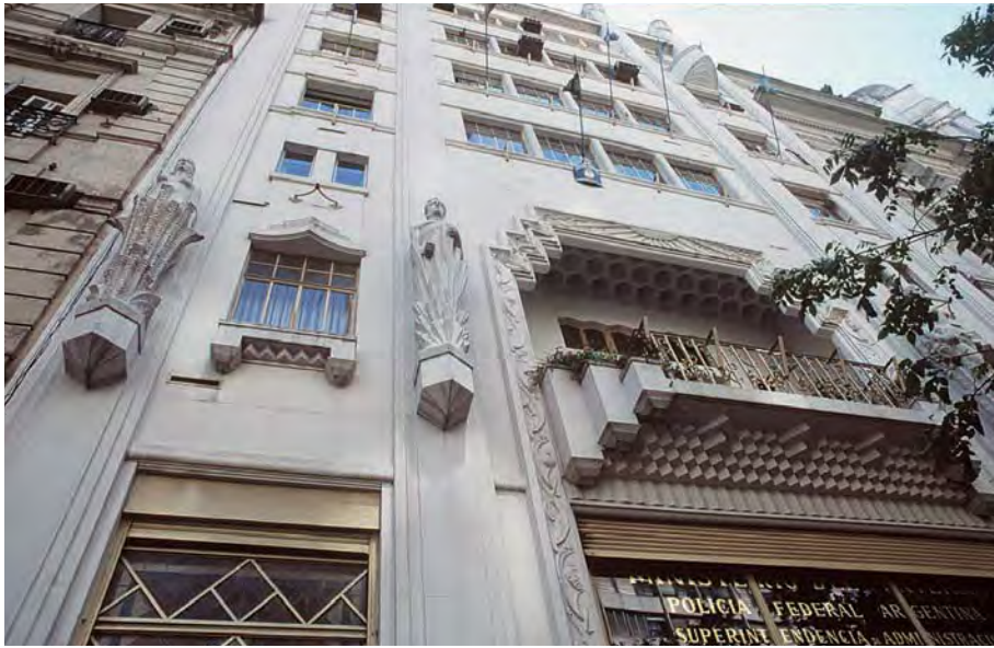
► SEDE DEL DIARIO CRÍTICA SOBRE LA AVENIDA DE MAYO EN BUENOS AIRES. OBRA DE ANDRÉS KALNAY.
