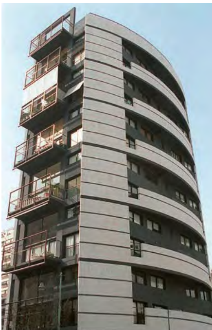
► DEPARTAMENTOS SOBRE AVENIDA CHENAUT, EN EL BARRIO LAS CAÑITAS, DE LA CAPITAL FEDERAL.
