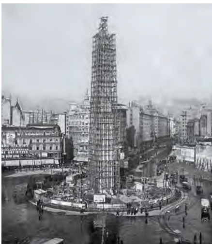
► EL OBELISCO EN CONSTRUCCIÓN EN EL AÑO 1936.
