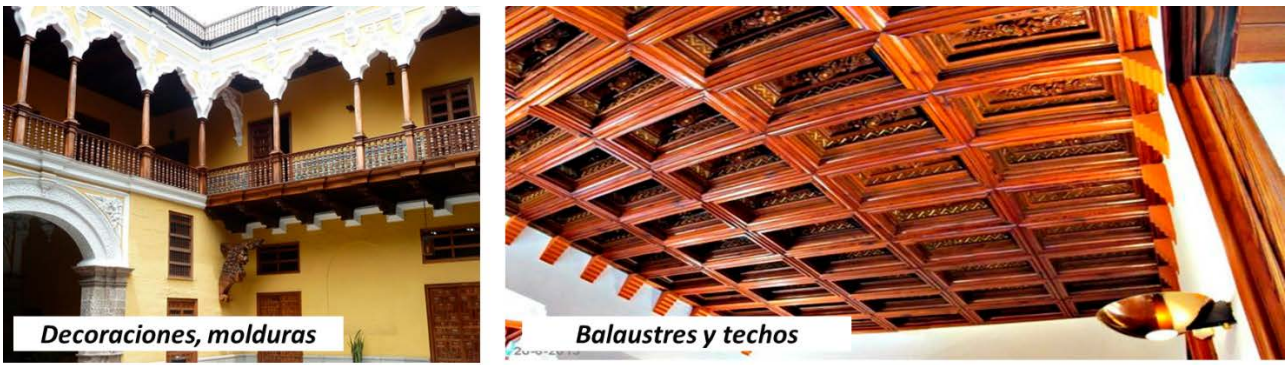
Figura 9. Ejemplo de galería y techo artesonado. Fuente: Imágenes de la autora.
