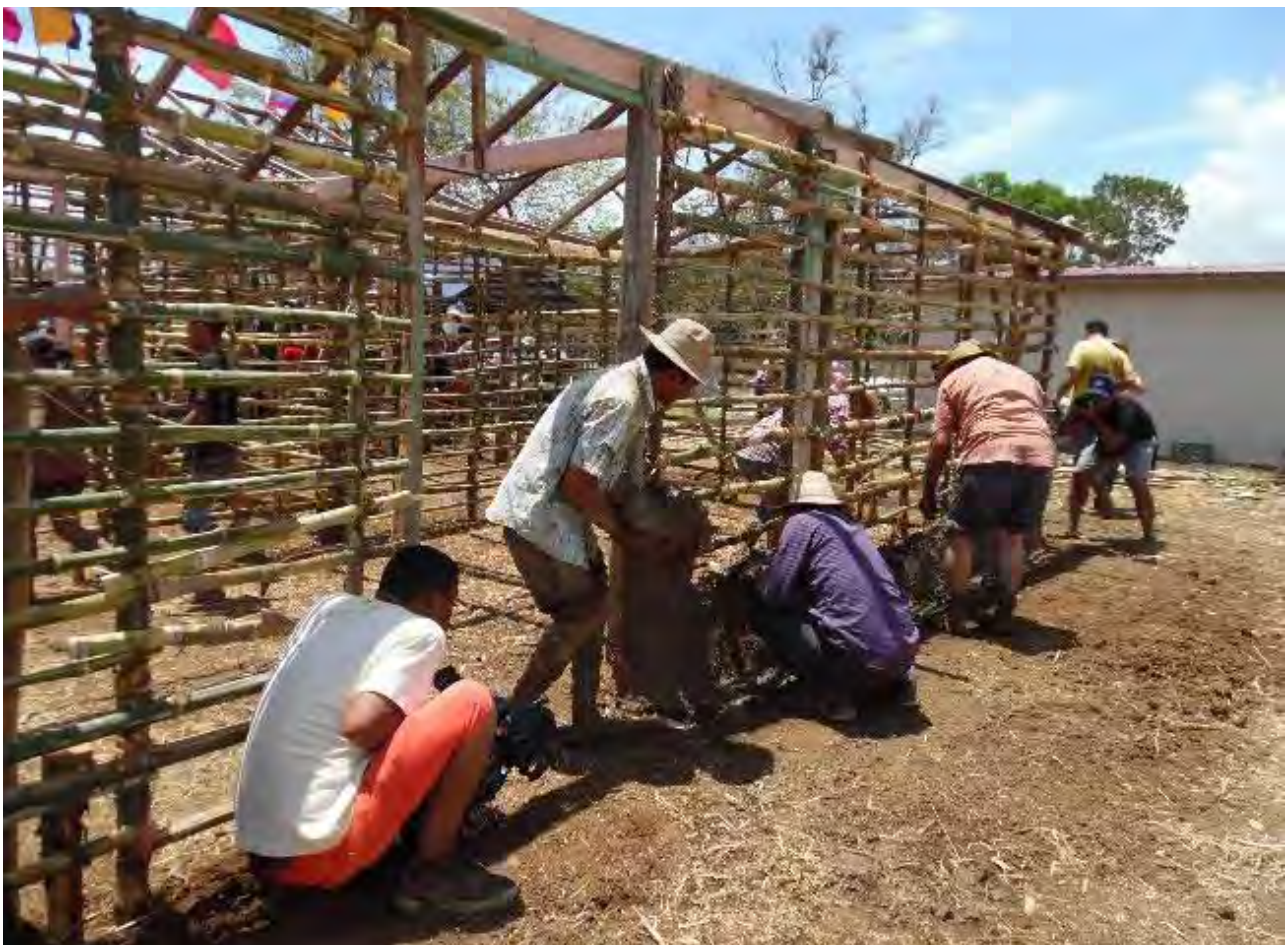
Figura 5: Junta de embarre en El Sesteadero, Los Santos. Región de Azuero. Fuente: fotografía de la autora.
