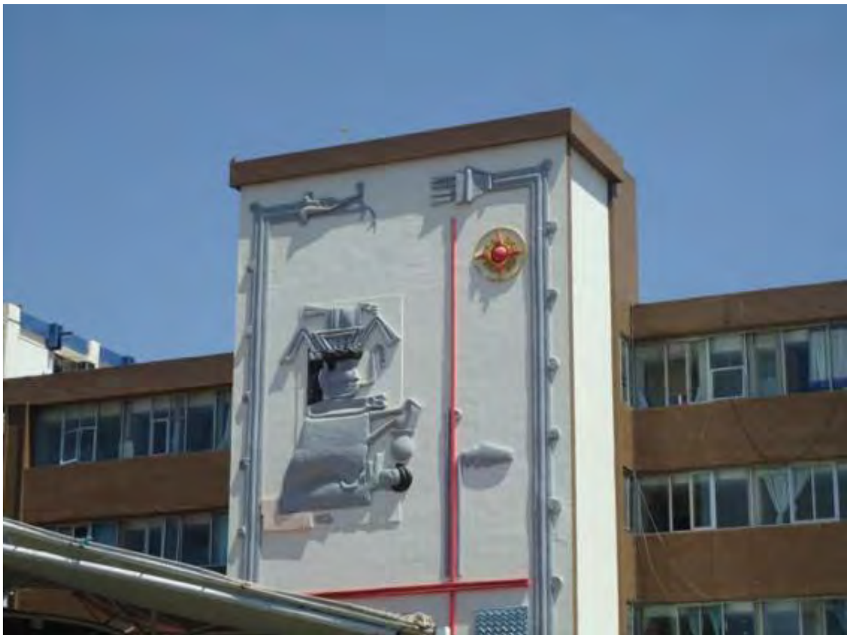
Figura 11: Volúmen de ascensores en Hospital Civil Aurelio Valdivieso, Oaxaca (1963). Repositorio: CAPUAO-Facu-UABJO.
