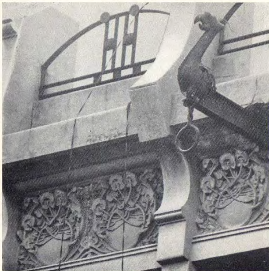
Detalle del guinche para mudanzas y guarda vegetal de argamasa
