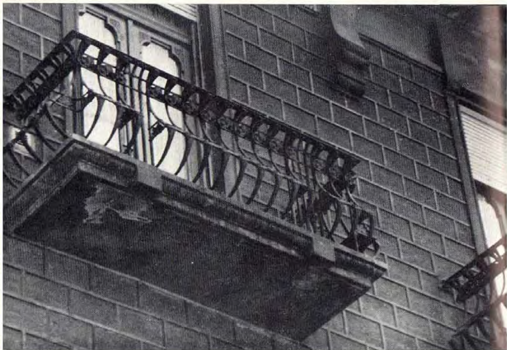
Detalle del balcón del segundo piso
