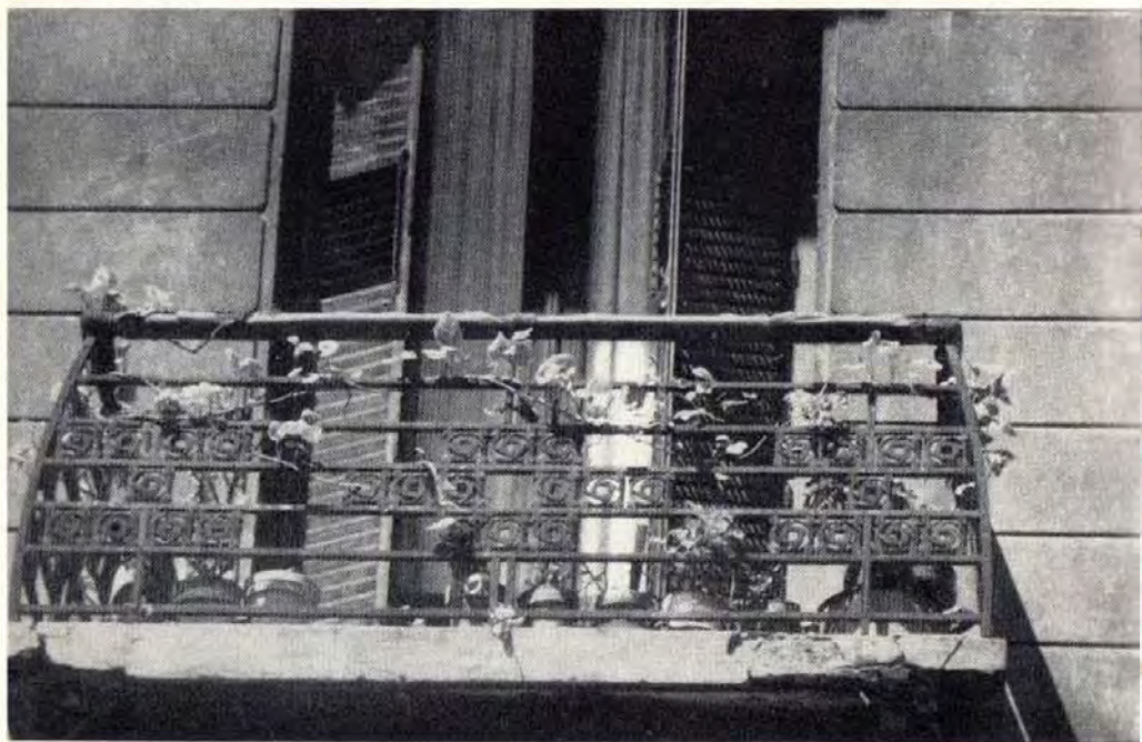
Balcón del tercer piso
