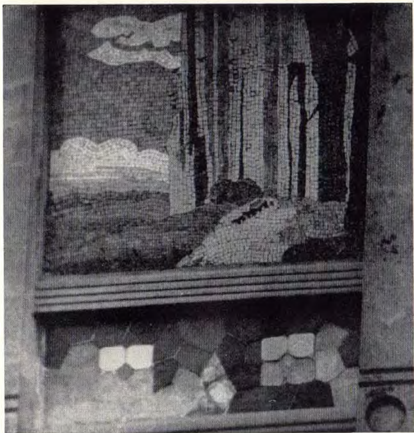
Mosaico central de la parte superior izquierda de la fachada
