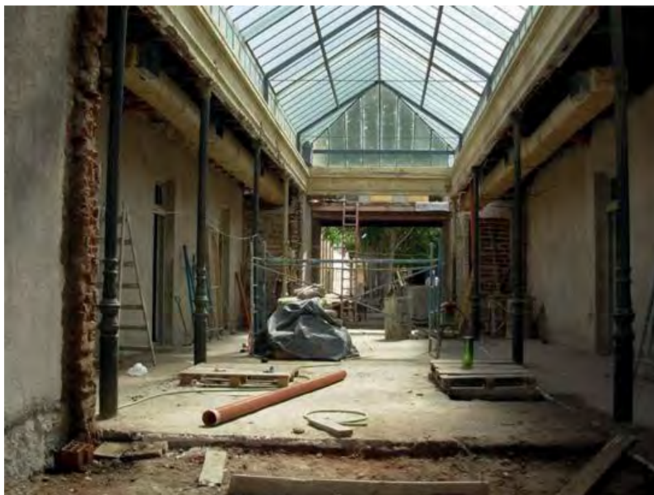
Figura 8. Obra patio al fondo_ Archivo DGC
