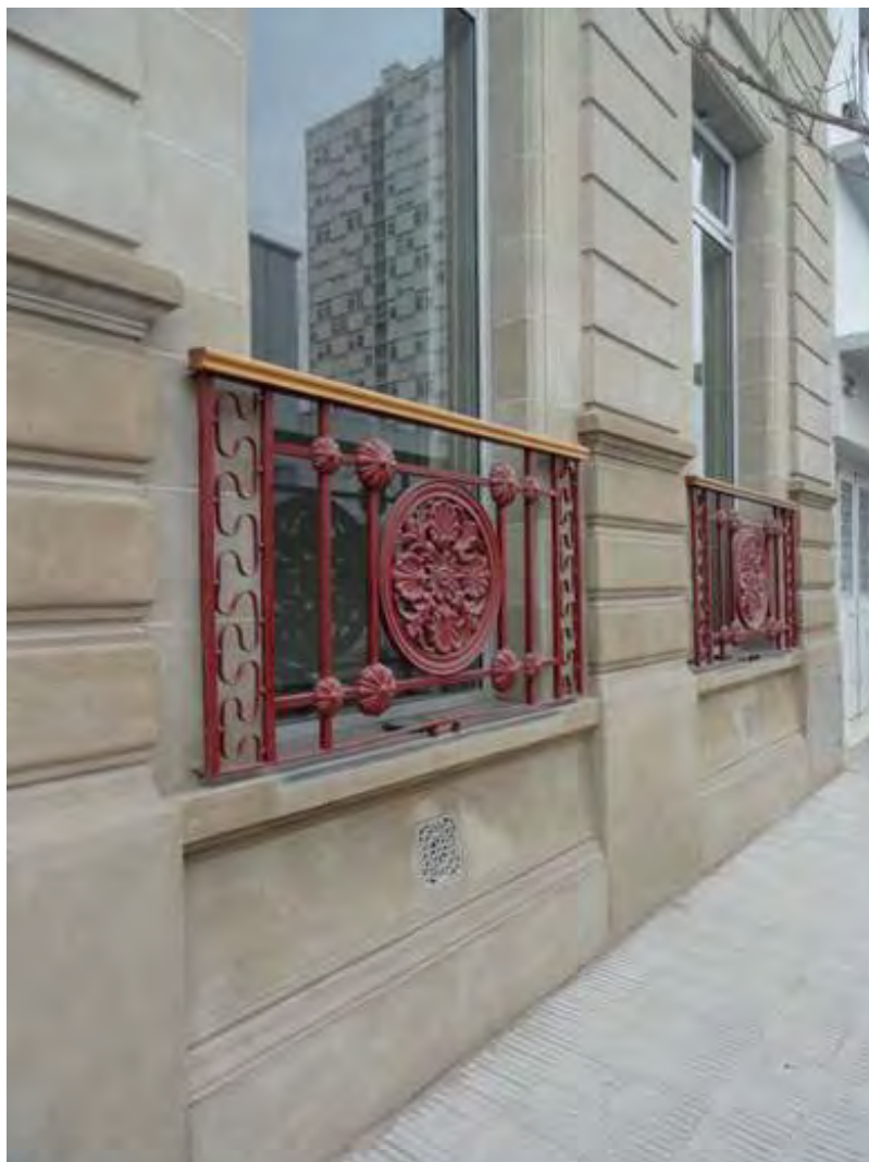
Imagen 14. Terminaciones balcón fachada_ Archivo DGC
