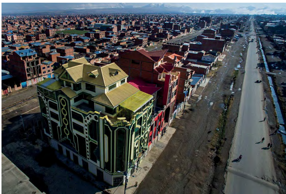
Figura 1. Edificios diseñados por Freddy Mamani en El Alto, La Paz, por pedido de familias de comerciantes del lugar. Fachada con inspiración andina, locales comerciales en la planta baja, lujoso salón de eventos en dos pisos y vivienda “chalet” en el último piso. Foto A. Zeballos, 2015.
