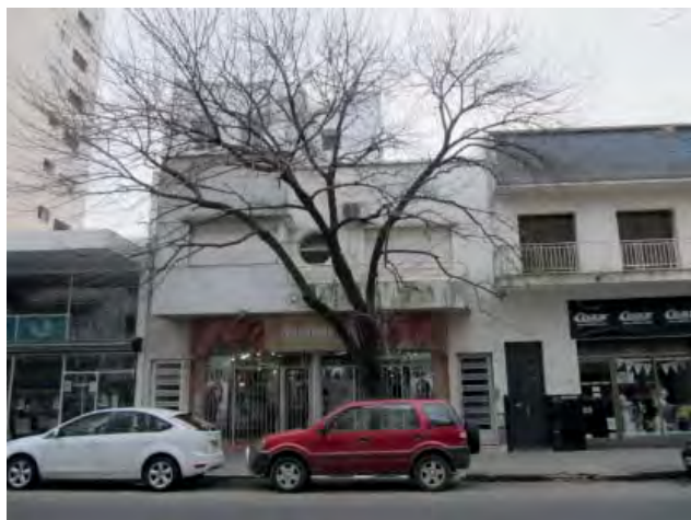
Figura 8. Cambio de carpinterías. Fuente LINTA-CIC
