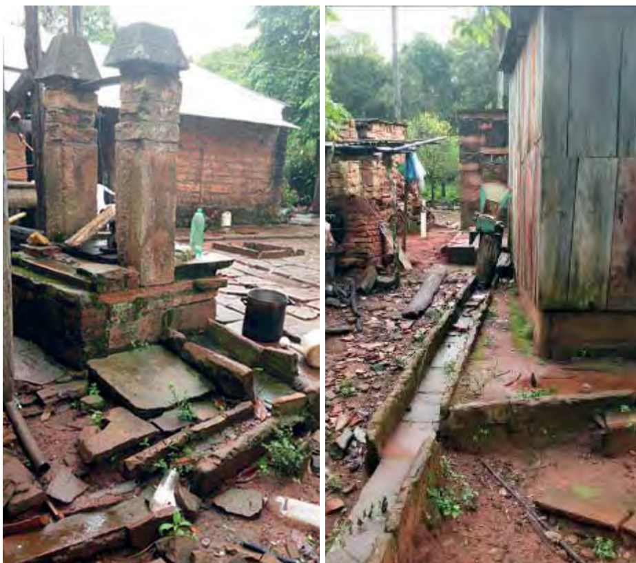
Figura 10. Sistema de distribución de agua en una casa actual, desde un aljibe mediante canales, totalmente hecho en piedra.
