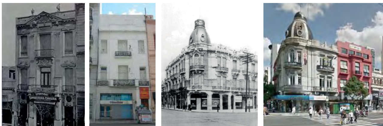
Fig. 7. Ejemplos de pesadas intervenciones, con pérdidas irreversibles, que no toman en consideración el carácter histórico, tipológico y estilístico del edificio rindiéndolo casi irreconocible.
