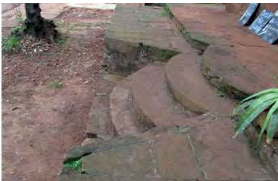
Figura 6. Escalera de entrada de una vivienda hecha hacia 1940 mostrando la calidad del trabajo en piedra en la ciudad San Ignacio imitando lo colonial.
