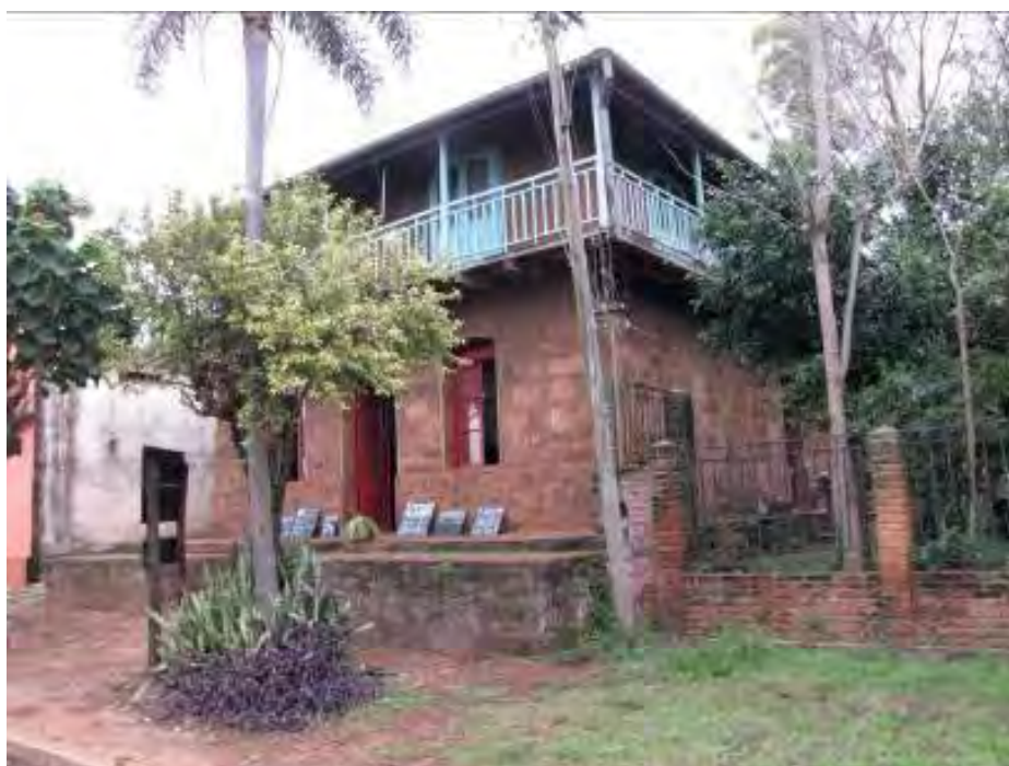
Figura 7. Casa Canteros con negocio a la calle, hecho con sillares cúbicos.
