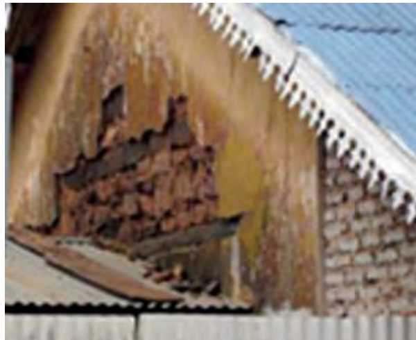
Figura 12. Relicto de sistemas constructivos europeos del siglo XIX tardío; piedras entre vigas horizontales de madera.
