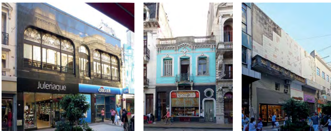
Fig. 6. Ejemplos de intervenciones que aceleran el proceso de degradación urbana o edificios mal intervenidos (no más reconocibles).
