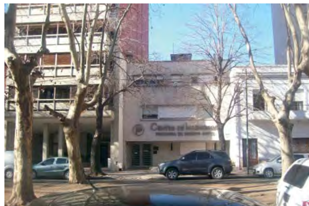
Figura 4. Retiro de línea municipal. Fuente LINTA-CIC
