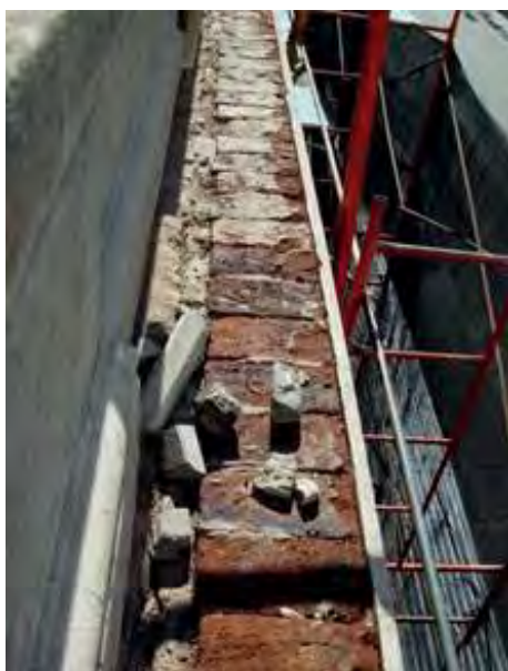
Figura 11. Obra detalle cornisa _Archivo DGC
