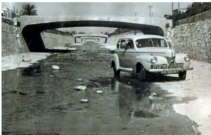
Figura 2. Vista de la canalización y los puentes al finalizar los trabajos
