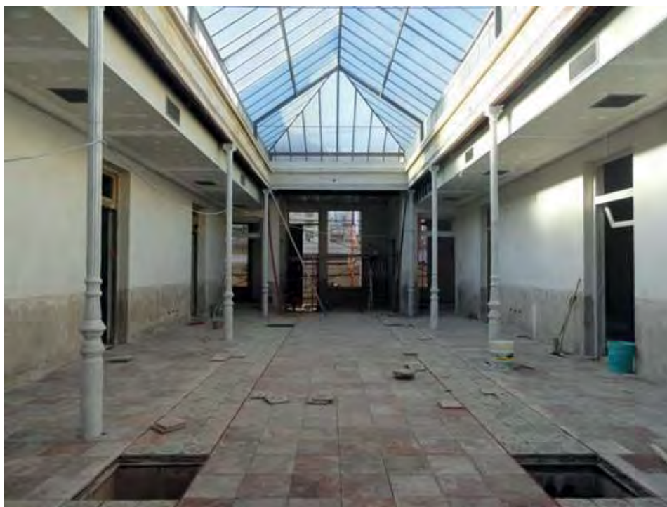
Figura 9. Obra patio frente 5_Archivo DGC
