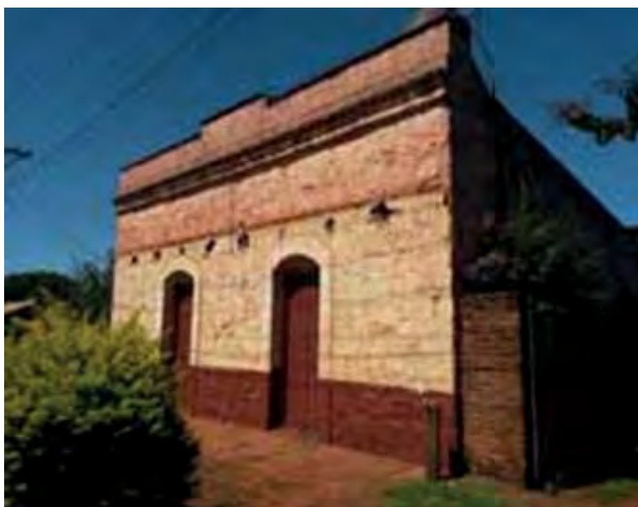
Figura 3. Casa del período fundacional en San Ignacio, nótese el trabajo de la piedra usada como mampostería unida con mezcla; son visibles las marcas de la galería a la calle.
