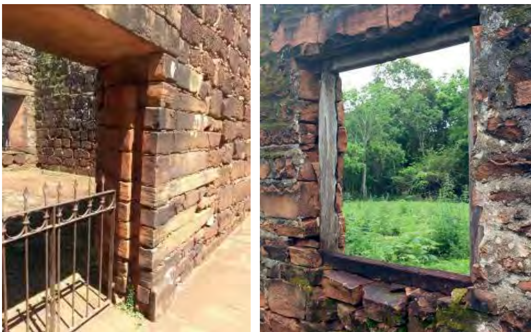
Figura 13-14. Diferentes sistemas de aparejo murario y de colocación de los marcos, entre la arquitectura jesuítica (San Ignacio Miní) and una vivienda del siglo XX.
