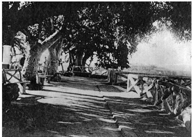
Figura 10: La baranda en lenguaje "rocalla", donde se aprecia la cisura en el acceso al balcón central (fotografía del 4 de abril de 1929). Repositorio: Archivo del MBAHMSI.
