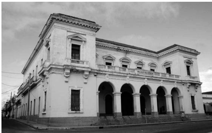
Figura 21: Aduana (1828), del arquitecto francés Julio Sagebien, radicado en Matanzas y luego en La Habana. La extensa obra de Sagebien en Matanzas fue el fundamento de la escuela "criolla" que caracteriza la versión neoclásica de la ciudad. Fuente: Fotografía de Julio Larramendi.
