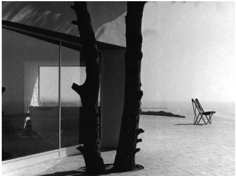
Figura 2: Casa Ugalde, Caldetas, Barcelona, 1951. Arquitectos: José Antonio Coderch y Manuel Valls. Fotografía: Francesc Català-Roca. Fuente: Flores López, C., Arquitectura española contemporánea . Madrid: Aguilar, 1961, p. 247.
