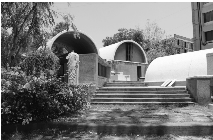
Figura 7: Sangath. Balkrishna Doshi. Ahmedabad, India. Fuente: Fotografía del autor.
