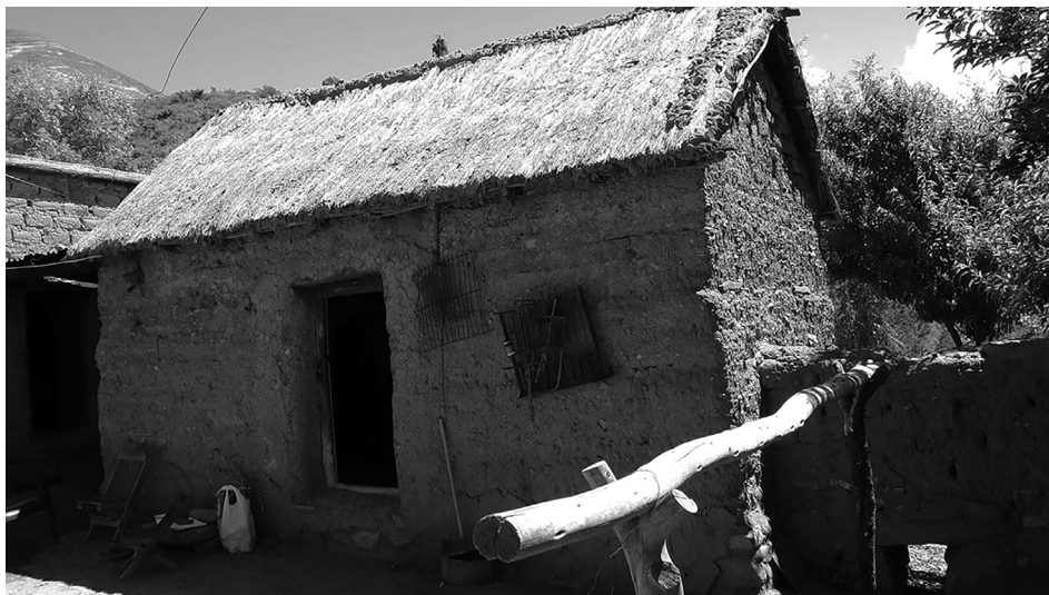
Figura 11: Imagen de la terminación de la cubierta con guaya. Fuente: Fotografía de la autora.
