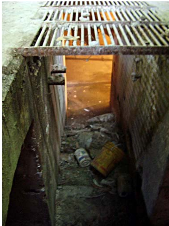
Vista de una galería bajo las ventilaciones, rellena con basura moderna, nótese el agua atrás.
