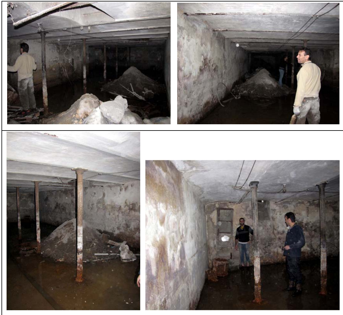
Vistas del interior del sótano considerado como más antiguo, sus columnas de hierro fundido, el sistema de iluminación al exterior con cables entelados y las pilas de basura arrojadas por las rejillas superiores; siempre agua en el piso.
