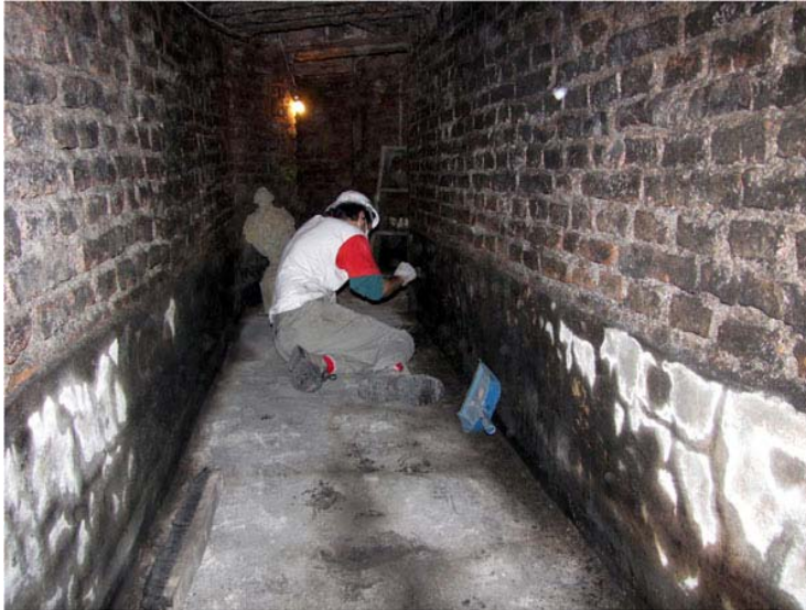
Vista del tramo longitudinal reabierto de su relleno al limpiarse el piso y bordes de cemento.
