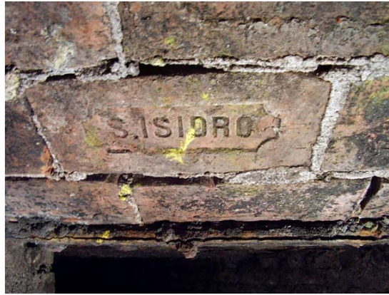
Primera vista de la galería bajo tierra en 1985, quedaban bien a la vista los ladrillos marca San Isidro del siglo XIX tardío.
