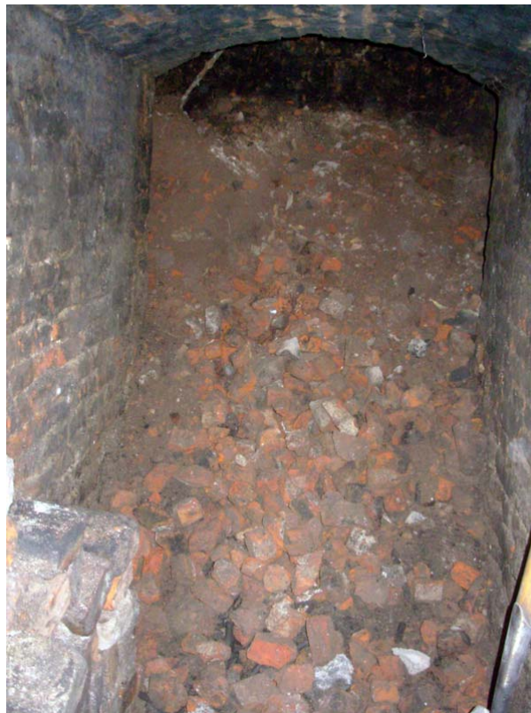
Estado del túnel al iniciarse la liberación del escombros que lo rellenaba.
