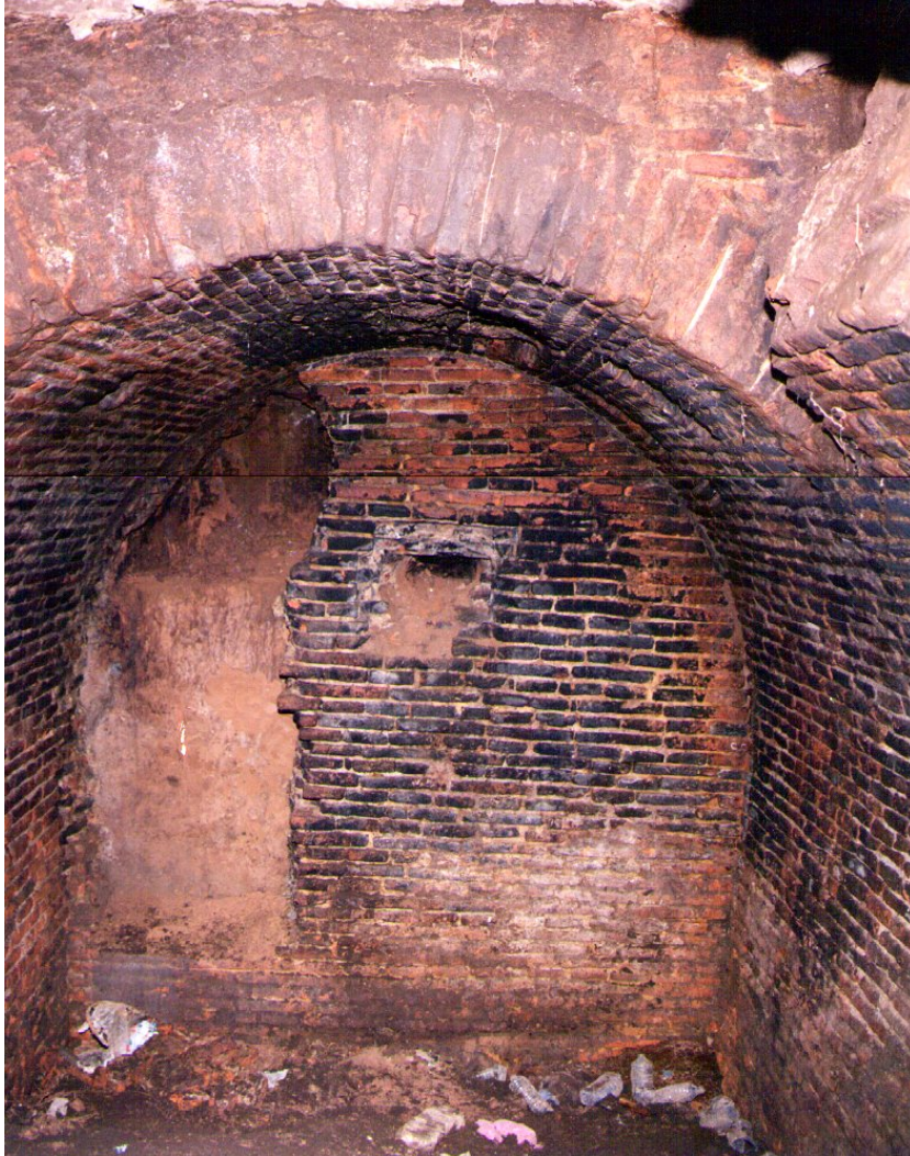
Pozo de absorción o desague de lo que fuera el Hospital de Mujeres en la actual plaza Roberto Arlt (foto: Marcelo Weissel).
