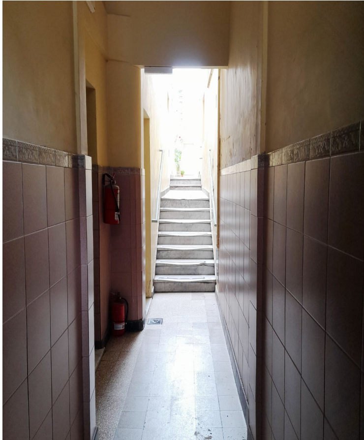
Vista de los desniveles del suelo en el interior del conjunto, evidencia de rellenos antiguos en el lugar, inversos a la topografía original del lugar.
