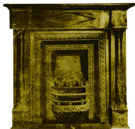
Detalle de una ventana y un frente de chimenea fotos 1927.
