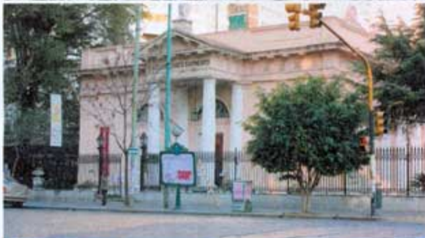
AYER Y HOY Arriba, cuando funcionó como casa de gobierno; abajo, la vista actual, en el barrio de Belgrano
