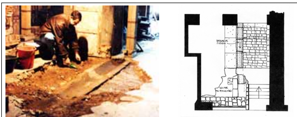
Sistema de desagüe en el acceso a la casa hecho de piedras talladas, siglo XVIII temprano.
