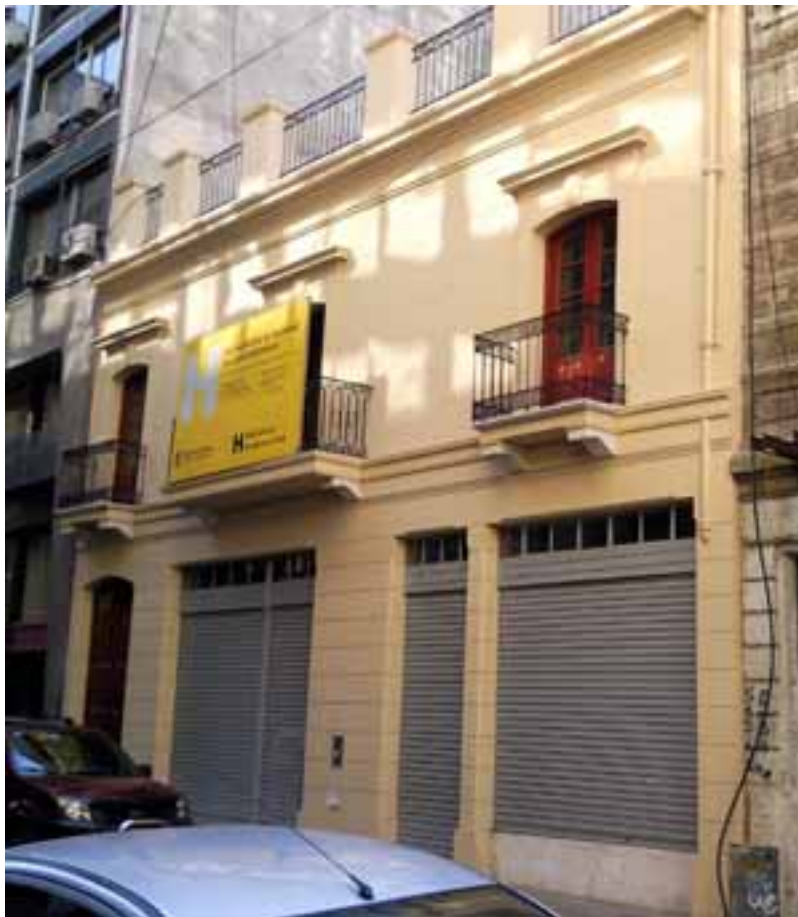
Fachada de la vivienda durante los trabajos de restauración recientes (2010).
