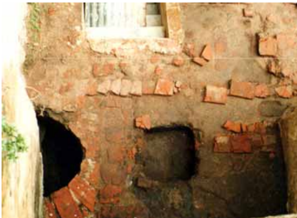
Excavación del Local 16, a la izquierda el pozo compartido del siglo XVIII, arriba la escalera del siglo XX que comunicó con el edificio lindero.
