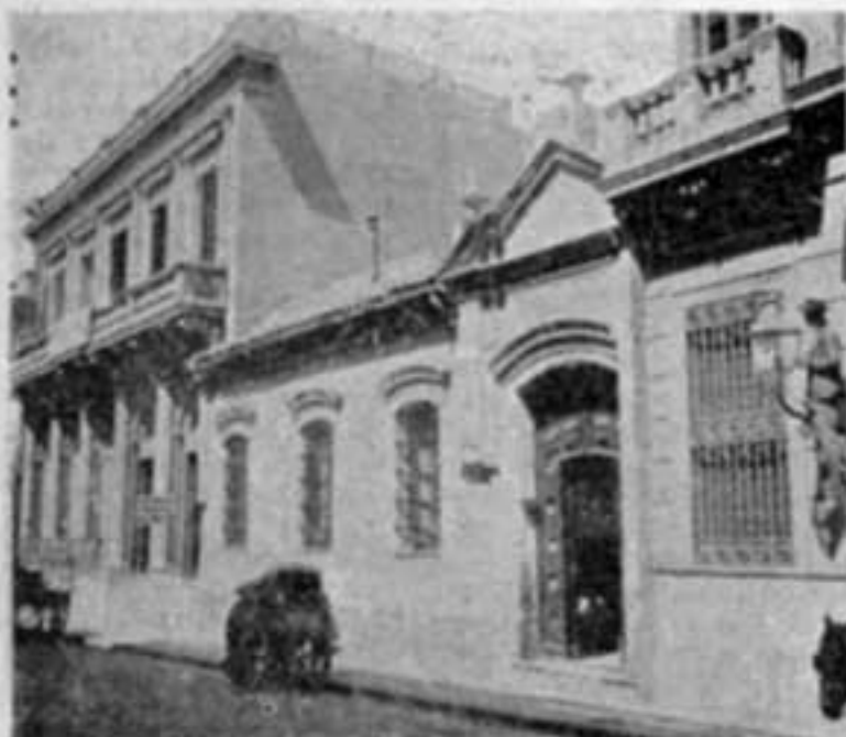
Casa de la Legación Inglesa, refugio de Rozas el 3 de Febrero de 1852 — Bolívar 553
