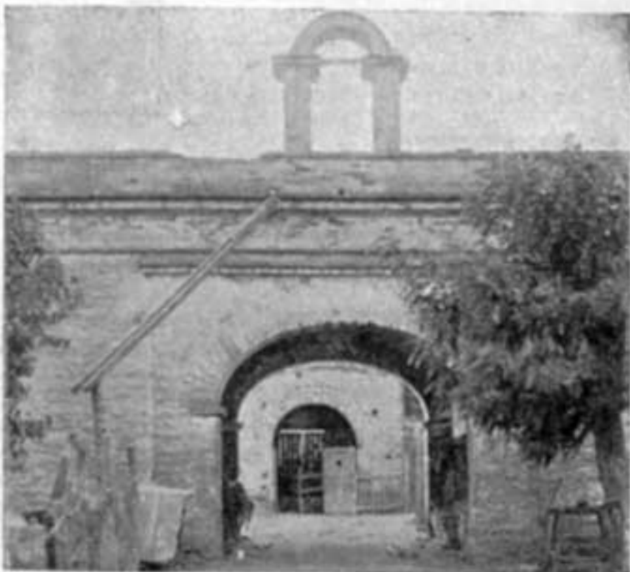
Entrada de las crujiás en Santos Lugares
