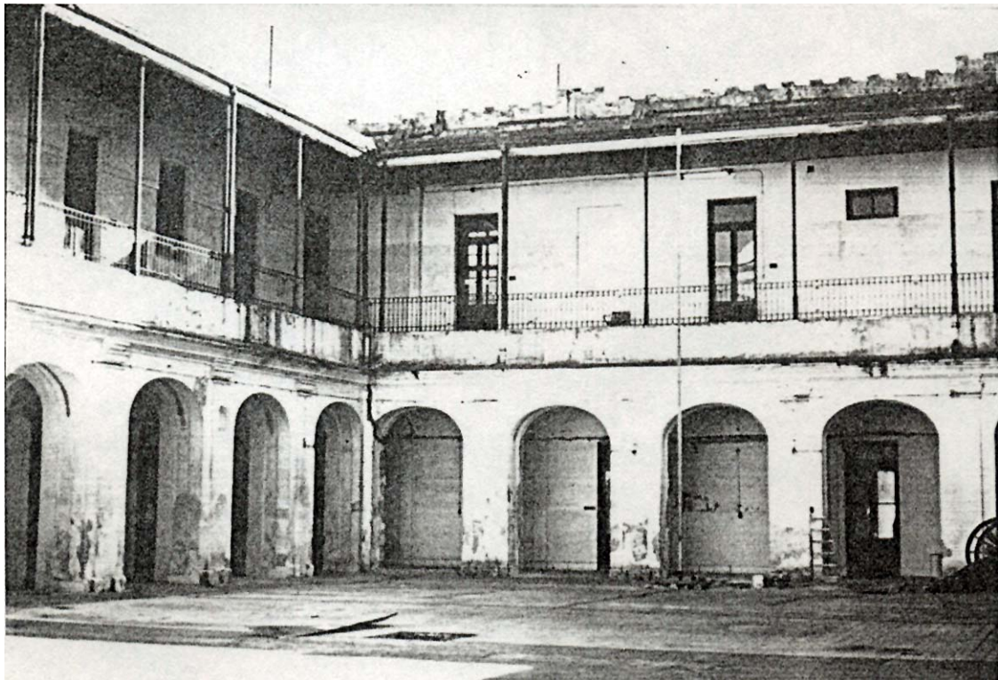
Frente de la Capilla de la antigua Casa de Ejercicios y su patio rodeado de portales; el piso superior fue agregado hacia 1885. Se observa al centro la Cuadrícula N° 2 y en el centro del pórtico la número 1.
