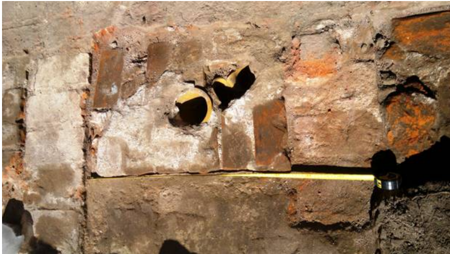
Foto de la excavación con la base del inodoro y el sifón de porcelana aun en su lugar.
