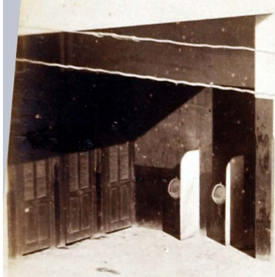
Detalle ampliado en que se ven las puertas de los cubículos (Cortesía C. Gotta).
