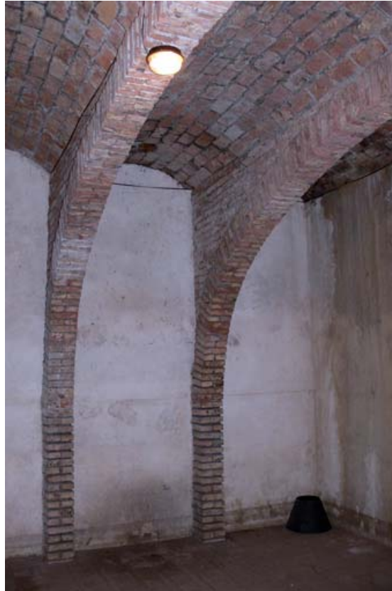
Sótano para ampliar el depósito de agua sostenido por vigas de hierro revestidas de ladrillo y bovedillas de mampostería.
