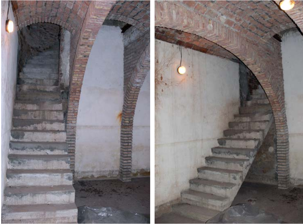
Bajada de la escalera de hormigón armado moderna, puede notarse como se ajusta irregularmente a la forma del aljibe mediante nichos en las paredes.
