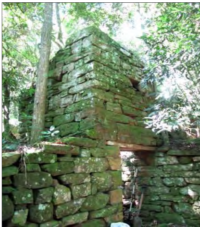
Figura 38. Puerta de entrada a la planta baja de la Estructura II (cara sur). La dimensión de los bloques y el modo en que fueron empleados muestran un diseño diferente al observado en la Estructura I.
