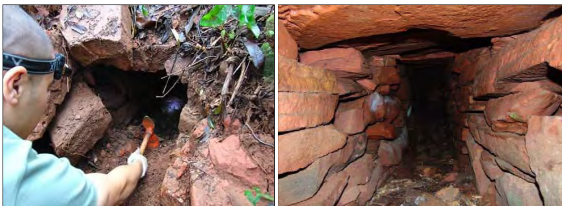
Figura 40. Tareas de limpieza del túnel permitieron relevar la irregularidad de los bloques de arenisca que lo componen.
