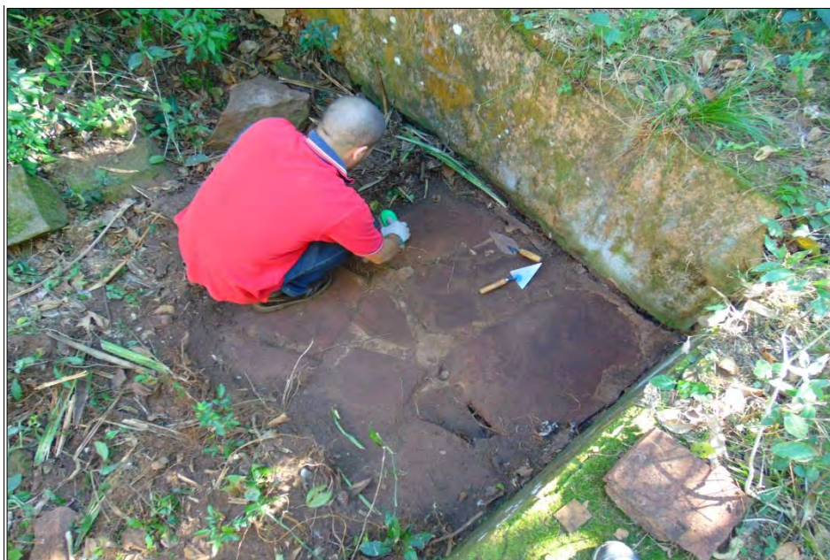
Figura 35. Trabajos de limpieza y despeje permitieron observar el piso de lajas irregulares que posee la veranda. Nótese los muros bajos revocados. (Fotografía A. Igareta)
