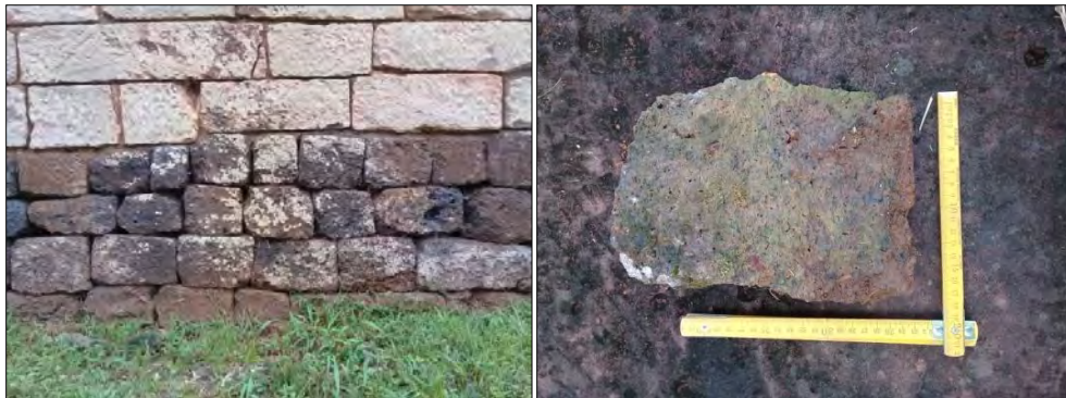
Figura 16. Sector externo del muro de la Capilla de Loreto de donde se extrajo la muestra de itacurú . Nótese la utilización de ambos tipos de rocas en la construcción del mismo. (Fotografías del autor)
