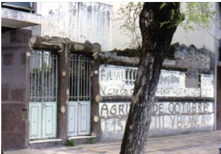
275. Fachada de la casa con la estructura de troncos que sostienen rocas y su doble entrada; demolida (Foto del autor 1990).
