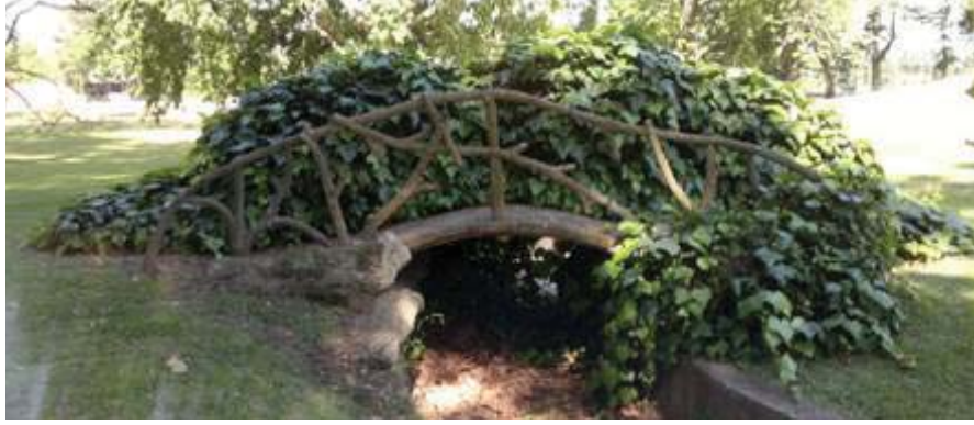
366. Puente de rocalla sobre uno de los arroyos artificiales del Talar de los Pacheco (Foto P. Frazzi 2013).
