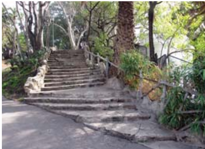
212. Escalera de rocalla con barandal de falsa madera muy deteriorado (Foto del autor 2012).
