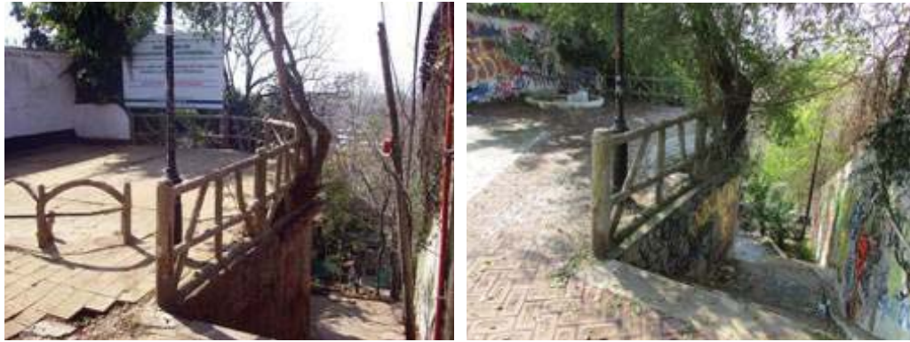
320.321 Bajada El Potro antes de su restauración y después con las barandas del frente desaparecidas (Fotos del autor 2010 y 2013).
