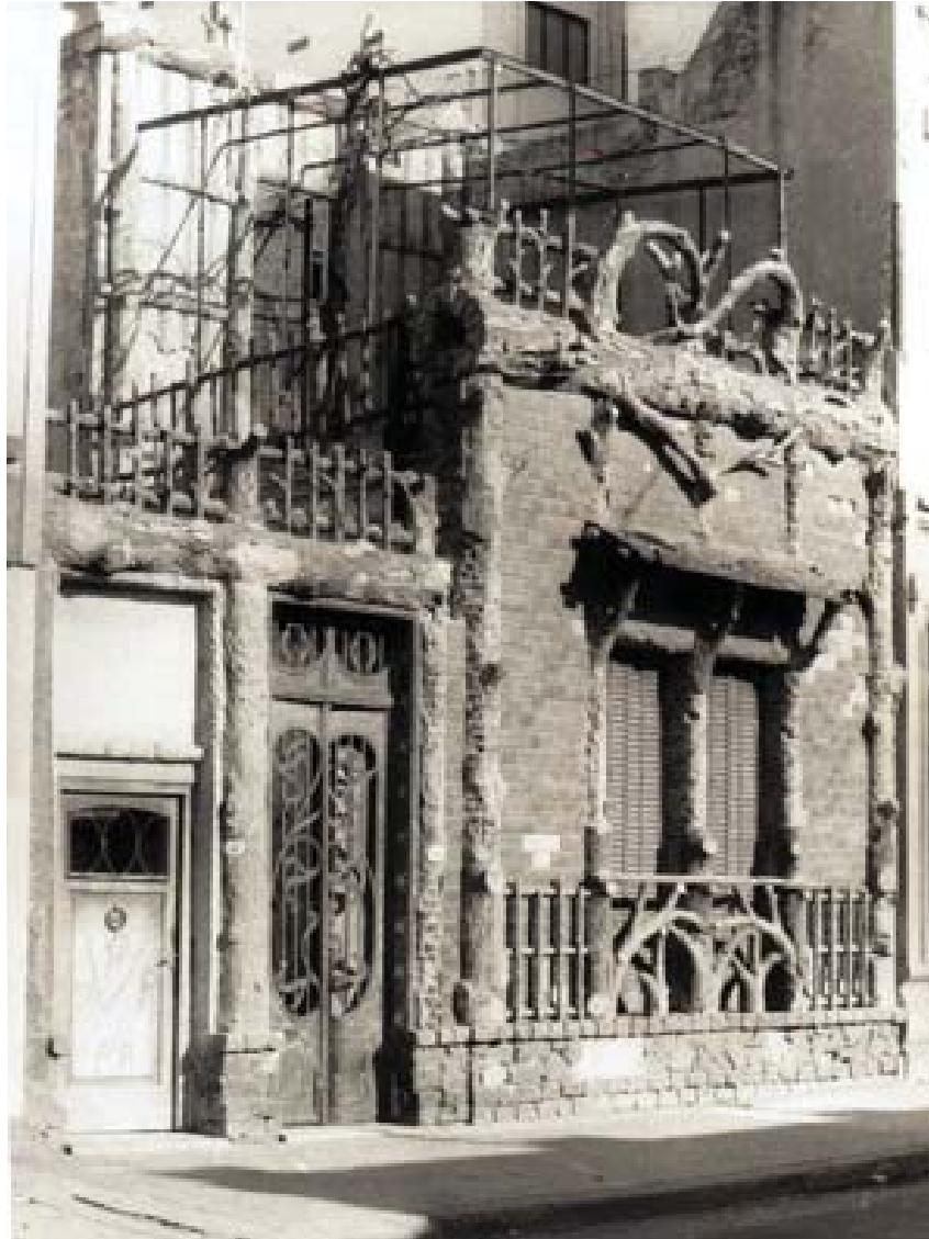
258. Fachada de la casa con sus dos puertas y las ventanas cubiertas de troncos y ramas sobre el azulejo color verde, hasta las tejas son de cemento; demolida (Foto del autor 1972).
