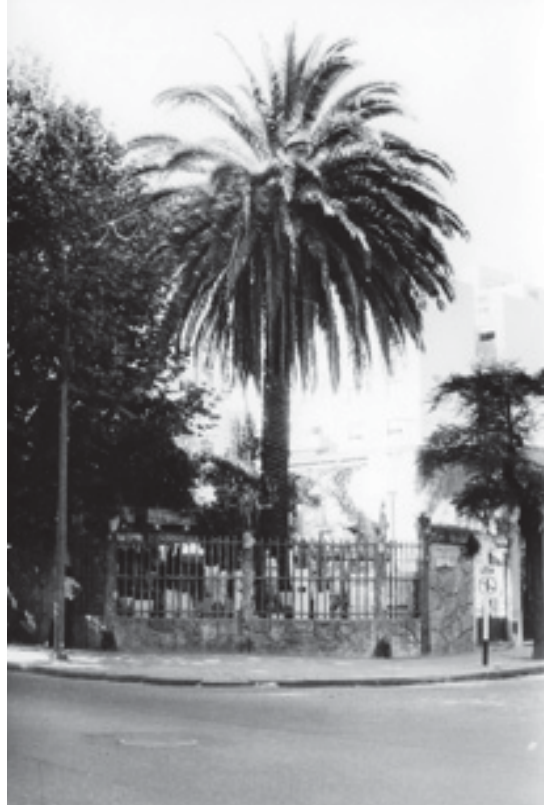
285. Vista general de una esquina de la calle Santos Dumont, totalmente cubierta por símil piedras y troncos incluso en las rejas; demolido (Foto del autor 1972).
