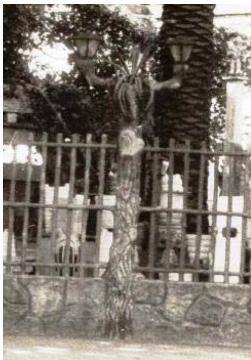
432. Farol de dos lámparas hecho con un tronco y dos ramas de cemento al igual que las rejas; demolida (Foto del autor 1973).
