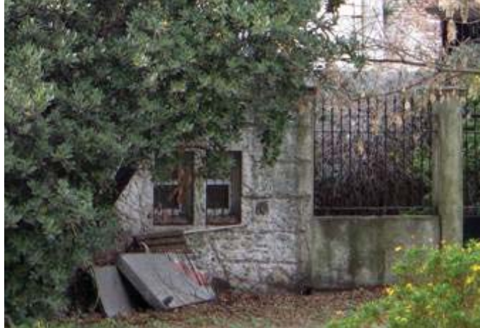
291. Caballeriza de la vieja residencia, se ven las ventanas laterales y el las piedras falsas que la recubren (Foto del autor 2005).
