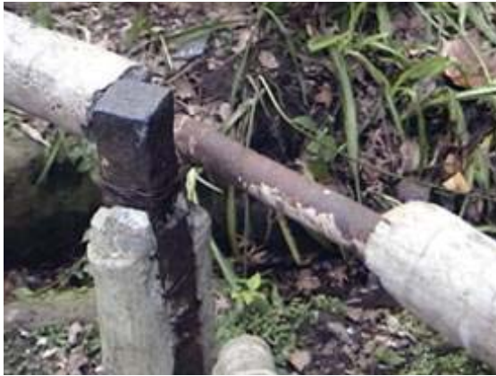
81.82 Barras y caños de hierro unidos con alambres bajo el cemento (Fotos del autor 2012).
