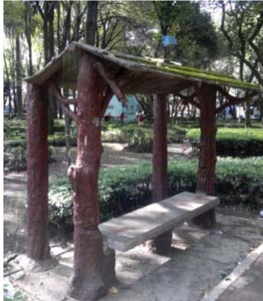
88. Parque México: bancos de falsos troncos y paja en la cubierta de 1926 (Foto del autor 2010).
