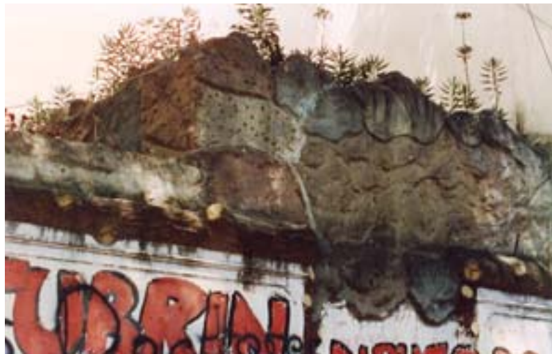
67. Rocas coloreadas en la casa de la calle Warnes, ya demnolida, en una estructura atectónica de ramas que sostienen piedras (Foto del autor 1990).
