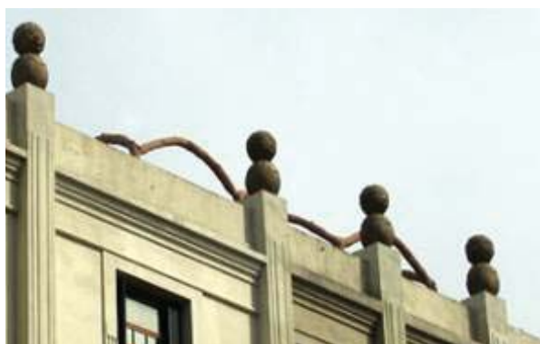
295. Detalle de una pérgola en la parte superior de un edificio de Rodríguez Ortega en 1914, único lugar en que permitió la rocalla (Foto G. Paez 2000).
