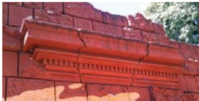
150. La anécdota histórica: un dintel clásico fragmentado entre sillares de falsas piedras, pese a la pintura moderna en el Jardín Zoológico (Foto del autor 2011).
