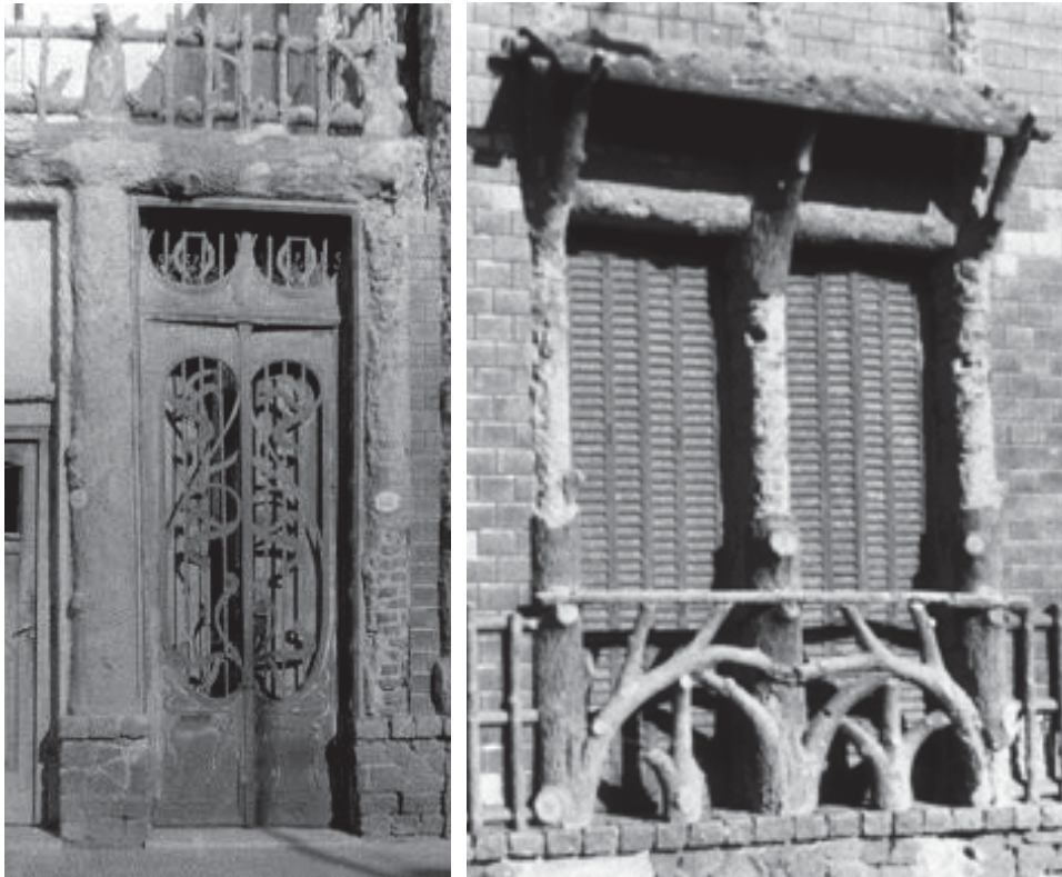
261.262 Puerta Art Nouveau que sobrevivía en la década de 1970 y detalle de la ramazón del balcón y rejas laterales; demolida (Foto del autor 1972).
