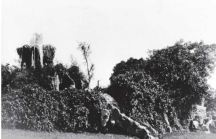
174. Lateral de la estructura que albergaba las grutas y la cascada, una especie de pequeño volcán de agua hecho en rocallas y cubierto de vegetación (Archivo Thays, DGPeIH).
