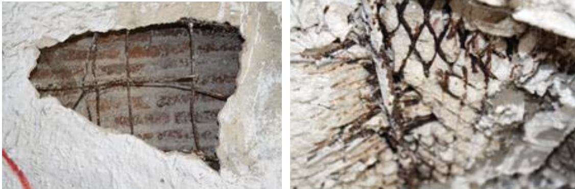
75.76 Cemento sobre malla de hierros cuadrados irregulares y sobre metal desplegado en La Plata (Fotos A. Igareta 2009).
