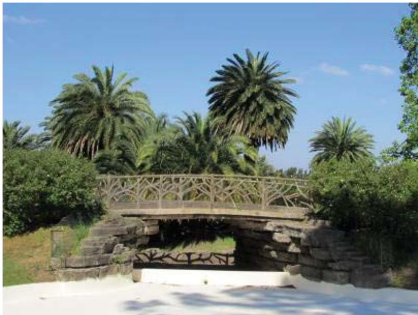
490. Puente completo con doble baranda sobre rocas artificiales (Foto F. Girelli 2013).
