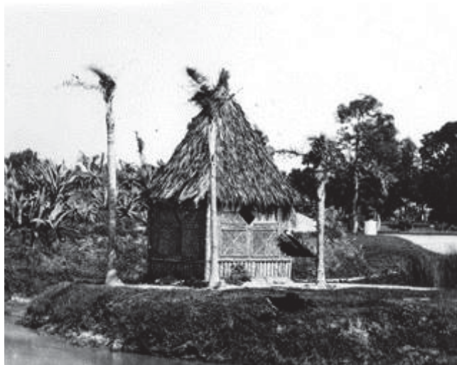
160. Cabaña-kiosco de madera de imitación tropical, en Palermo sobre el antiguo Canal de Rosas, hecho en madera y cañas (Archivo de la DGPeIH).
