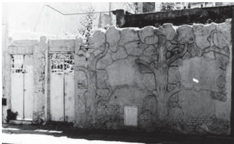
281. Fachada de la casa de la calle Ranos Mejía 1015 con sus troncos que sostienen rocas (Foto del autor 1991).
