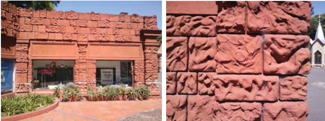
229.230 Detalles de rocallas del serpentario imitando rocas cortadas de lava volcánica, la pintura es actual (Fotos del autor 2012).
