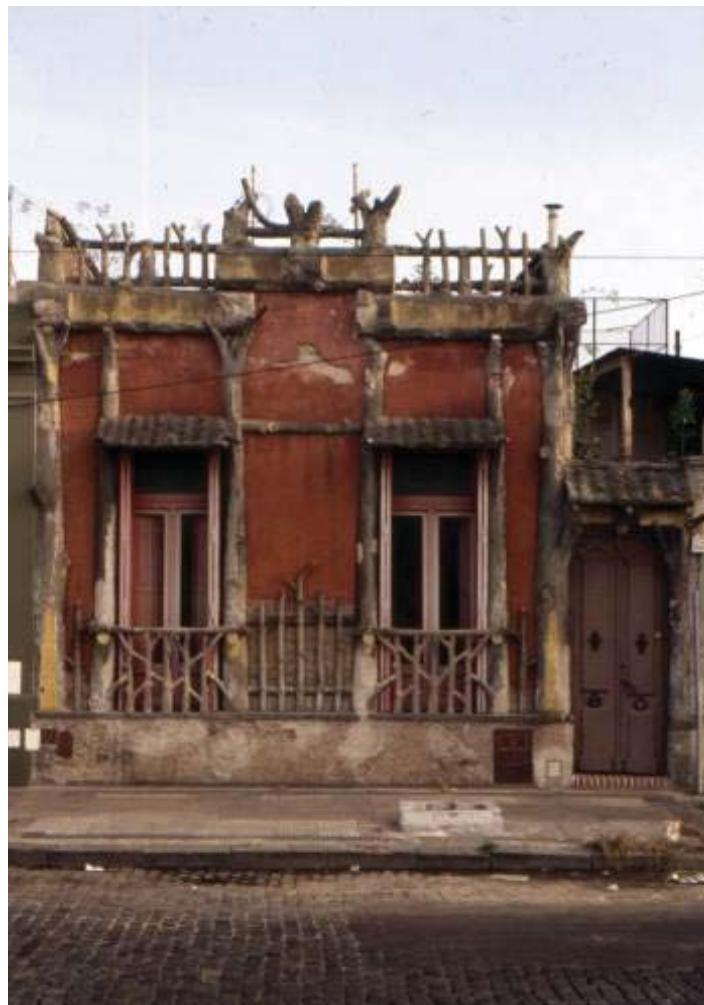
268. Casa con su airosa fachada roja con rocalla de troncos, puerta lateral y dos ventanas en una estructura compositiva clásica, los revoques caídos son parte de la ornamentación; demolida (Foto P. López Coda 1994).
