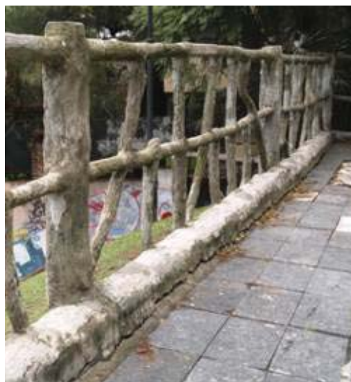
319. Baranda de ramazón ya con arreglos, limitando la barranca (Foto del autor 2011).
