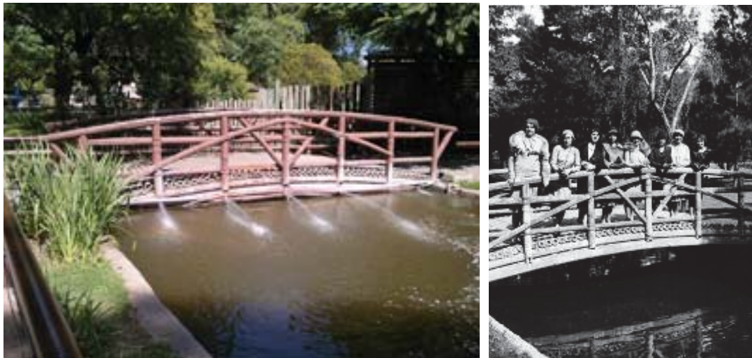
246.247. Puente de cañas falsas con varios niveles de piso para asemejar mayor resistencia y como era disfrutado hacia 1930 (Foto del autor 2012 y cortesía W. Champion).
