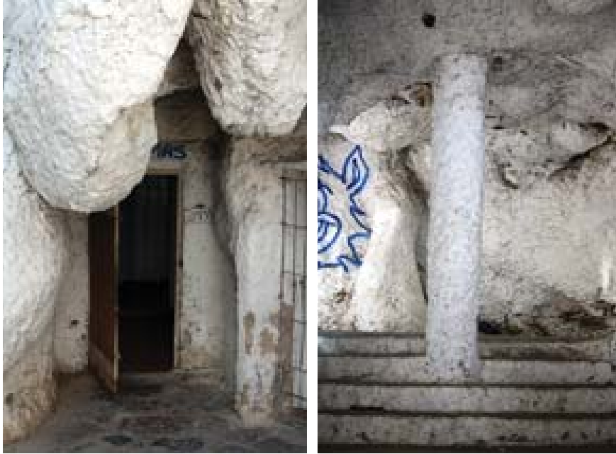
45.46 Lava cayendo y columnas tallados que la sostienen la gruta de La Plata (Fotos A. Igareta 2010).
