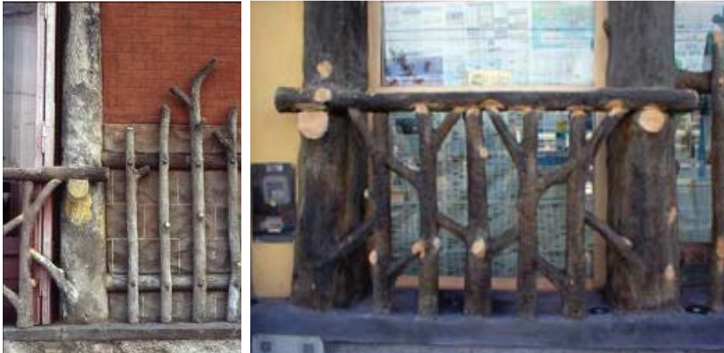
271-272 Detalles de las rejas recubiertas por madera falsa con todos los detalles del estilo antes y después de la remodelación; demolida (Fotos J. Tomasi 2002).
