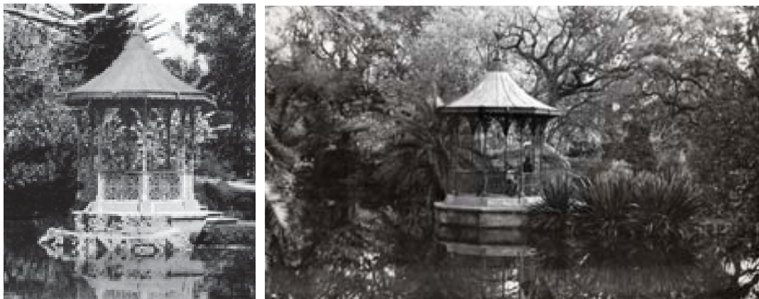
226.227 Kiosco de Palermo, el basamento original de rocalla pasó al cemento alisado hacia 1920 (Postal colección del autor y foto 1985).
