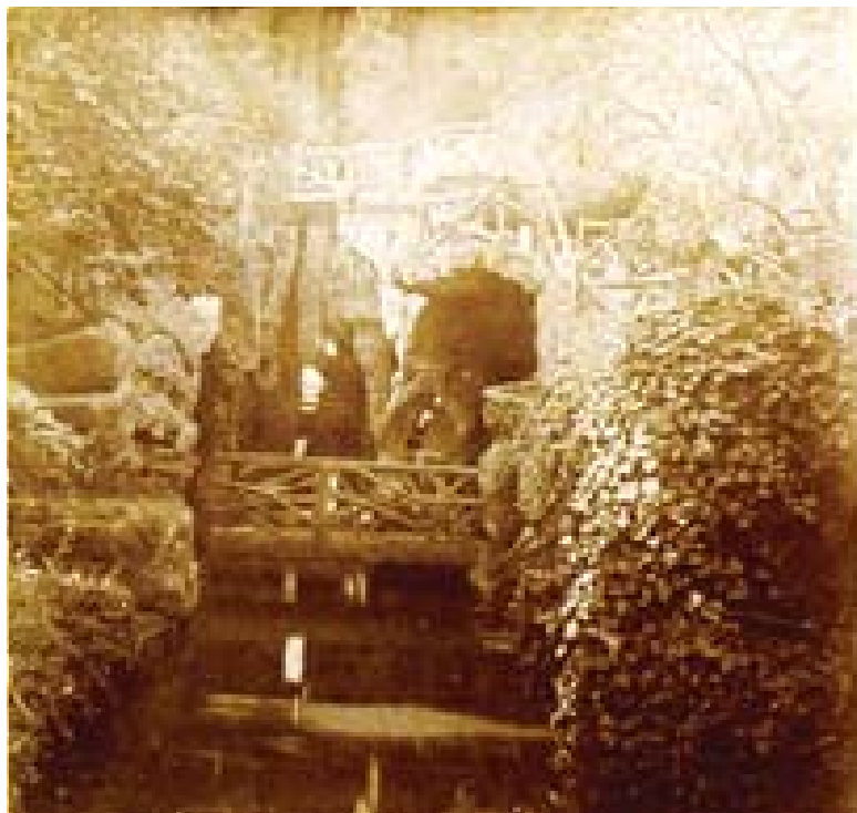
188. Puentes y gruta de acceso al conjunto, en un enjambre de troncos, rocas y ramas de cemento cubiertas del verde natural y el agua (Foto Archivo Thays, DGPeIH).
