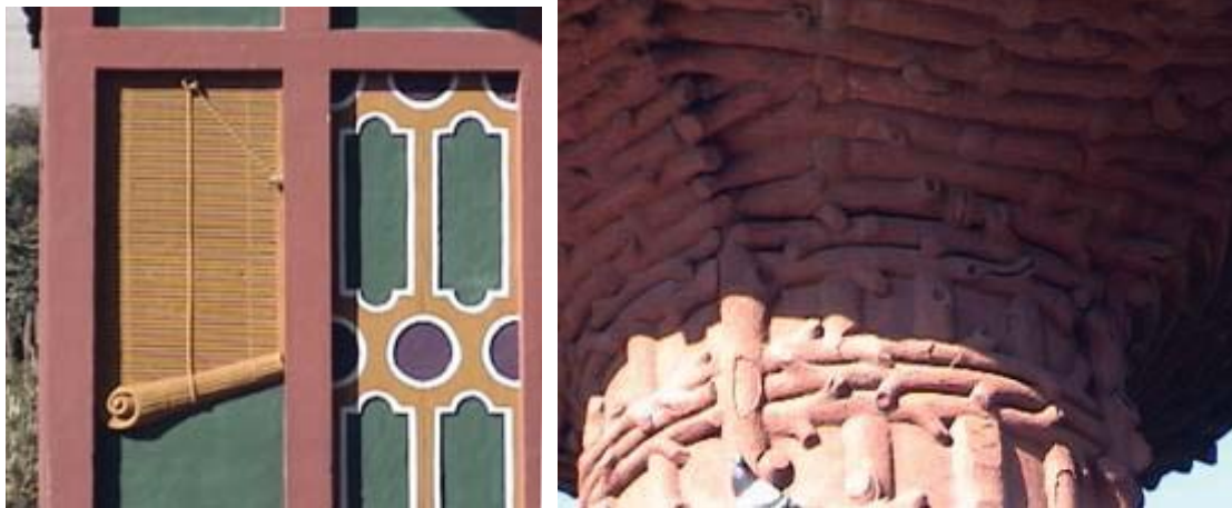
244.245 Detalle de las cortinas de enrollar de junco y las cañas entreveradas del techo (Fotos del autor 2010).
