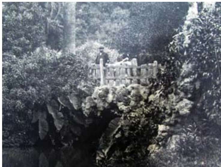
178. Puente de falsa madera con una extraña tabla vertical, todo de cemento, con la rocalla y la lujuriosa vegetación (Archivo Thays, DGPeIH).
