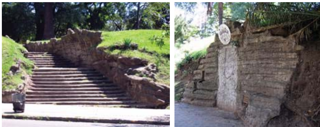
208-209. Fotos actuales de la escalinata y la caseta del cuidador de Barrancas de Belgrano después de los arreglos de 2009 (Foto del autor 2010).
