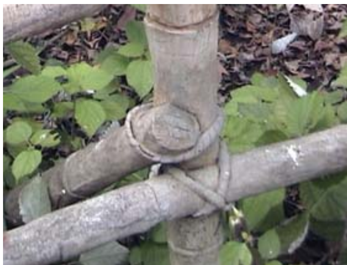
200.201 Detalles de la excelente manufactura de los puentes, con troncos con la corteza saliente, sogas para atarlos cuando semejan cañas y clavos cuadrados para la madera (Fotos del autor 2011).
