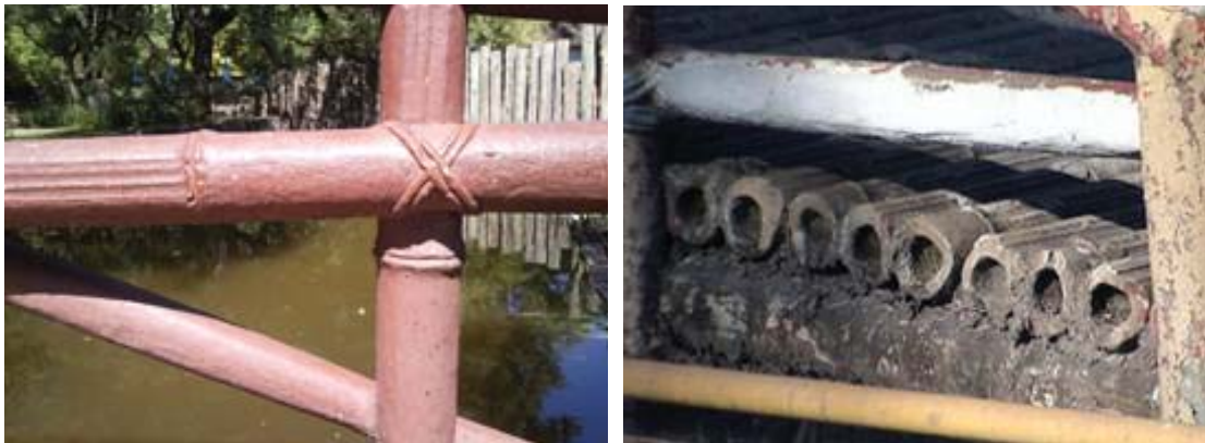
36.37 Cañas de bambú en cemento unidas con barro y atadas con fibras vegetales en el Jardín Zoológico de Buenos Aires (Fotos del autor 2008).
