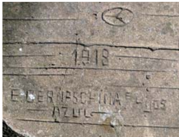
122. Firma de E. Cernaschina e Hijos de 1918 en la localidad de Azul. Se observa la imitación de tablas y una manera típica de representar un nudo de la madera (Foto A. Igareta 2012).
