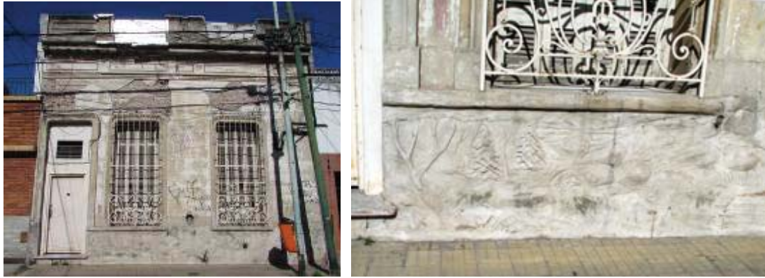
305.306 Relieve en la parte inferior de la fachada; en demolición (Fotos F. Girelli 2013).
