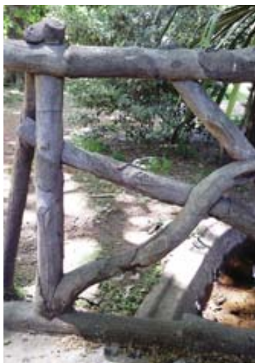
200.201 Detalles de la excelente manufactura de los puentes, con troncos con la corteza saliente, sogas para atarlos cuando semejan cañas y clavos cuadrados para la madera (Fotos del autor 2011).
