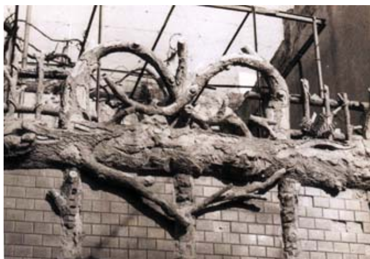
260. Detalle del tronco y la ramazón sobre las ventanas que sirve de resguardo a la terraza del primer piso como moño decorativo; demolida (Foto del autor 1972).
