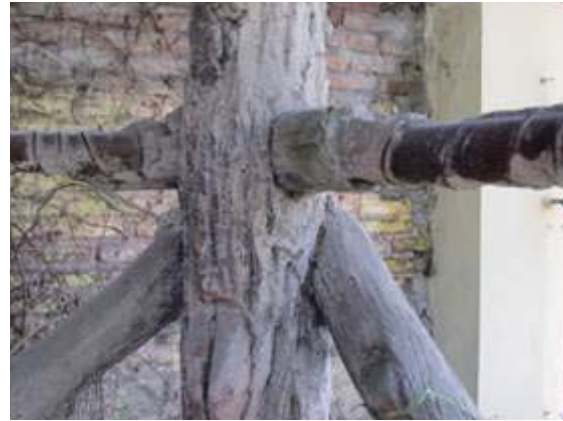
81.82 Barras y caños de hierro unidos con alambres bajo el cemento (Fotos del autor 2012).
