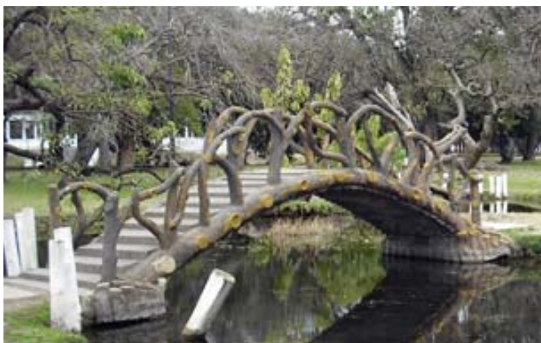
325. Puente de rocalla de la plaza Saavedra en La Plata, conservado con el lago en una excelente obra en su estilo (Foto D. Gonet 2012).
