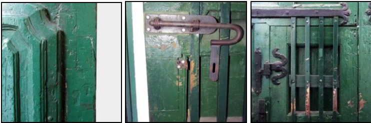
Fig. 5. Detalle de las intervenciones modernas 2, 3 y 4
