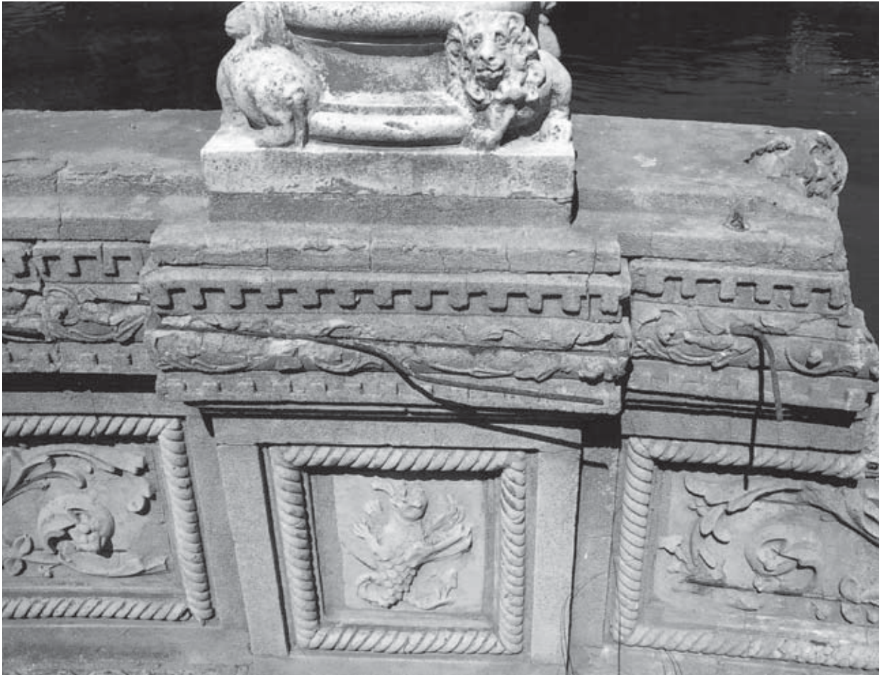
Relieve de la parte inferior hecho con placas premoldeadas. (Fotografía Patricia Frazzi).
