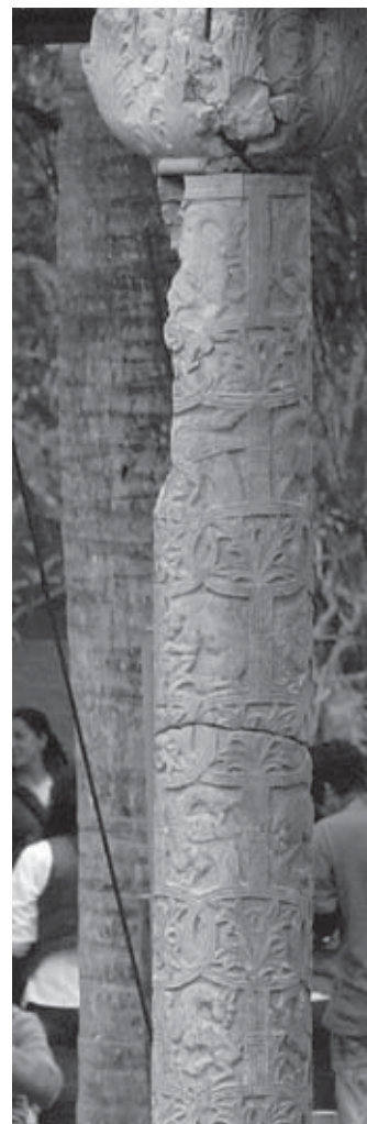
Columna de cemento con hierro en su interior. Nótese la peculiar forma de rotura por el óxido de su estructura. Es la única realmente moderna (1907).
