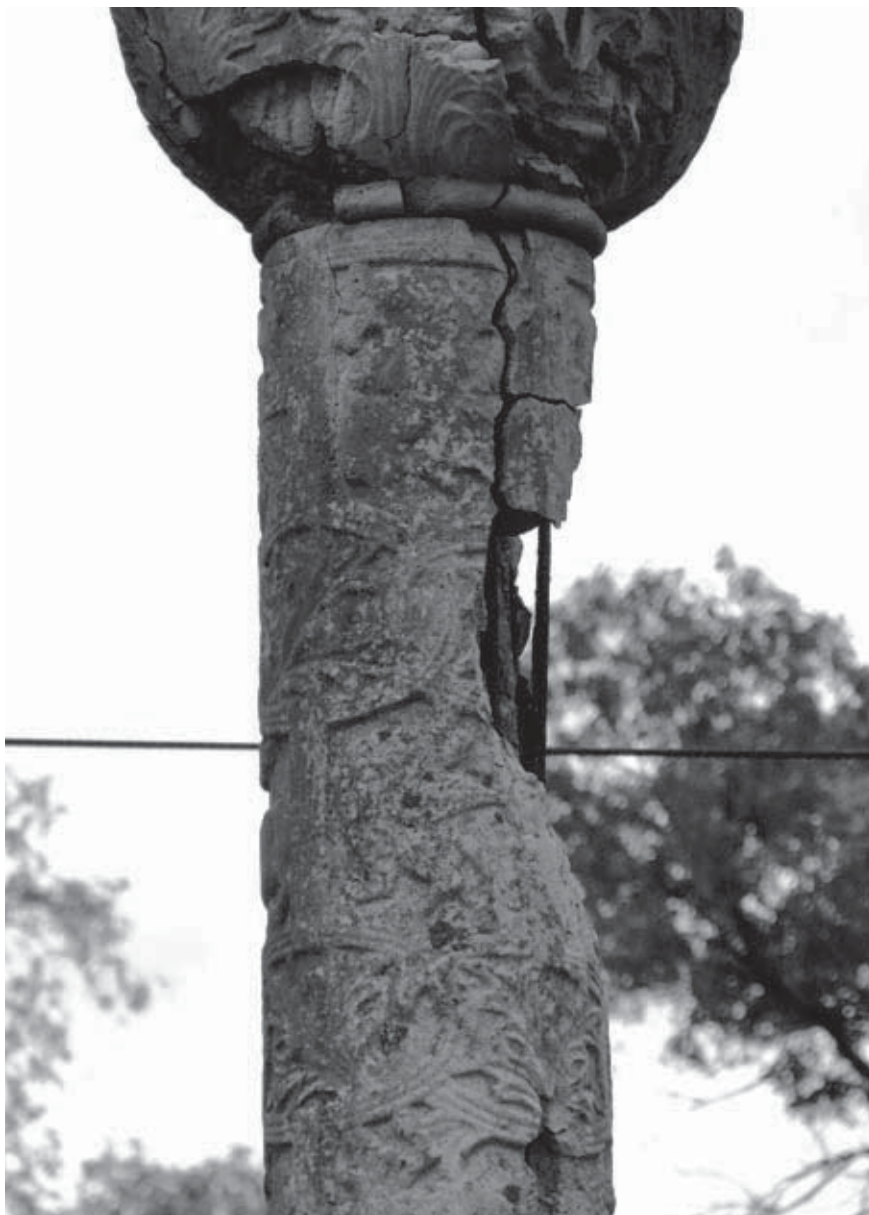
Columna de cemento con hierro en su interior. Nótese la peculiar forma de rotura por el óxido de su estructura. Es la única realmente moderna (1907).
