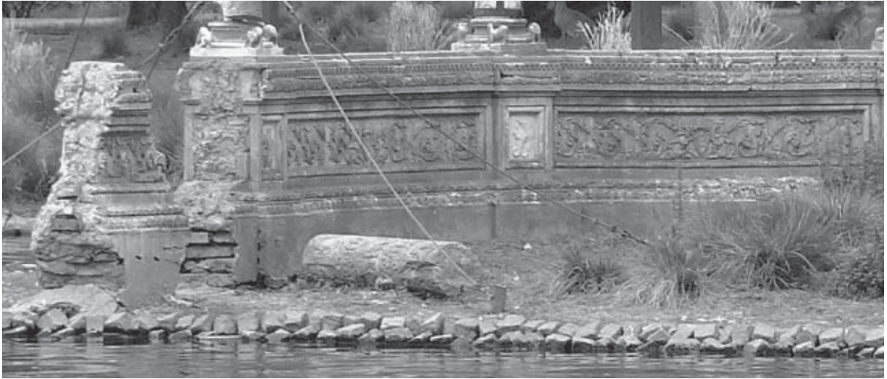
Relieve de la parte interior hecho con placas premoldeadas. (Fotografía Patricia Frazzi).
