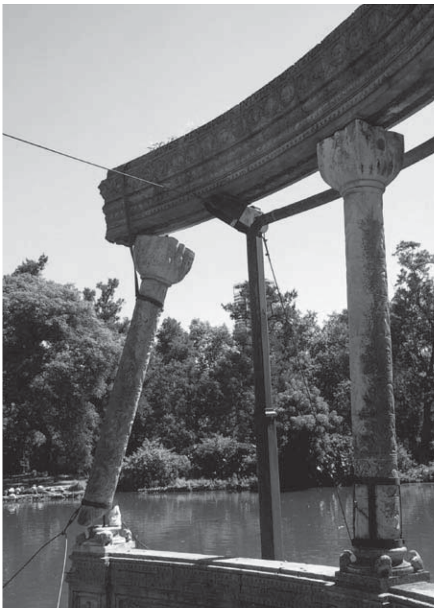
Estado actual del conjunto en situación casi terminal (2012). (Fotografía Patricia Frazzi).
