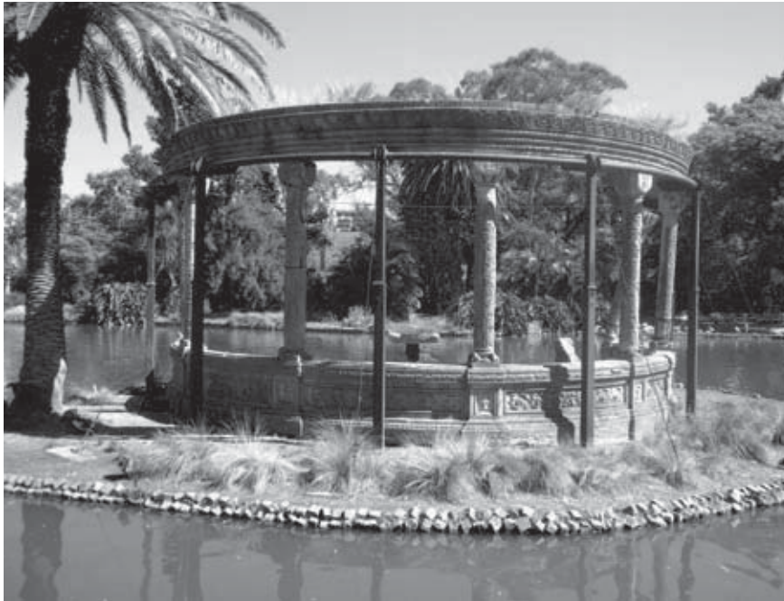
Vista del Pórtico e isla desde su frente, nótese la estructura de soporte externo. (Fotografía Patricia Frazzi).
