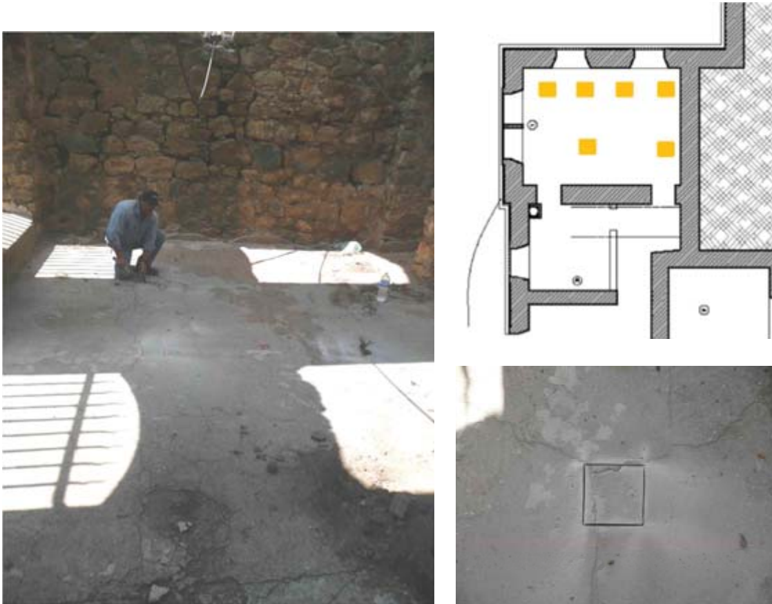
Comienzo de la intervención en el recinto 1 por personal de obra y detalle del corte de la carpeta de cemento (arriba) y vista de los trabajos de revisión de sedimentos por el equipo arqueológico (siguiente página)
