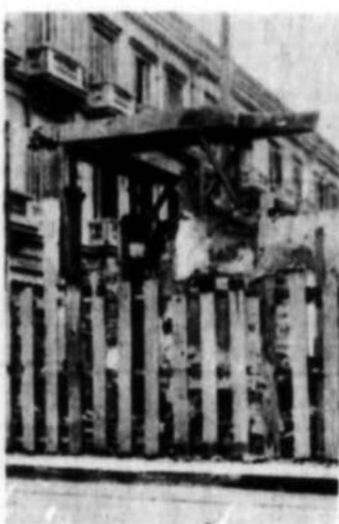
Fig. 4. Vista lateral del pilar y vigas de la "portada en esquina" de las calles Chacabuco y Moreno
