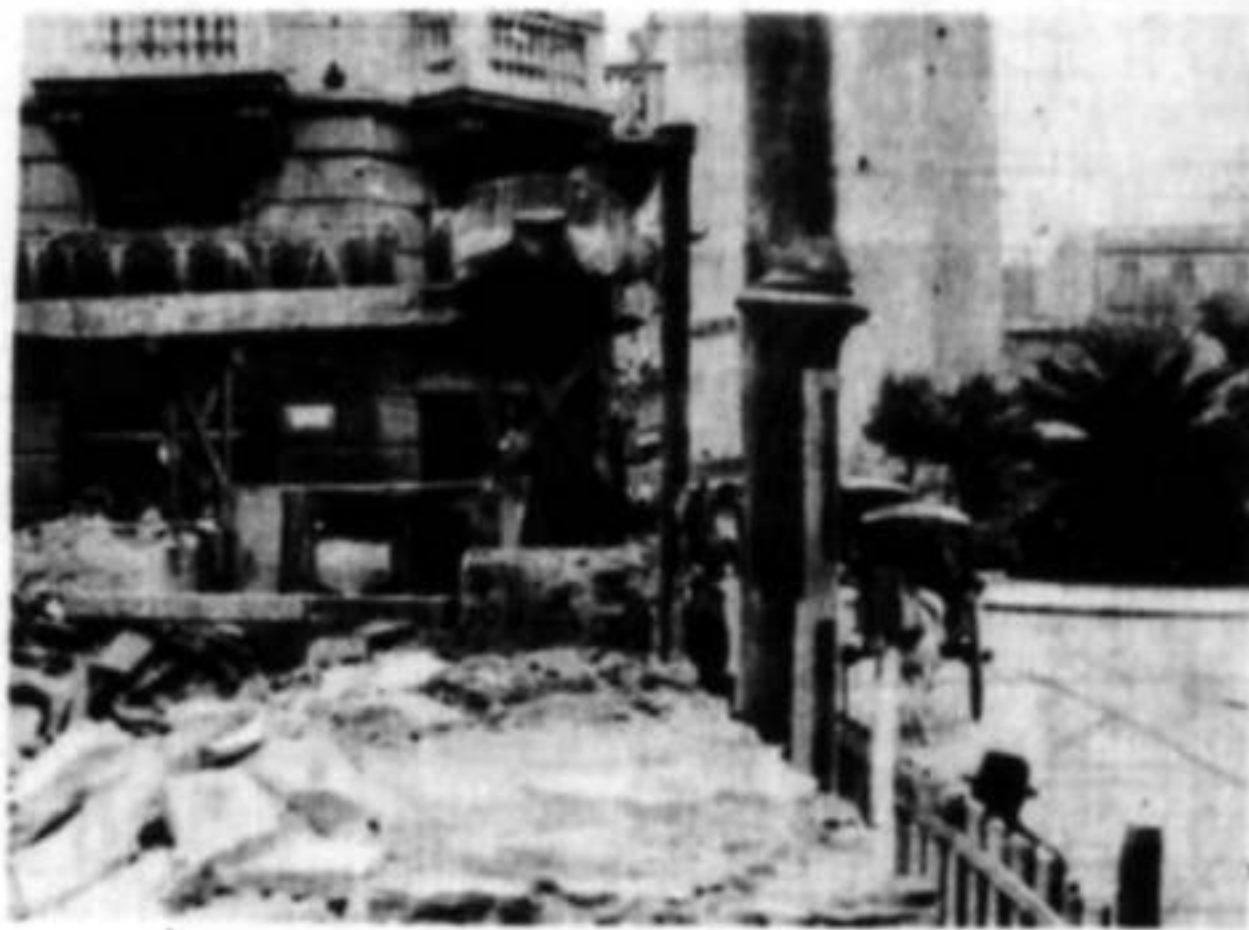
Fig. 5. Vista interna del dispositivo constructivo de la "portada en esquina" de las calles Chacabuco y Moreno
