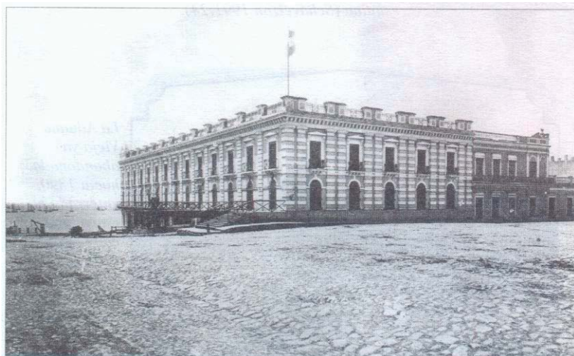
El edificio de Rentas Nacionales obra de Eduardo Taylor mostrando las fachadas en la parte superior de la barranca al río (foto Archivo IAAeIE).
