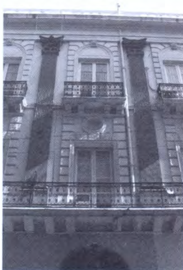
Detalle de las pilastras y ventanas con modillones y óculos que imita casi exactamente el frente del Club del Progreso (foto G. Paez).
