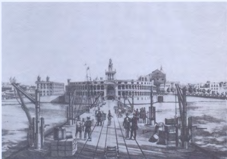
El muelle y la Aduana ya construidos, con su sistema de guinches y vagonetas sobre rieles, transformaron al puerto en una maquinaria moderna y eficiente (Colección privada, Buenos Aires).
