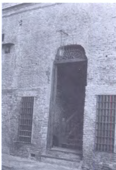
Antigua entrada principal, ahora más baja (ver el arco encima de la puerta), aprovechaba su ubicación para usar el desnivel y facilitar el descenso de las cargas dentro del depósito.
