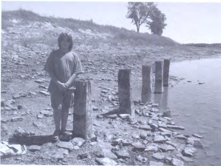
Restos del puente sobre el Salado: Áreas de amarre de botes y las bases de las columnas de madera de la cimbra usada en la obra (fotos V. Furci).
