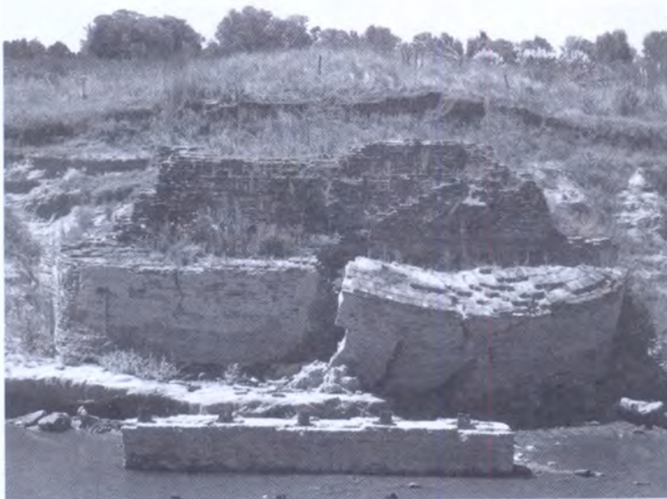
Restos de los extremos aun visibles del puente sobre del Río Salado (fotos V. Furci)
