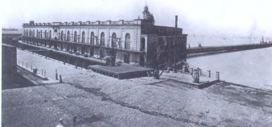
Vista de la parte posterior de la aduana, con el Patio de Maniobras bajo nivel en su frente. Observar la decoración idéntica a otras obras de Taylor (Instituto de Arte Americano).
