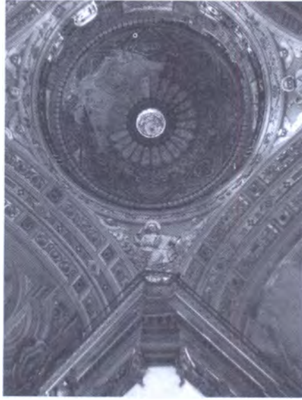
Cúpula interior que conserva la decoración original.
