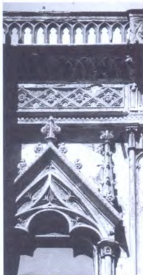
Detalle remanente de la ornamentación neogótica de la residencia, muy posterior a la arquitectura de Taylor.
