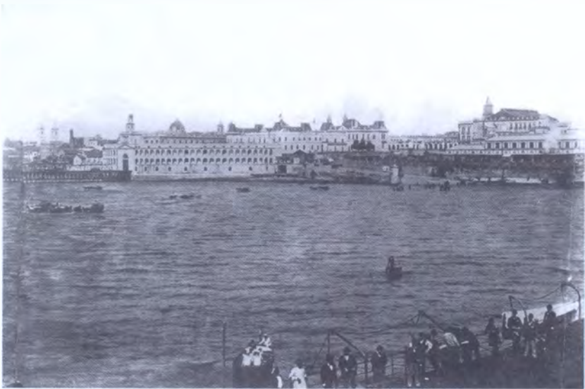
Vista de la costa desde un barco. La Aduana es el edificio central, aun circulaban carros de caballos que llevaban la mercadería por una rampa ubicada a la derecha del edificio (Instituto de Arte Americano).
