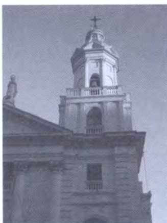
Detalle de la torre y su remate con azulejos.
