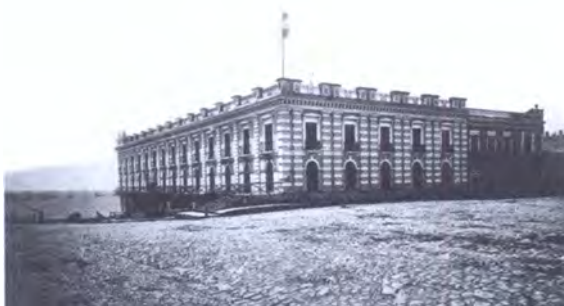
Fachada sobre la calle Bolívar, ya pintada de colores (Instituto de Arte Americano).
