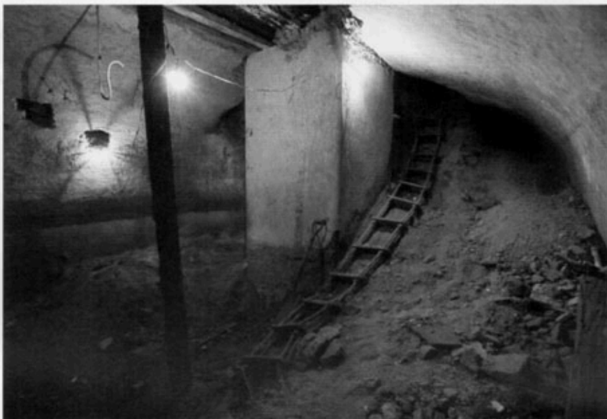
El sector oeste de la cisterna, el pilar central fue agregado al descubrirla en 1910, para evitar el derrumbe.
