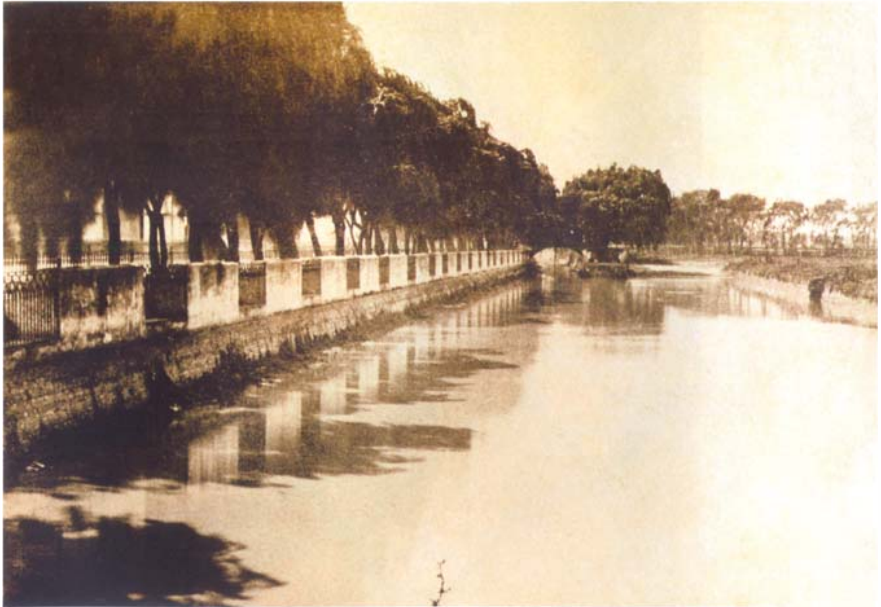
El gran estanque de Palermo, abandonado; aún se ve el puente al fondo y las rejas que lo separan del camino de entrada al sitio.
