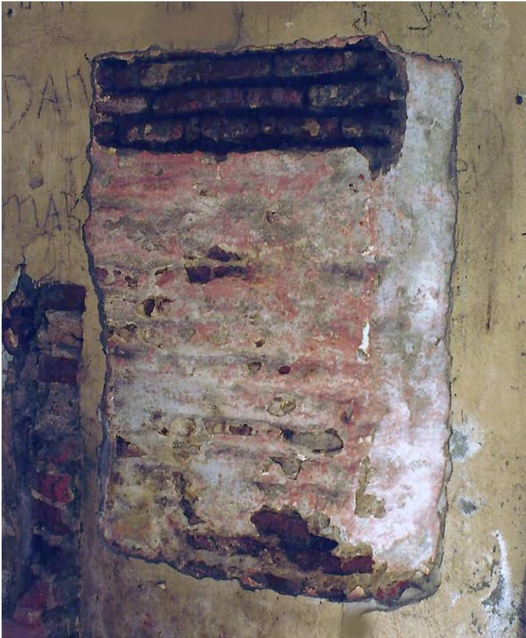
*Detalle del muro original pintado a cal color rosa pálido, luego recubierto con varias capas de blanco hasta el cemento moderno*
