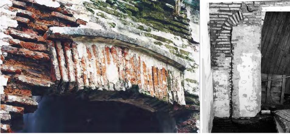
*Detalles de la arquitectura temprana: dintel unido con cal y paredes con barro, nótese como fue alterada la puerta interior*
