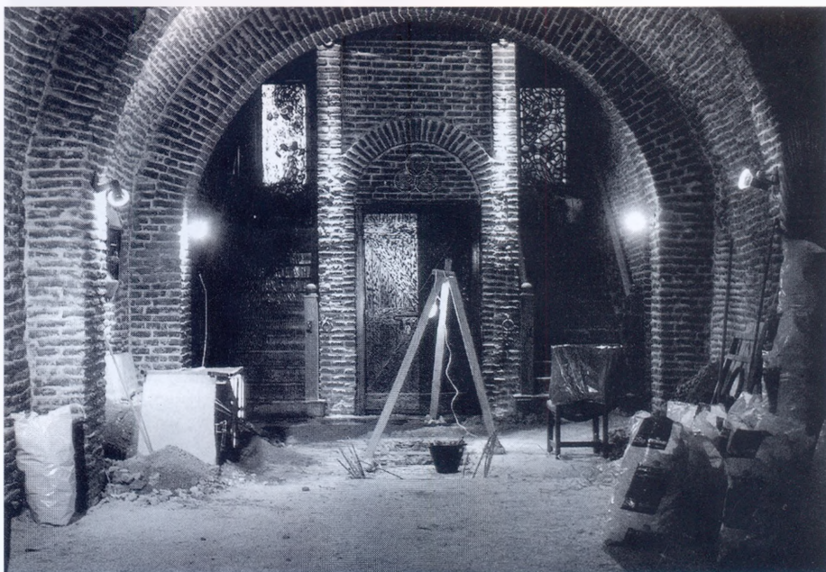
LAS TÉCNICAS ARQUEOLÓGICAS: interior de Michelángelo en la calle Balcarce donde en planta baja sólo fue posible excavar por cuadrículas debido a la estructura de hormigón preexistente en los suelos.
