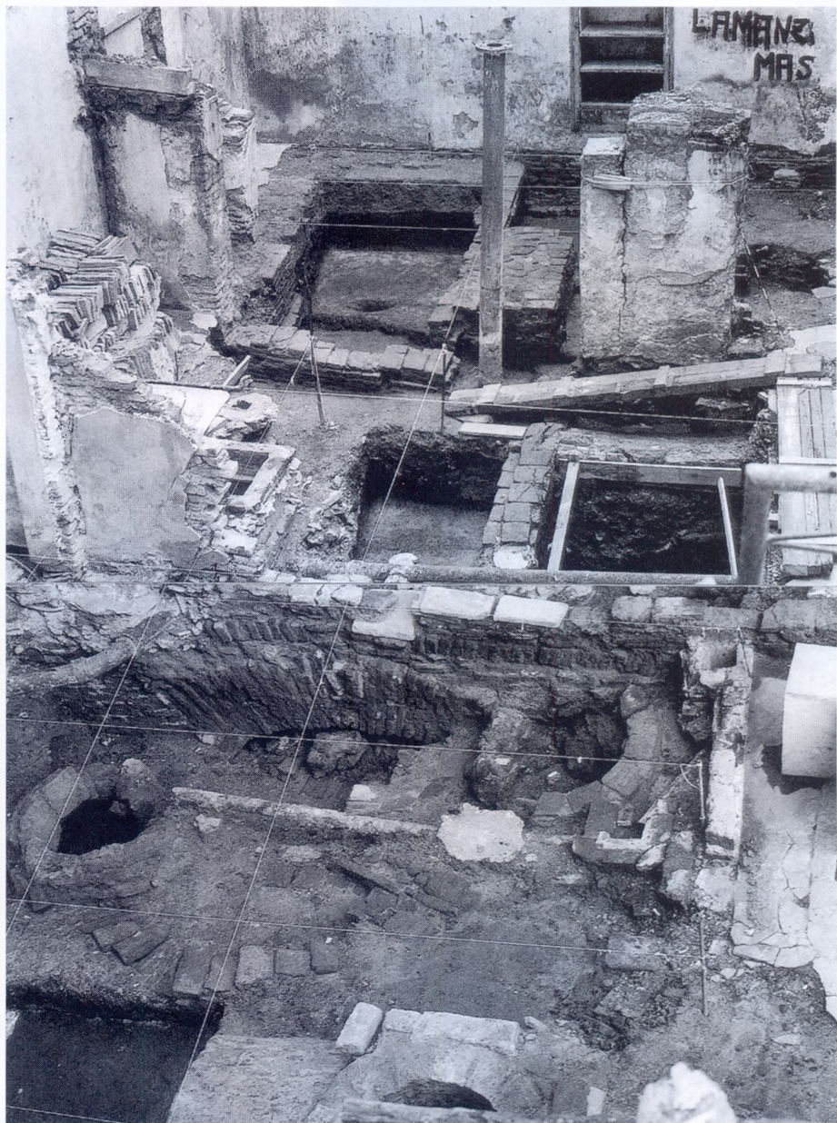
Excavación en el patio del fondo de la antigua Casa Ezcurra; nótese la cantidad de pozos de desagüe y muros de diferentes épocas; al fondo el sector con suelo conservado desde el siglo XVI.
