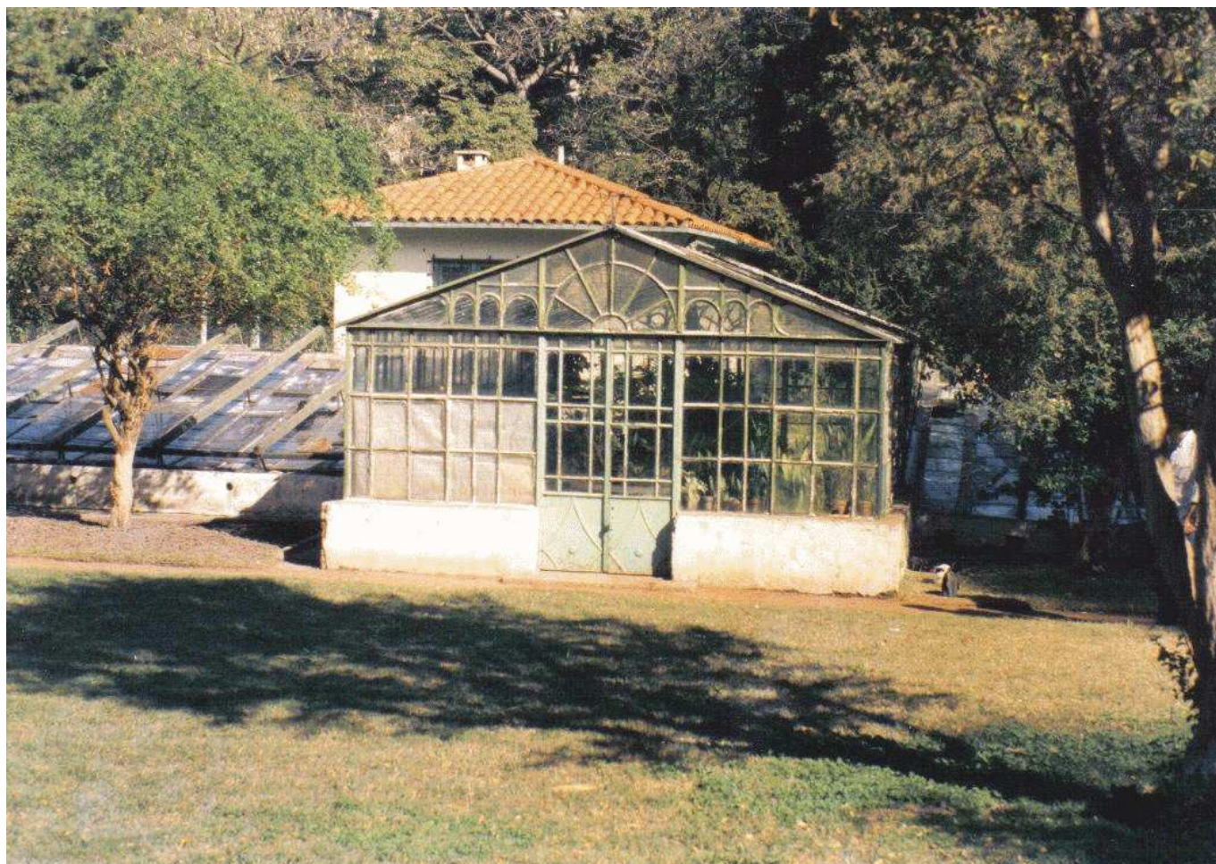
Figura 2. Vista del Invernadero Caliente desde el frente como existía en 1986. A los lados de la estructura de metal hay dos cuerpos semisubterráneos.
