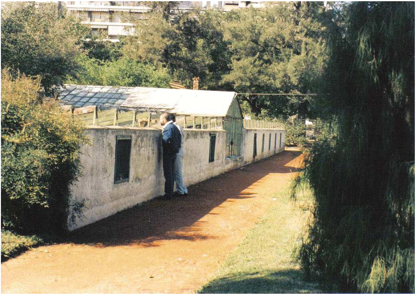
Figura 3. Vista posterior del antiguo Invernadero Caliente (1986). Las paredes, ahora desaparecidas, sostenían el techo inclinado de vidrio.
