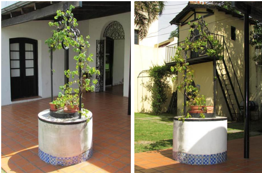
FIG. 9. El aljibe tan pintoresco como se lo ve actualmente y que ha perdido gran parte de su valor convirtiéndose en un testimonio falso (Foto: Autor)
