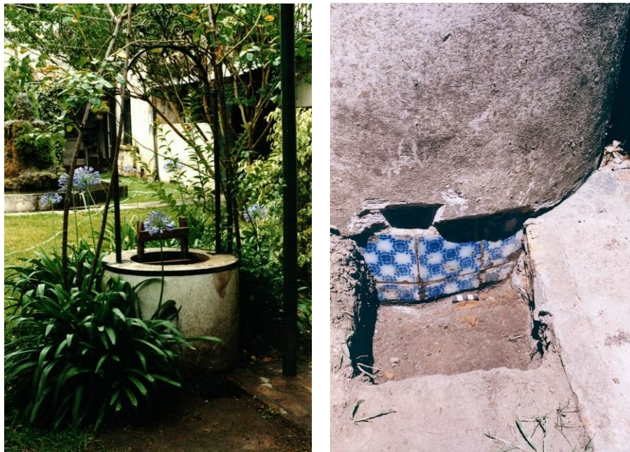
FIG. 2. El brocal como se encontraba en 2001 y detalle del primer sondeo donde apareció el zócalo de azulejos (Foto: Archivo CAU)
