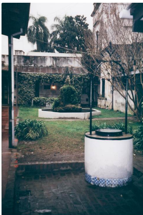
FIG. 4. Brocal luego de la restauración con el nivel de piso original (Foto: Archivo CAU)
