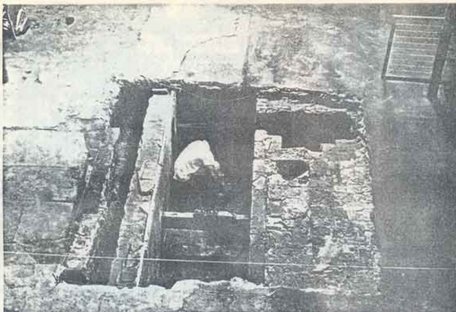
5. Cuadrículas con los soportes de madera del generador eléctrico original de la imprenta.
