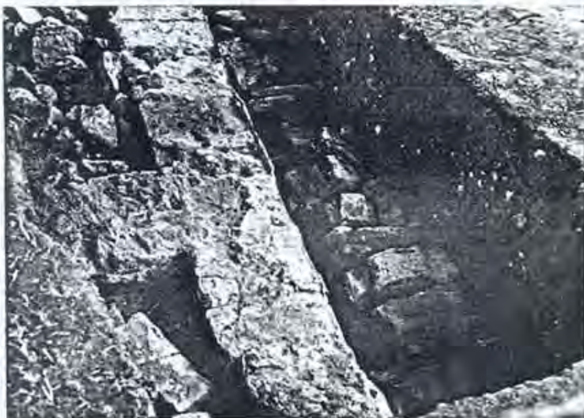
Tras la demolición el escombros del muro fue acomodado en el lado exterior de la casa, posiblemente para facilitar las tareas de los obreros.
