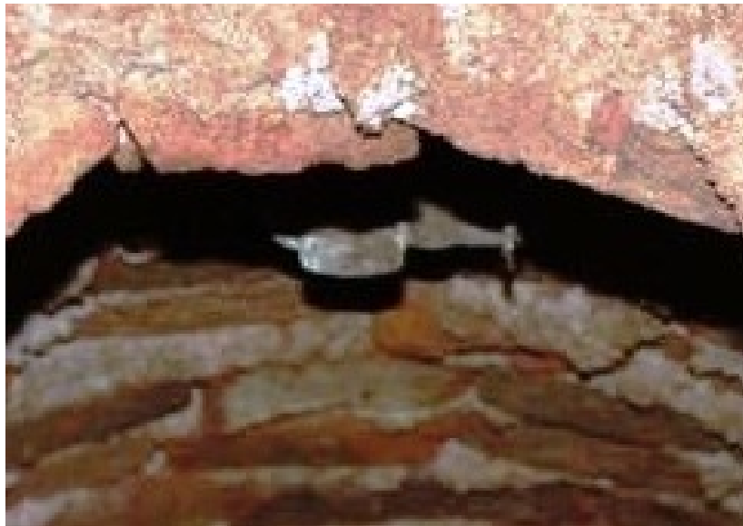
Detalle de la válvula de entrada de descarga de agua.
