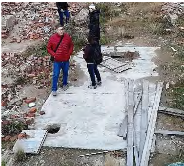
105. Depósito de agua hecho de hormigón en la década de 1990 y ubicado en el centro del patio. Se observan dos accesos, el posterior con su tapa hundida era el original, el delantero aparenta ser un agujero reciente. Su construcción debió dejar sin uso el pozo de ladrillos.
