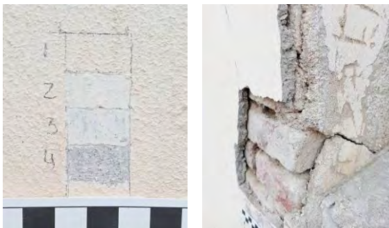
57- 58. Cala 1 (Fachada) a 1.47 m del suelo y vista del muro de ladrillos, el revoque y las delgadas capas de pintura.
