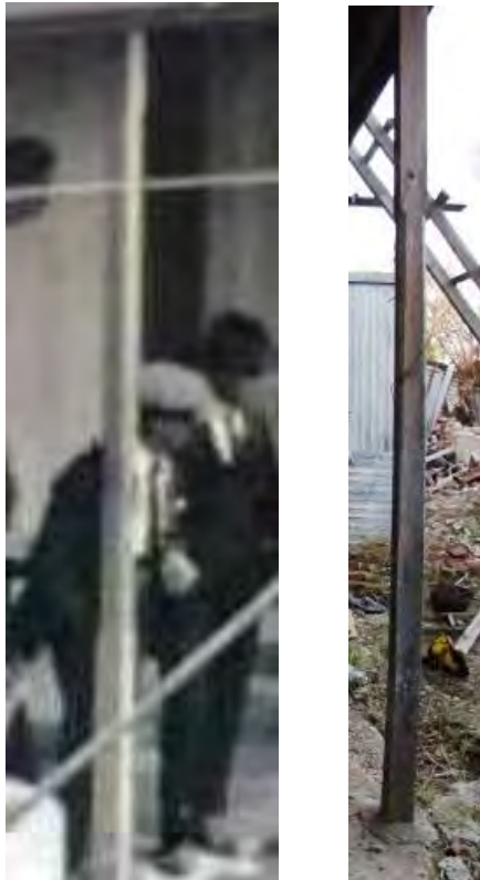
95- 96. Las columnas de la galería del patio: las originales a la izquierda con sus sectores más elaborados y el estado actual en que son ligeramente diferentes, incluyendo el arreglo para colocarlas en el piso.
