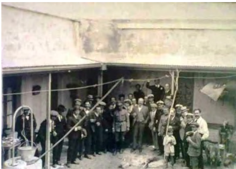
23. Fotografía el interior del patio (el frente a la izquierda) cuando funcionaba como comisaría. En la parte superior hay un muro del lado derecho, hoy inexistente.
