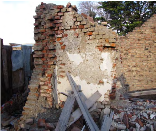
50. Muros de mampostería de ladrillos de buena calidad y regular dimensiones, unidos con barro, cubiertos con revoque de cal.
