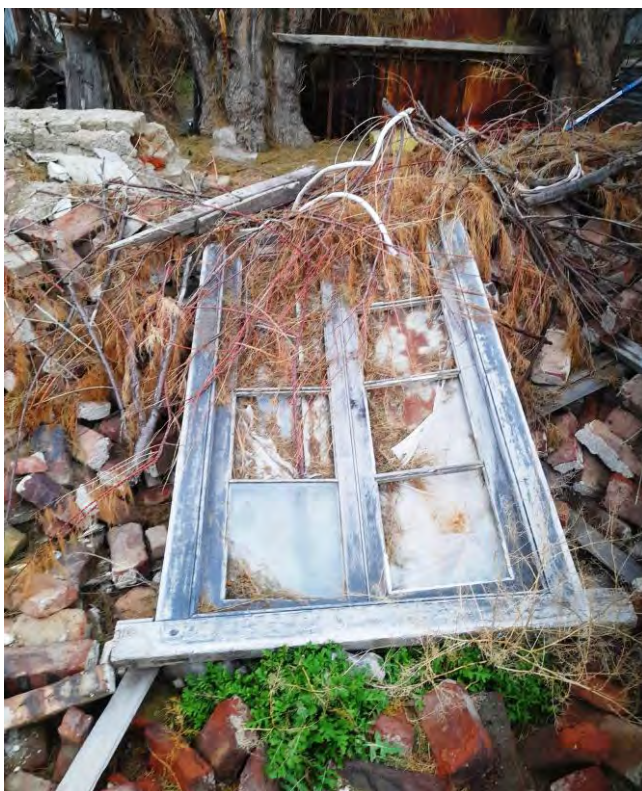
72. Ventana del Ambiente 8. Nótese que tiene vidrios enteros y que está colocada encima del escombro, que no cayó junto con la pared.
