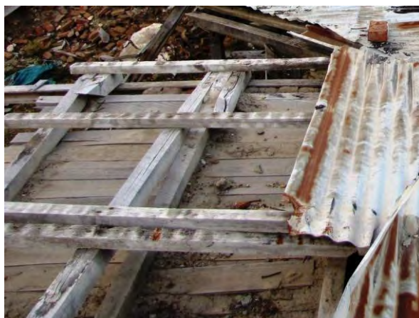
55. Ejemplo de la utilización de maderas colocadas de forma irregular para ayudar a las vigas del techo a sostener las canaletas de desagüe ya desaparecidas.
