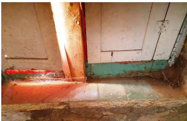
88- 89. Ventanas a la calle: baldosas en el antepecho y batientes internas originales, al igual que los herrajes, pero falta la parte superior que cubría la banderola. Han sido alteradas en varias oportunidades.
