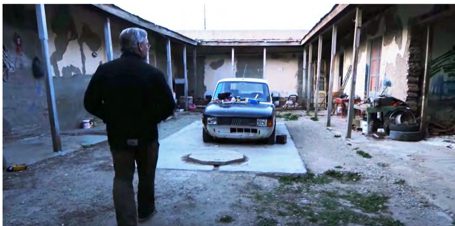
24. Vista del interior del patio en 2016: el aljibe nuevo al centro bajo el automóvil, las tres puertas tapiadas y el Ambiente 9 parcialmente demolido. El lado Oeste ya estaba tapiado para circular por dentro (Cortesía Pablo Walker).
