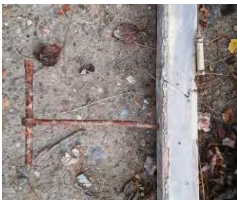
75-76. Sistema de fijación de las carpinterías a los muros, mediante hierros forjados reusados.
