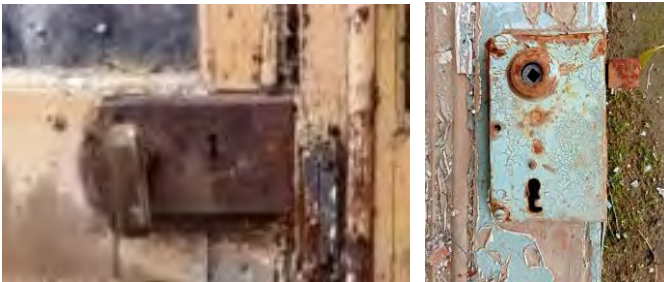
91- 92. Antiguas cerraduras, similares pero no iguales, aun en las puertas y sin modificaciones posteriores salvo el deterioro.
