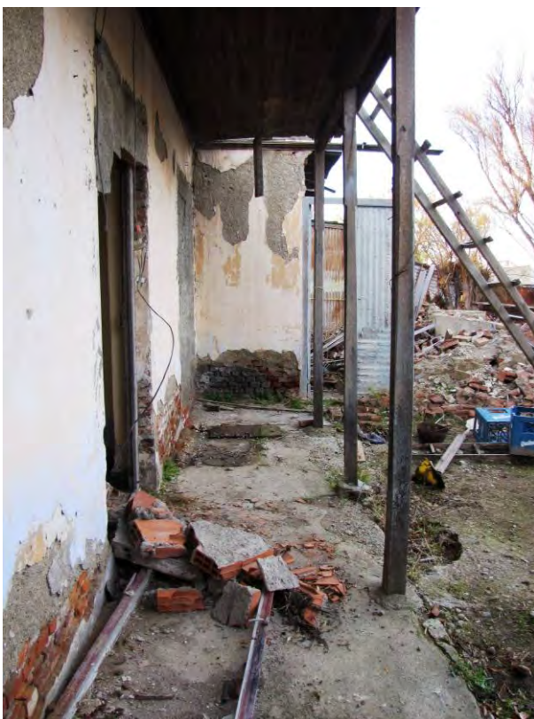
43. Galería de acceso al patio con la puerta, el piso de cemento y las columnas de madera en la actualidad.
