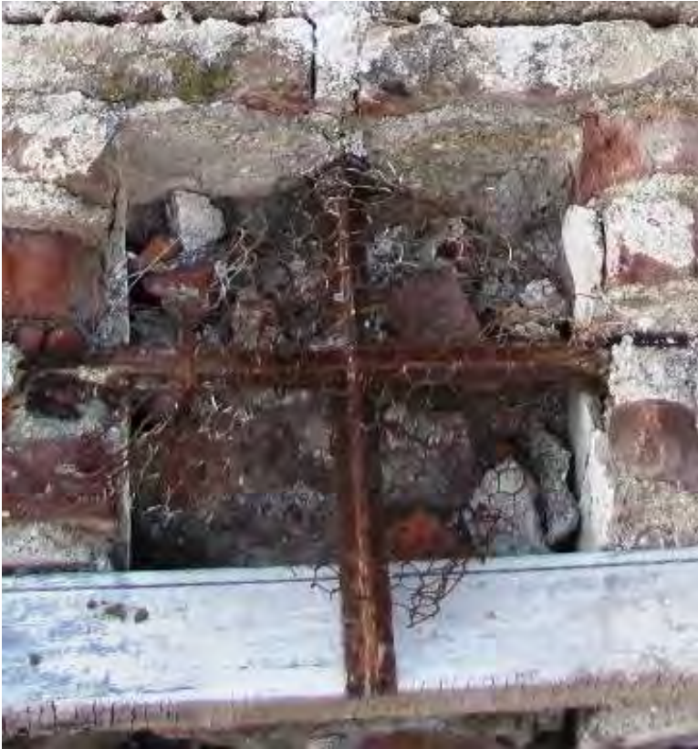
133. Detalle del cerramiento de la ventana del Ambiente 8, posible celda para prisioneros.
