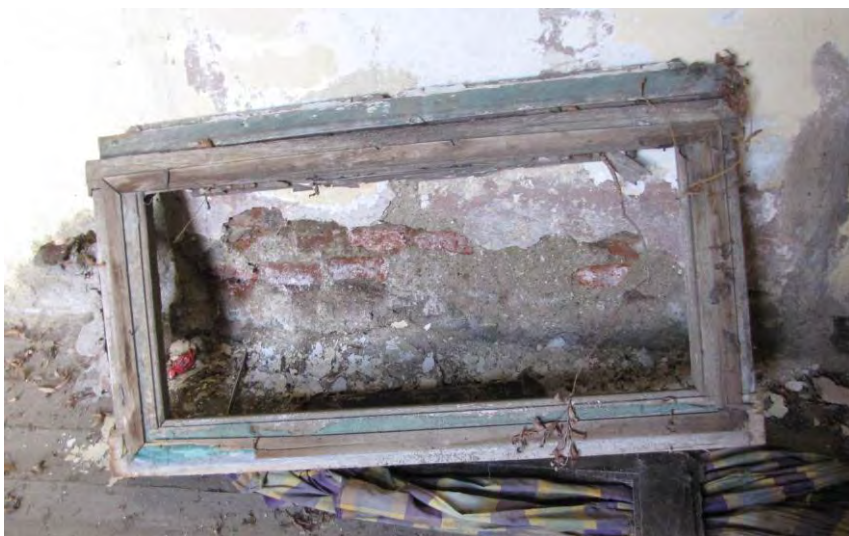
86. Banderola recortada de una puerta, ubicada en el derrumbe del Ambiente 3 y recuperada.
