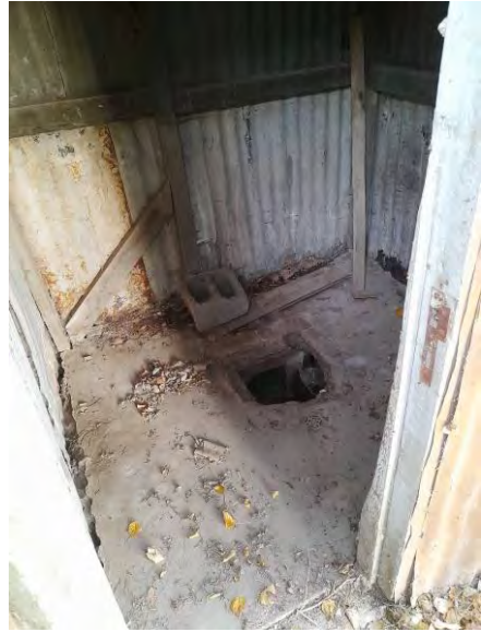
107- 108. Interior de la letrina, se observan modificaciones en la estructura de soporte hecha de madera, quizás producto de haberle puesto un nuevo piso de hormigón.
