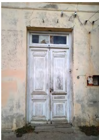
73- 74. Puerta y ventana de la fachada, originales, que han resistido a la intemperie. Ambas de dos hojas y banderola superior.
