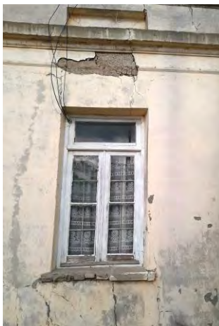
73- 74. Puerta y ventana de la fachada, originales, que han resistido a la intemperie. Ambas de dos hojas y banderola superior.
