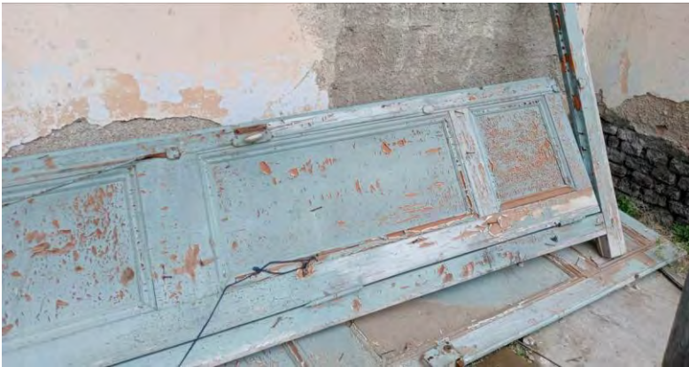
77- 79. Tres hojas de puertas de dos batientes, una con el lustre antiguo, con y sin tableros, del interior de la casa.
