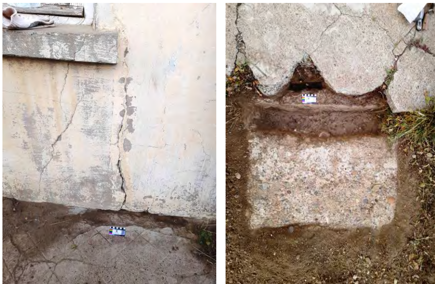
41- 42. Base del muro de la fachada y de su cimiento de piedra. A la derecha: calle y veredas originales y el sistema constructivo utilizado en origen.
