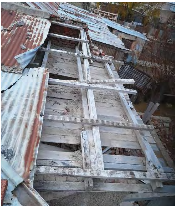
54. Estructura de la techumbre y la cubierta de chapas de zinc.
