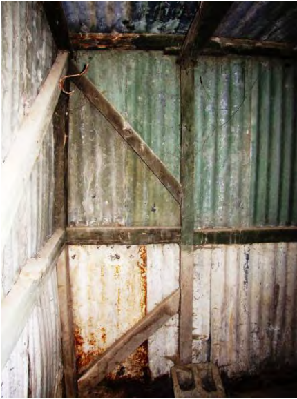
107- 108. Interior de la letrina, se observan modificaciones en la estructura de soporte hecha de madera, quizás producto de haberle puesto un nuevo piso de hormigón.
