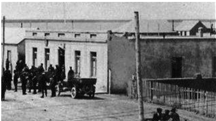
37. La comisaría durante los sucesos de 1921, estaba construida la vereda. Se nota que hay dos escudos sobre la puerta, uno mal colocado.
