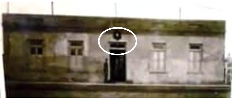
39. Vista del frente del edificio mientras era comisaría, con la vereda y unos postes en la parte superior. Tiene un único escudo a diferencia de la fotografía precedente (Museo de los Pioneros).
