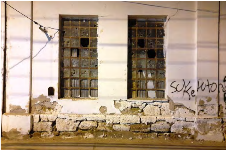
52. Cimiento de piedra en una construcción de la ciudad, hecho para evitar la subida de la humedad. También se usaron piedras en parte de la mampostería.
