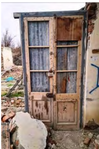
82- 83. Puerta a la galería: en la entrada al Ambiente 7 colocada de manera invertida para ser usada como cierre. A la derecha, se ve la puerta del Ambiente 8 en 2016, similar pero no igual a la anterior. Es notable el deterioro en seis años.
