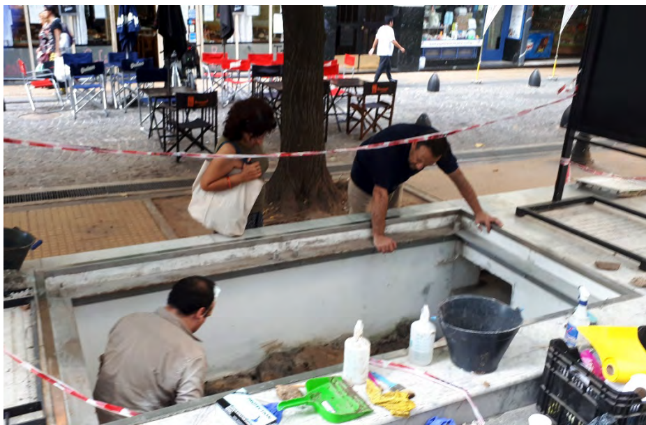
Vecinos observando los trabajos de limpieza de la estructura
