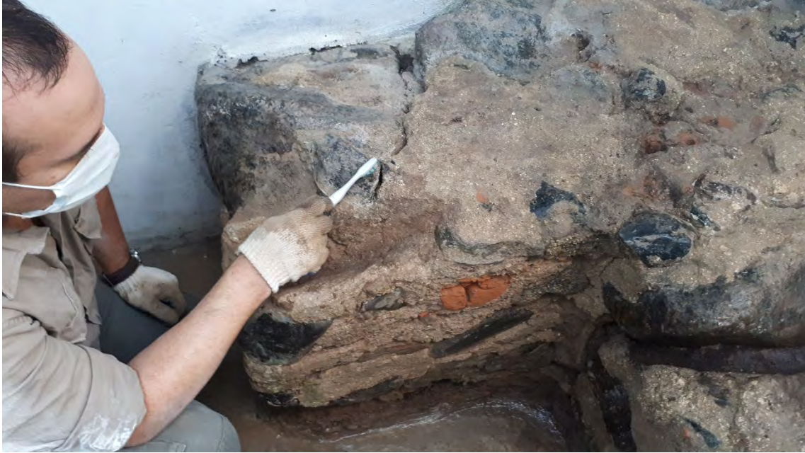
Limpieza de la piedra con herramientas adecuadas, sin producir marcas
