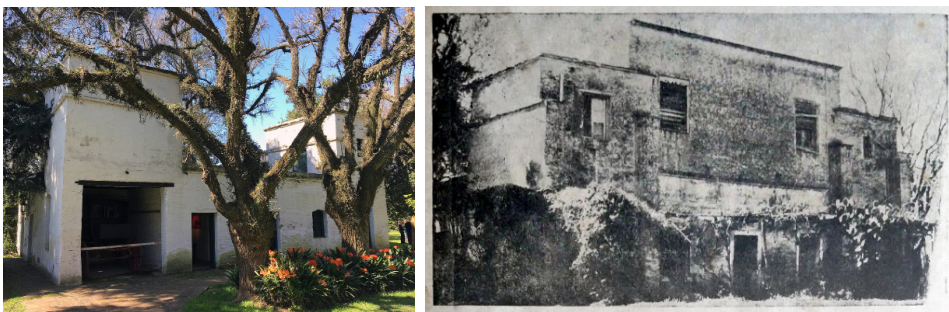
Figura 2. Vistas de la fachada sudoeste de la Casa de Chacareros en la actualidad (izquierda) y como se encontraba antes de la restauración (derecha). Fuente: Autor, 2021; c. 1940 (Actis, 1949, p. 40).
