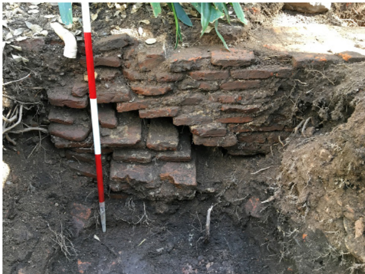
Figura 5. Perfil sudoeste del sondeo 1 donde se observa un muro de cimiento construido en ladrillos asentados en mortero de cal.
