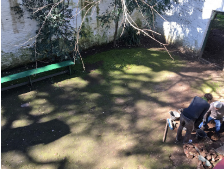
Figura 4. Vista general del patio al iniciar los trabajos en el sondeo 1.
