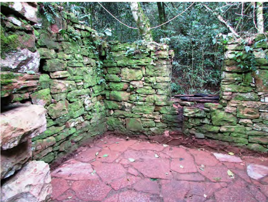
Figura 65. Interior de la habitación anexa con su ventana y el piso de lajas de piedra.
