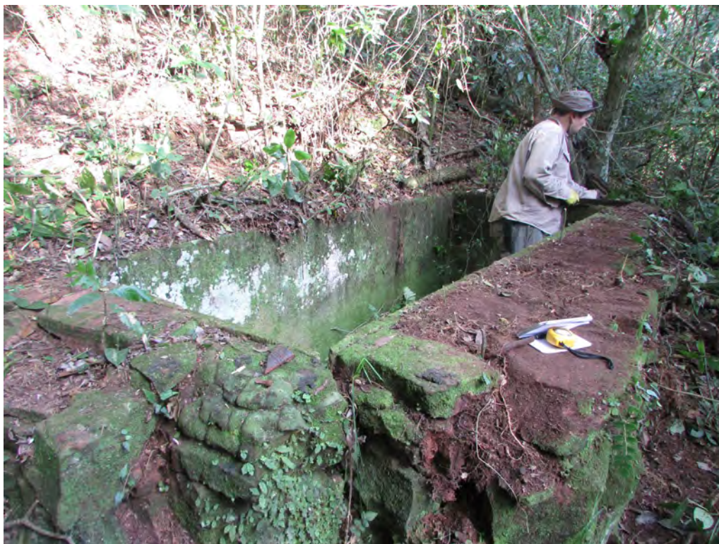
Figura 56. Gran reservorio de agua en la ladera del cerro que se estima la conducía a un tanque metálico en la cocina, para darle presión para la ducha y canillas.
