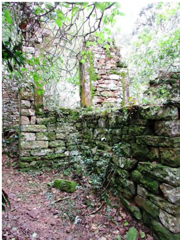
Figura 63. Vista de la fachada del edificio; el sendero estrecho y la vegetación impide la visión desde el frente de cómo se desarrolla hacia atrás.
