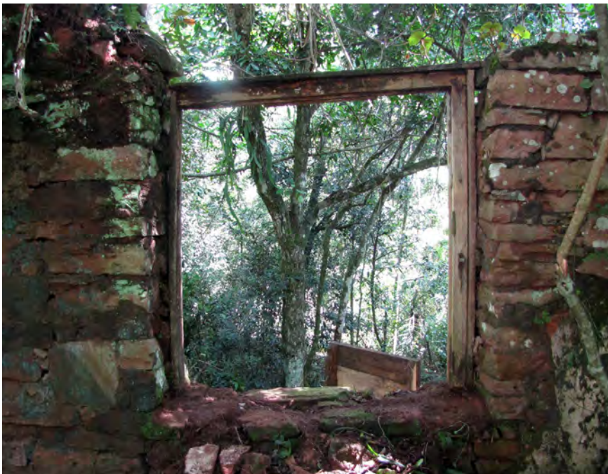
Figura 60. Única ventana de la Estructura I que aun tenía el marco completo; el contramarco estaba unido a la pared por las espigas de hierro.
