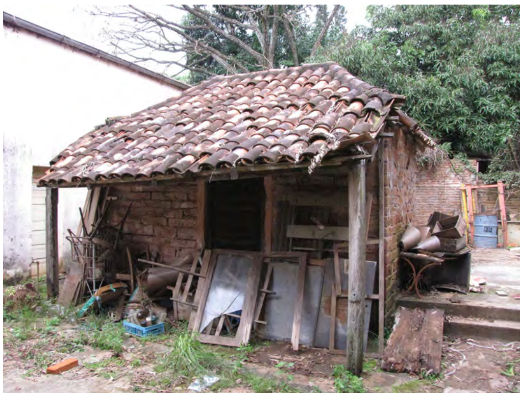
Figura 182. Una de las casas más antiguas del centro de San Ignacio, posiblemente hecha hacia 1900; aunque modesta, los muros presentan hiladas de piedras con aparejo de calidad.
