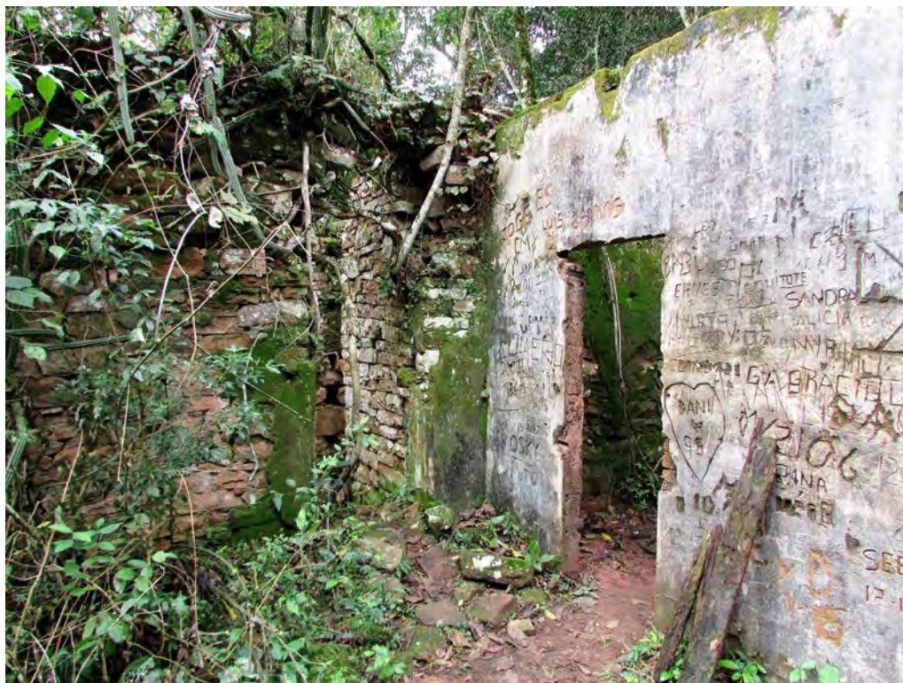
Figura 45. Ángulo interno en que se unen uno de los muros de piedra a la vista con otro de ladrillos, en la puerta que conecta la casa con el anexo lateral.
