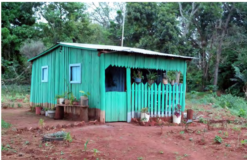
Figura 37. Casa de tablas de madera sobre basamento de piedra con galería frontal, típica de la arquitectura maderera regional, las tejas de madera han sido reemplazadas por chapa galvanizada.
