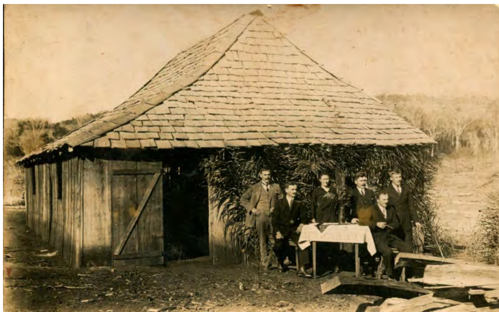
Figura 176. Casa pionera regional en obra: nótese la remoción de la vegetación en torno a la vivienda hecha con paredes y tejas de madera (Colección privada, Buenos Aires).
