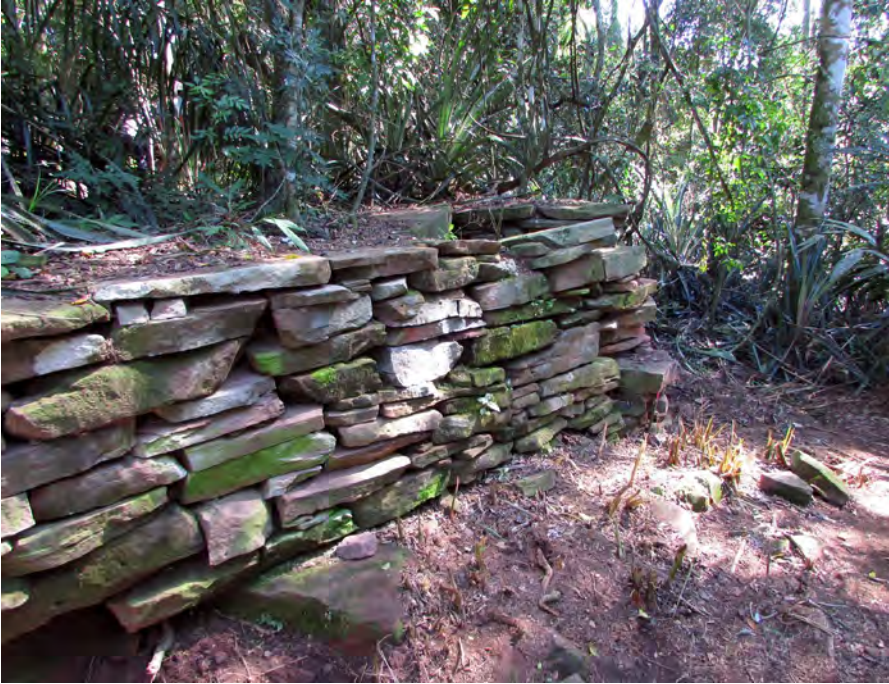
Figura 126. Basamento de la Estructura III, el aparejo de piedras es de simple apilamiento.
