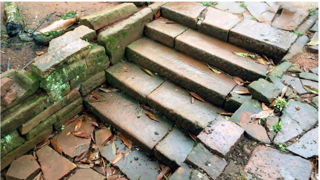
Figura 189. Escalera en una casa hecha en piedra: nótese la cuidada terminación que tuvo y que mantiene después de un siglo de uso al aire libre.
