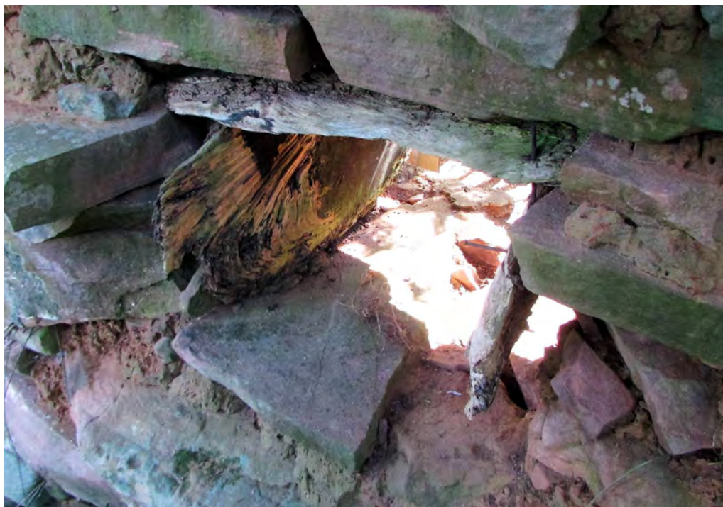
Figura 129. Perforación del muro en el recinto menor, que debió servir como chimenea de la cocina.
