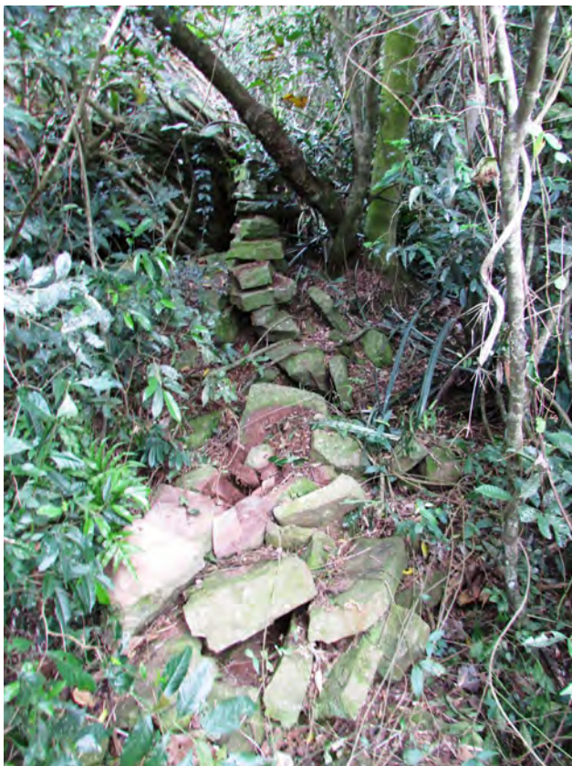
Figura 26. Muros que descienden hacia el río y penetran en él, que fueron parte del sistema de la zona noreste. La foto está tomada desde el agua y después de cortar la vegetación que la cubría.
