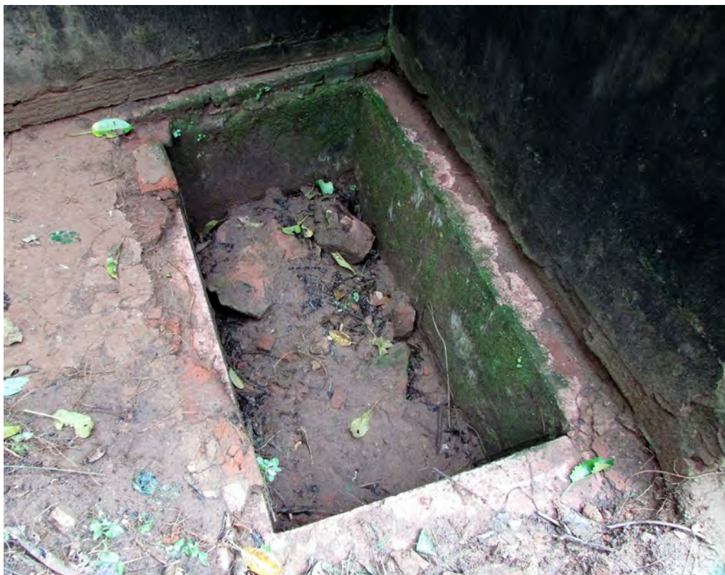
Figura 46. La heladora de la casa, espacio subterráneo en la cocina para guardar alimentos a temperatura constante.
