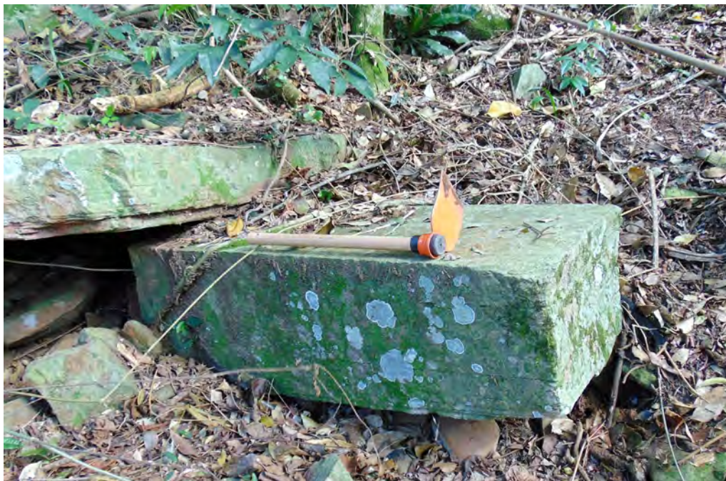
Figura 35. Sillar de buena manufactura abandonado entre la cantera y las estructuras.
