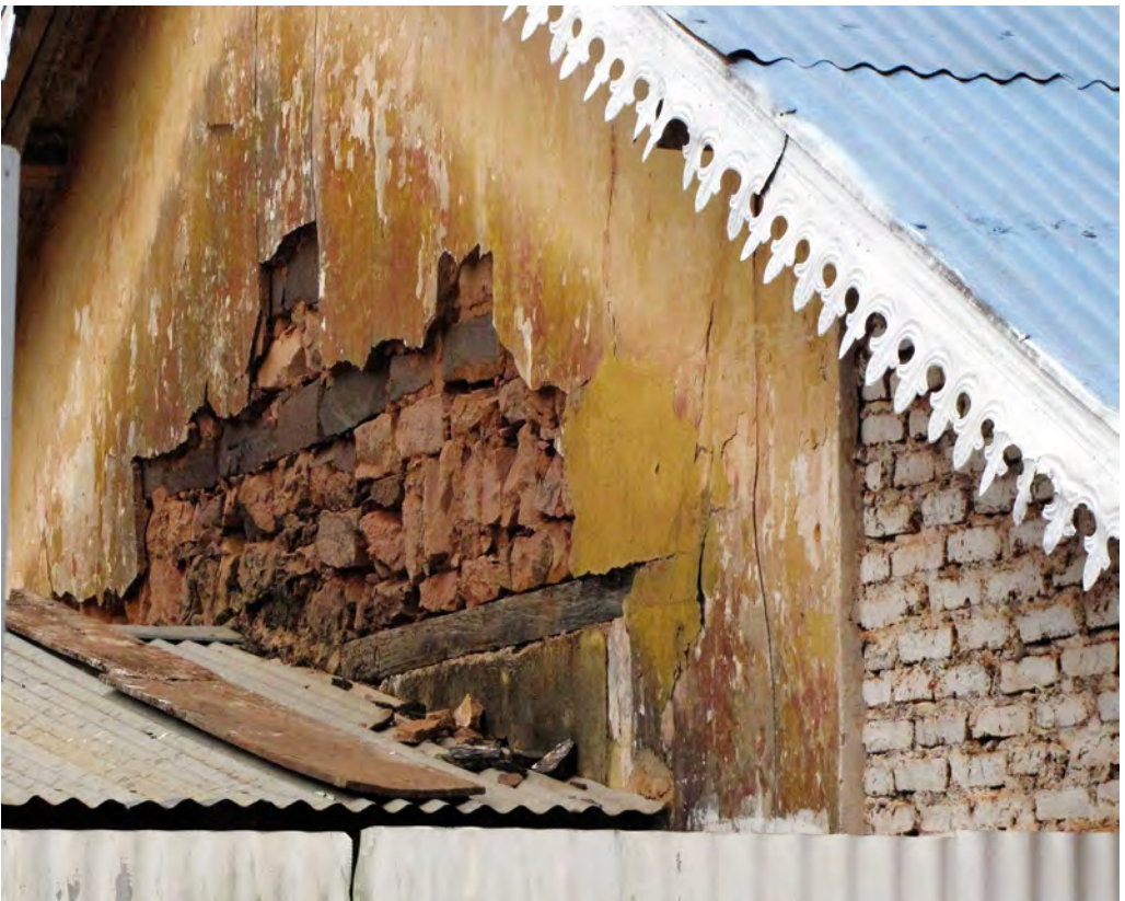
Figura 184. Detalle del sistema constructivo europeo de maderas y piedra utilizada en el almacén.
