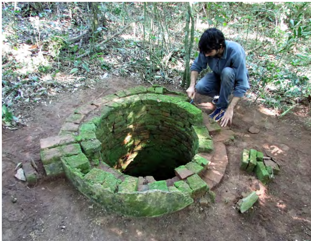
Figura 165. El aljibe del que queda la parte inferior del brocal, era una estructura compleja cubierta con ladrillos hasta el fondo, revocada al exterior.
