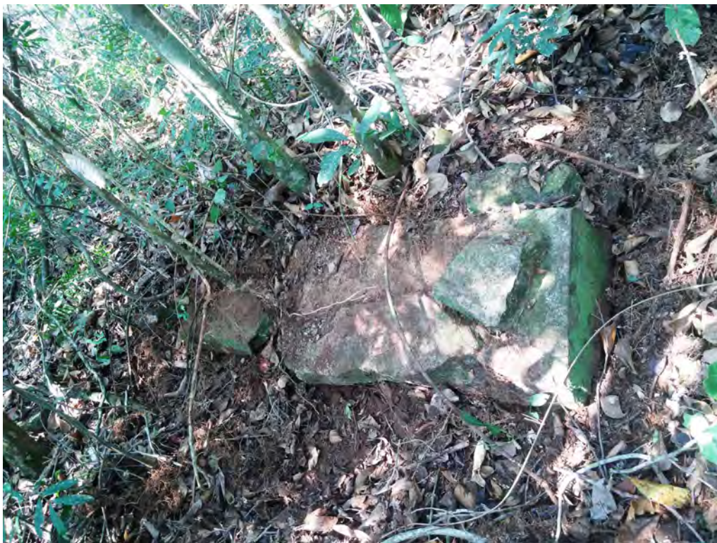
Figura 151. Piedras del basamento frontal de una de las viviendas del grupo G en las que se observa la destrucción a sólo veinte años de su abandono.
