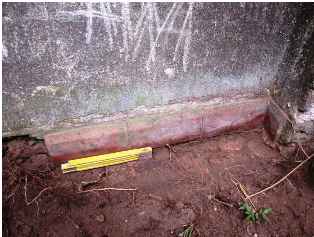
Figura 57. Fragmento del zócalo de la casa, en este caso color rojo, que envolvía los pisos de toda el casa.
