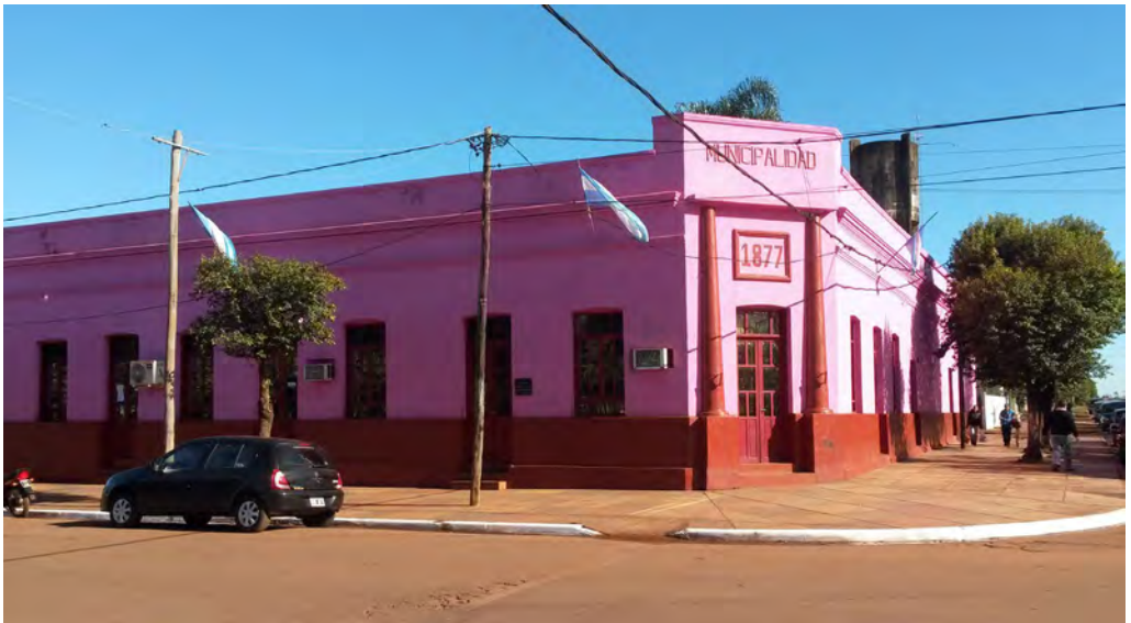
Figura 178. Las instituciones: municipio de San Ignacio, pese a la fecha en el frente fue construido en un estilo anticuado y académico en 1928.
