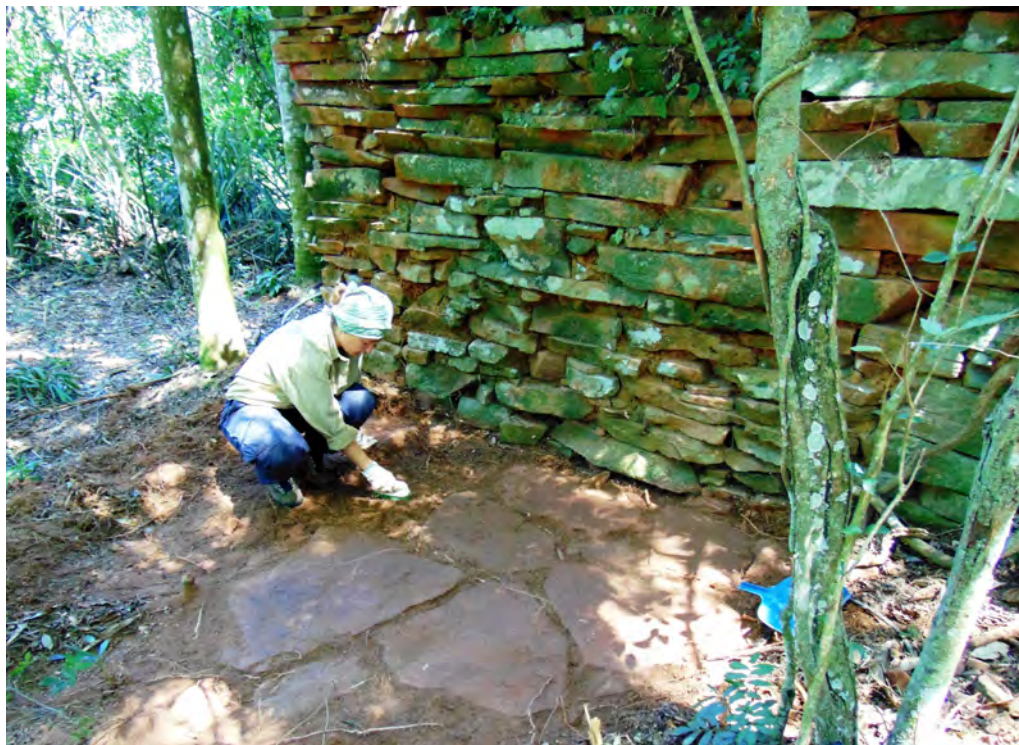
Figura 130. Piso del exterior de la Estructura III durante su limpieza, nótese el aparejo de piedra de las paredes como simple superposición de lajas.
