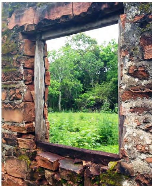
Figura 61. Contramarco de madera del sistema utilizado por la inmigración alemana en las casas hechas de piedra en San Ignacio, hacia 1900, sin espigas y colocadas después de hechos los muros.
