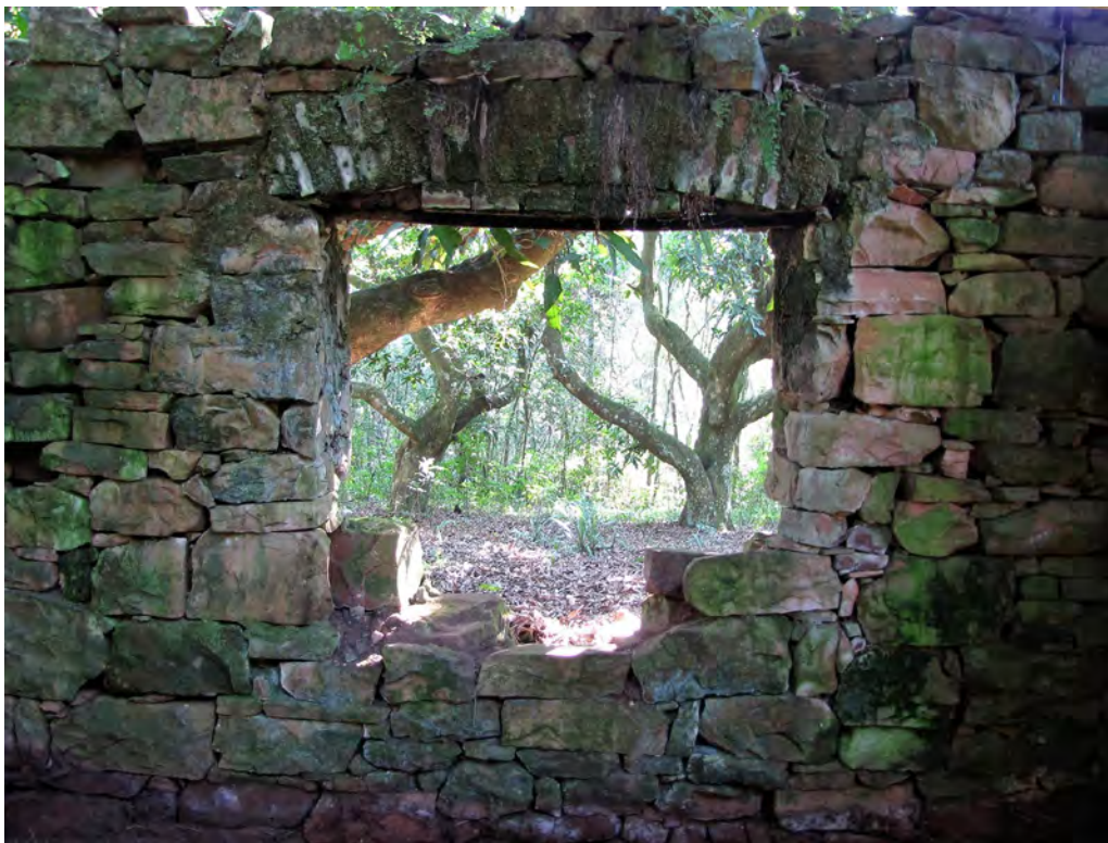
Figura 162. Muro frontal con su posible ventanal. Es visible el sistema de soporte del dintel mediante un arco rebajado.
