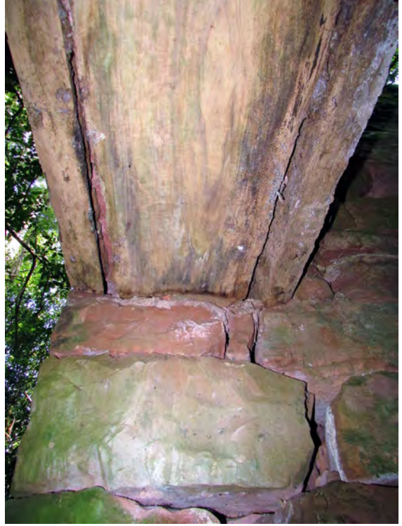
Figura 94. Dintel de la entrada, sin evidencias de haber tenido una puerta, armado con una tabla y dos tirantes de madera.
