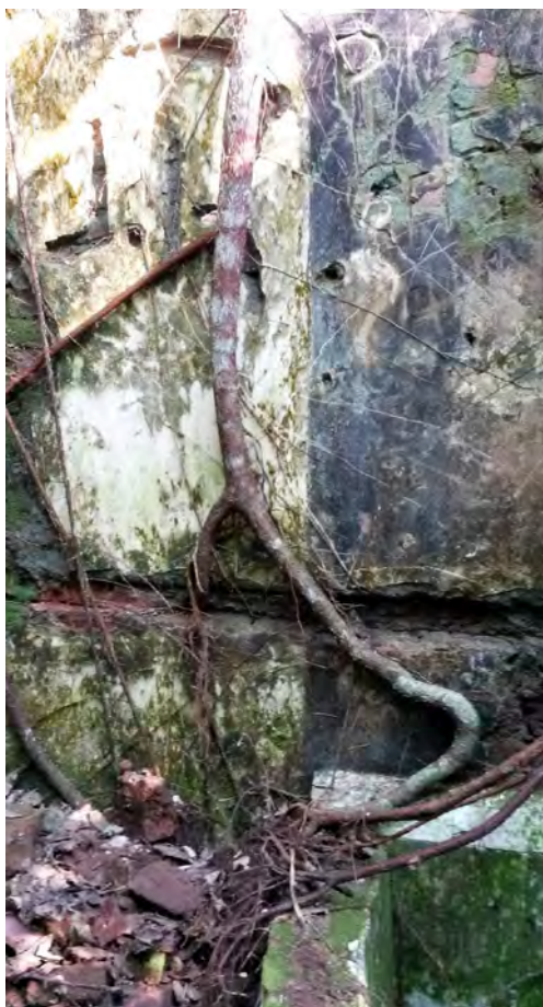
Figura 52. Pintura de color azul Prusia sobre las paredes de la bañera, el resto era blanco.
