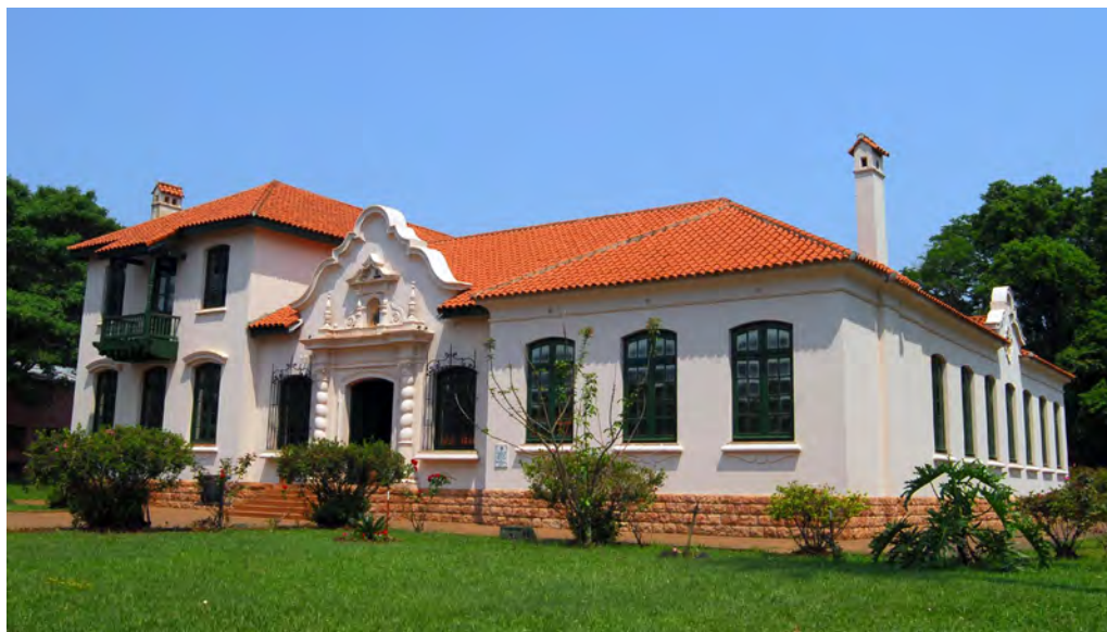
Figura 179. Las instituciones: arquitectura en estilo Neocolonial frente a las ruinas de San Ignacio Miní, que se quería imponer en la década de 1930-40.
