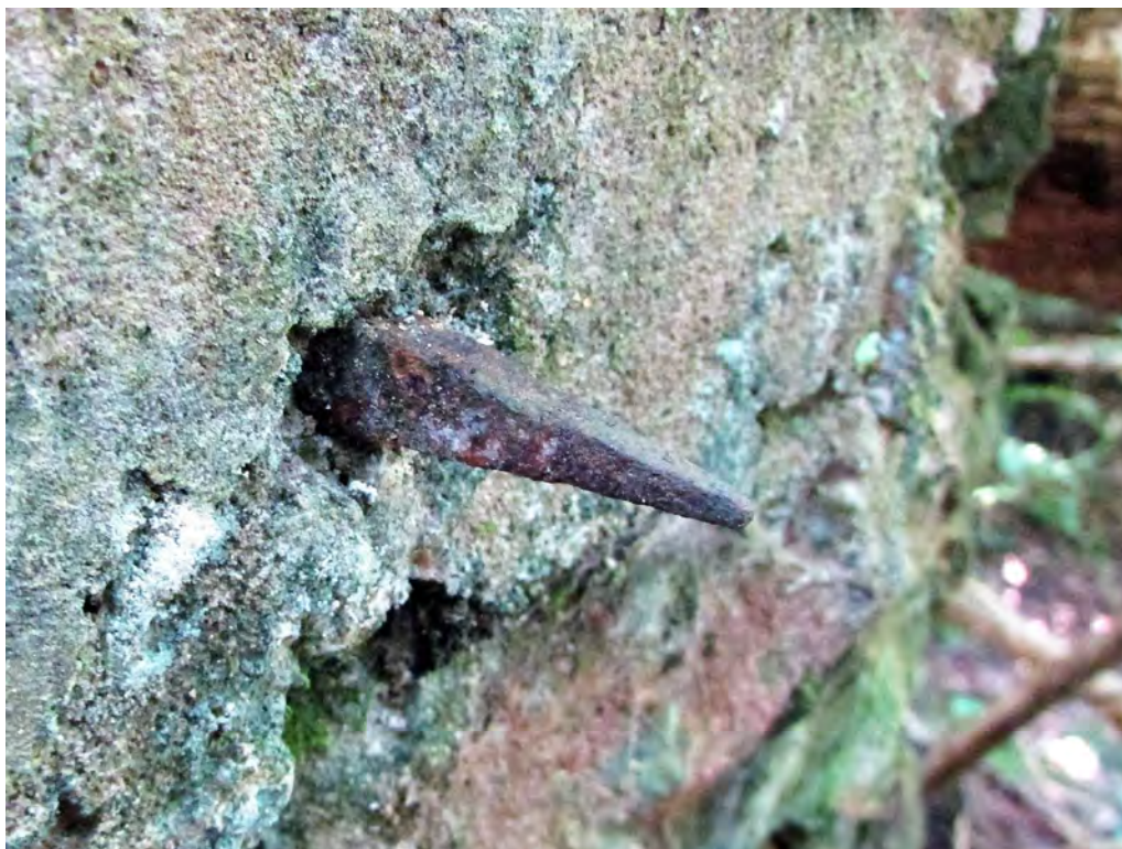
Figura 58. Extremo visible de un gancho industrial de soporte (espiga) de las ventanas y puertas, colocado entre las piedras de los muros durante la construcción.
