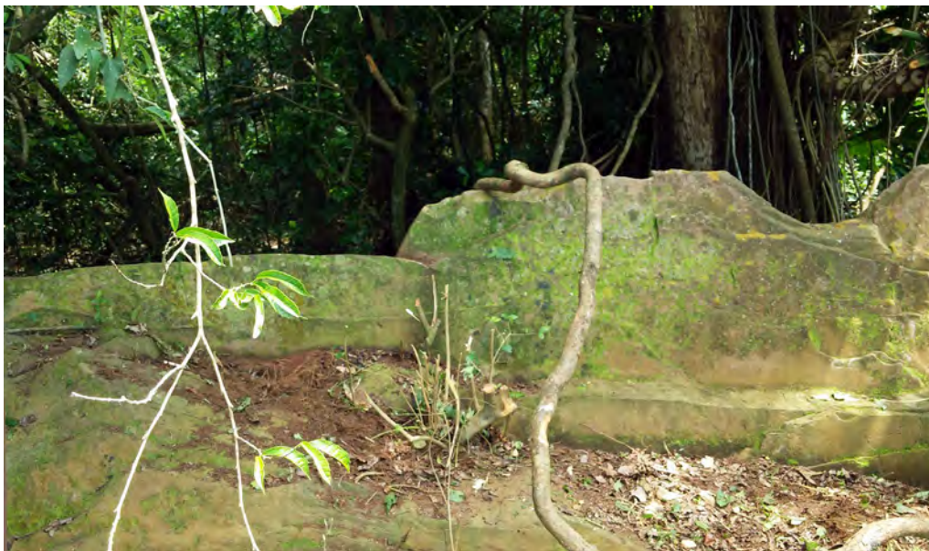
Figura 32. Sección del parapeto visto desde el río. Aunque se encuentra en la orilla desde el año 2000, antes de la modificación de la altura del agua estaba alejado y cubierto por vegetación. Una parte ha quedado cubierto por la arena del río y la altura visible actual es de 1.35 metros.
