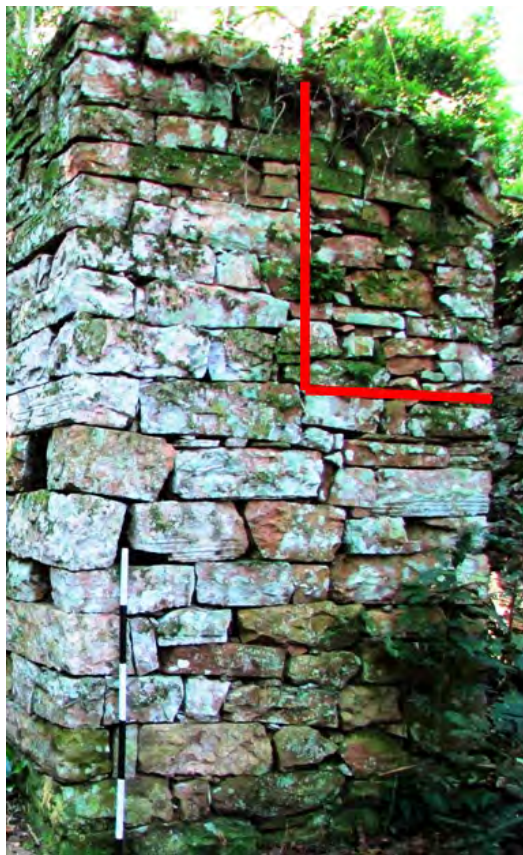
Figura 66. Uno de los muros de piedra del edificio con una marca que muestra un cambio en el criterio constructivo y el empleo de bloques de menor formato.
