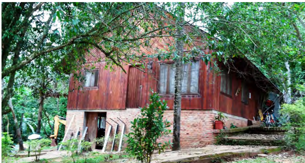
Figura 99. Casa en el Club de Río que reproduce el modelo de la Estructura II aunque hecho con lógica constructiva salvo por la puerta no funcional del lateral del primer piso.
