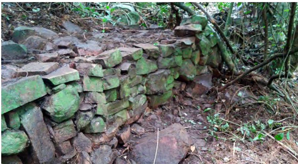
Figura 27. Muros de las terrazas de la Estructura XI; una vez limpios, se detectó un irregular piso de piedras. La pared que soporta está inclinada y es más ancha en la base.
