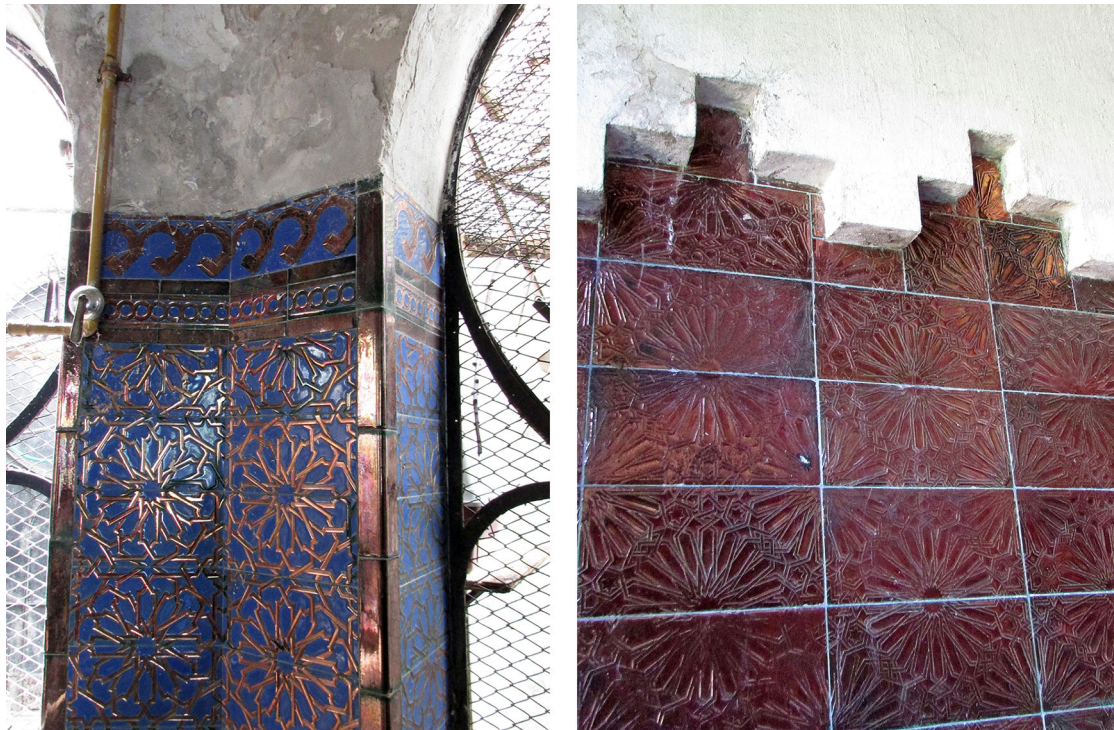
FIGURA 1. Interior del Pabellón de los Loros en el Jardín Zoológico de Buenos Aires. Detalle del revestimiento de azulejos sevillanos de arista con reflejo metálico (fotografía del autor, 2017)
