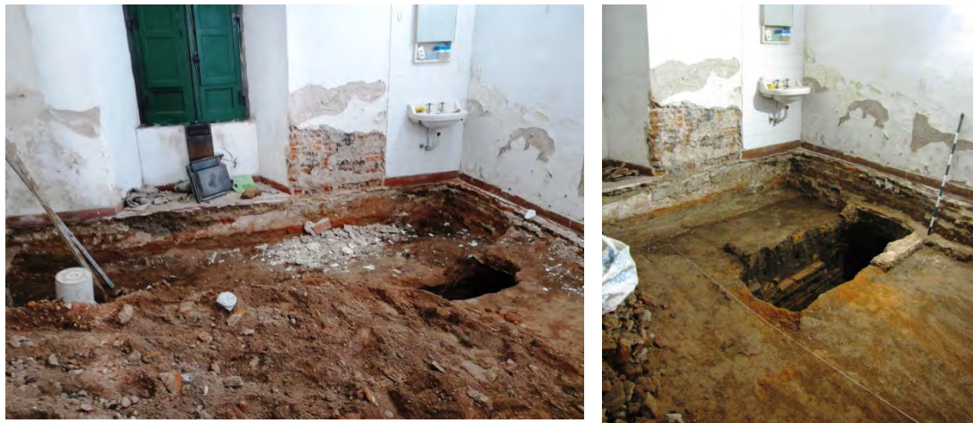
Celda 1 antes de iniciar los estudios y después de su limpieza. Nótese la cámara vacía con los restos de muros en su interior, anteriores a su construcción y a la de las celdas, y las evidencias de una cubierta superior.
