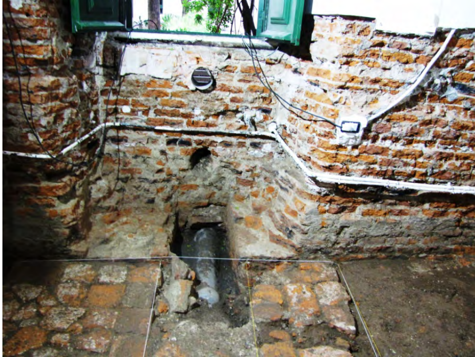
Cañería de cemento que atraviesa la celda, puesto seguramente en las obras de 1964, cuya zanja destruyó parte de los cimientos de las estructuras precedentes.
