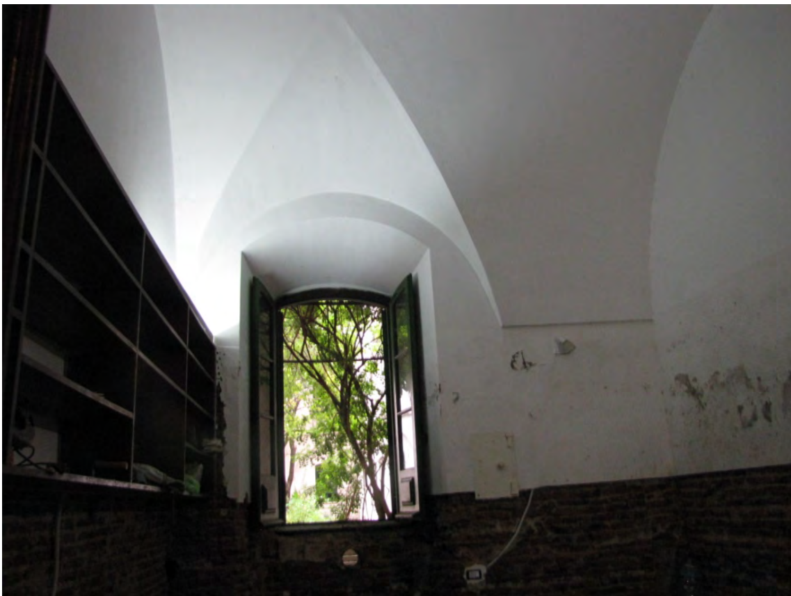
Asimetría de la bóveda y la ventana de la Celda 3, pruebas de la alteración volumétrica del lugar. En origen las celdas debieron ser parte de una única estructura destruida en 1827 y reparada después de 1836.
