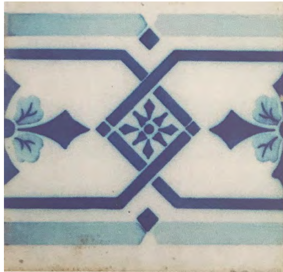
Fragmentos de azulejos provenientes de la Celda Nro. 3, recogidos durante las obras, que por su cantidad debieron formar parte de uno de los muros antiguos, en que se combinaban guardas pintadas de azul con paños de color blanco. Proviene de España y deben corresponder a las obras hechas a fines del siglo XIX (Cortesía de Fray Fernando Aquino y Francisco Girelli).
