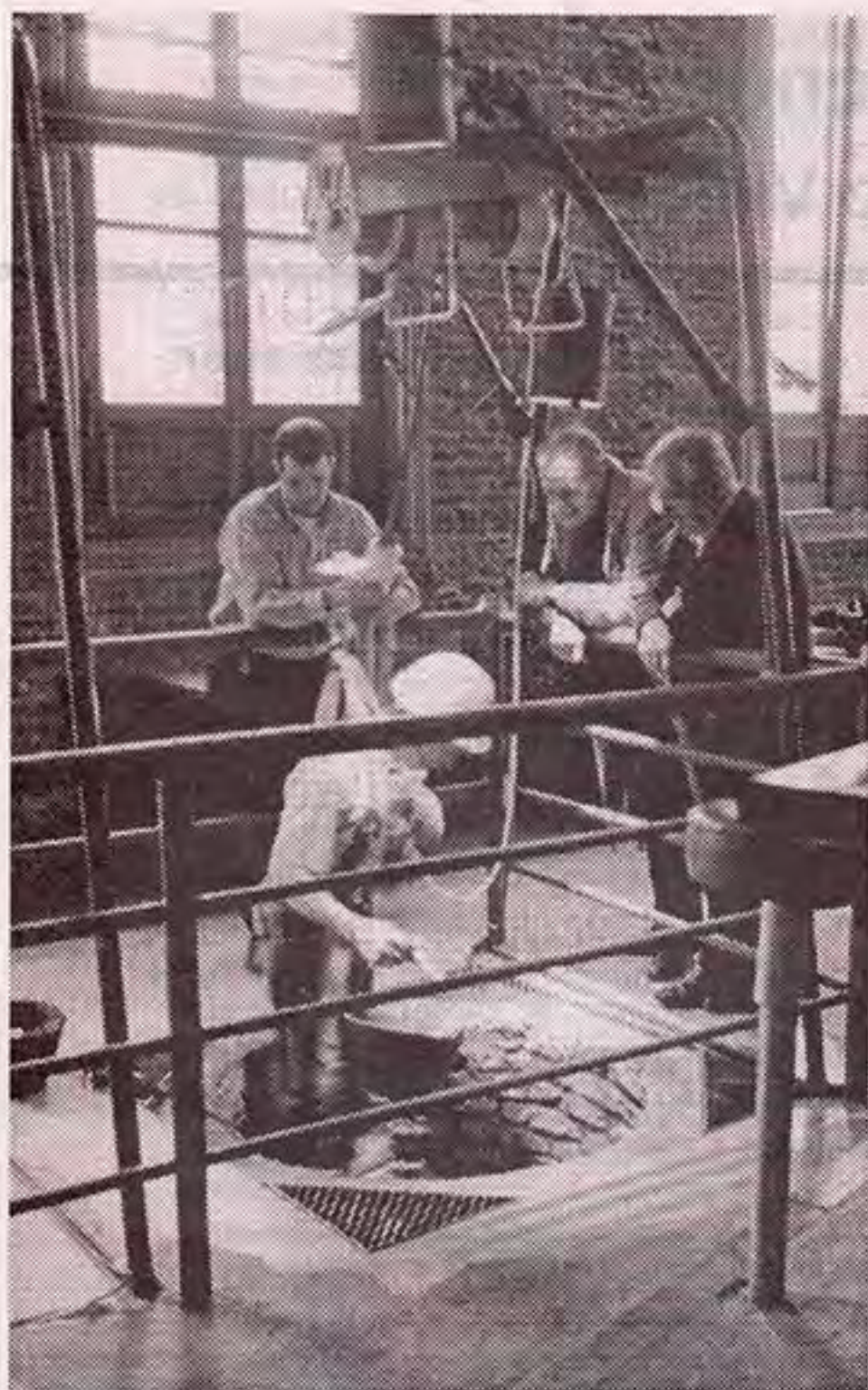
Sistema de grúa para el descenso de los excavadores al fondo del pozo con equipo de alta seguridad.
